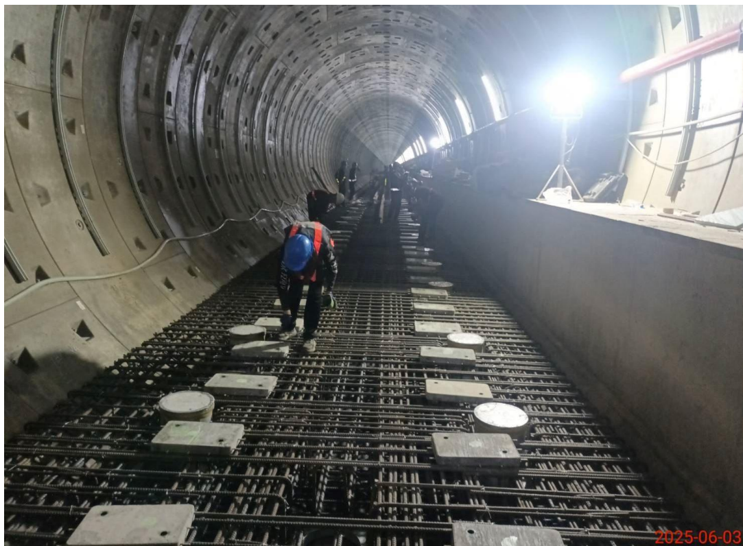
G11-G12 站間軌道施工
