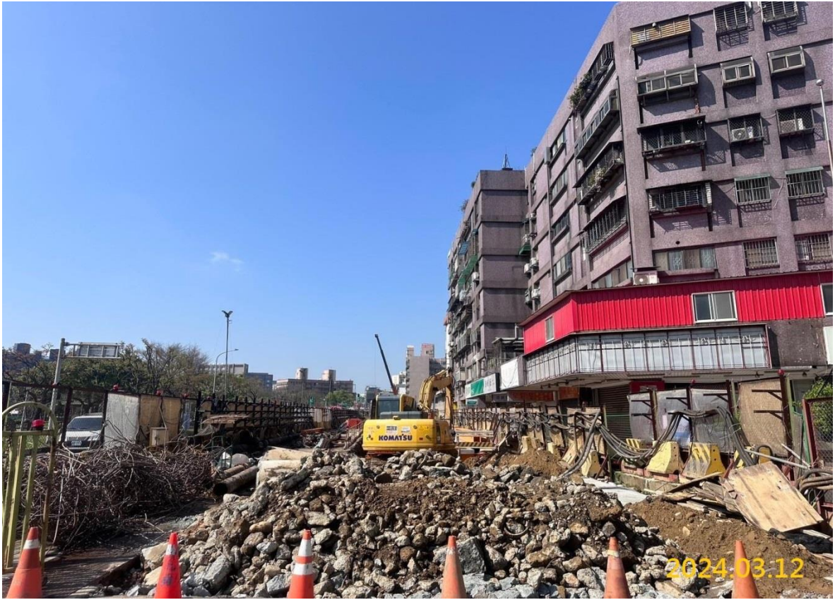
G06 站淺挖施作
