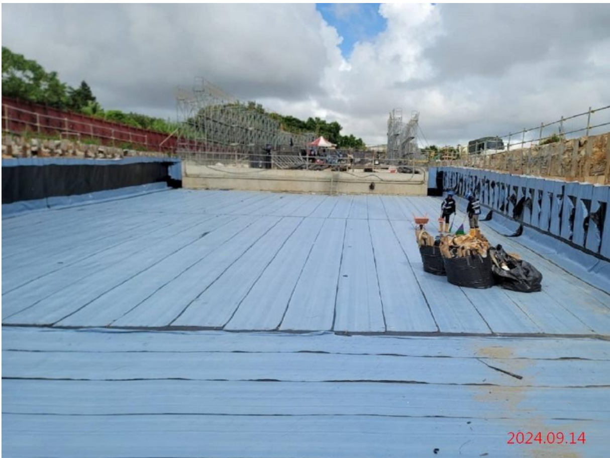
北出土段_結構防水膜鋪設
