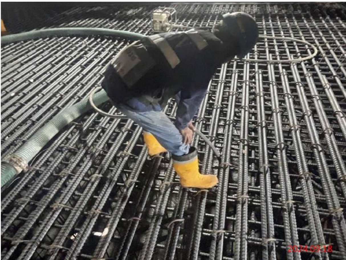
G10_站體頂版混凝土澆置
