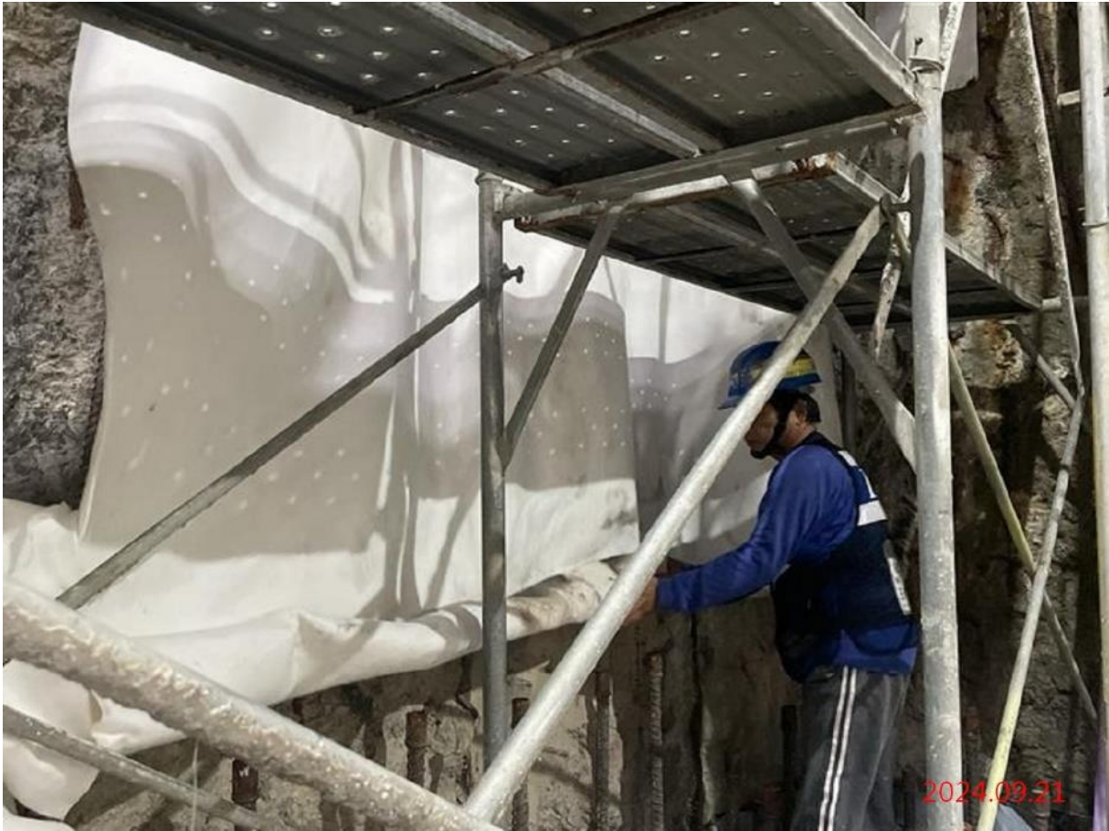
G09_B3F 側牆防水布鋪設
