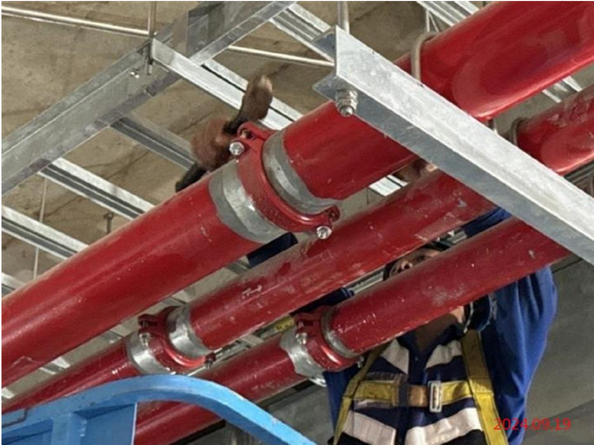
G11_站體穿堂層消防撤水管安裝
