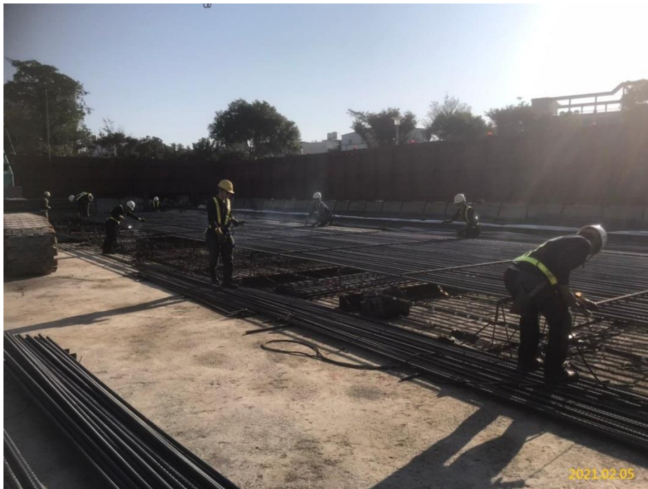
G06 站連續壁鋼筋籠施作
