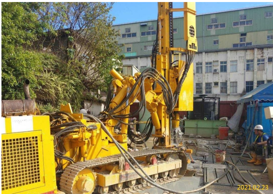
南出土段地盤處理鑽孔施作
