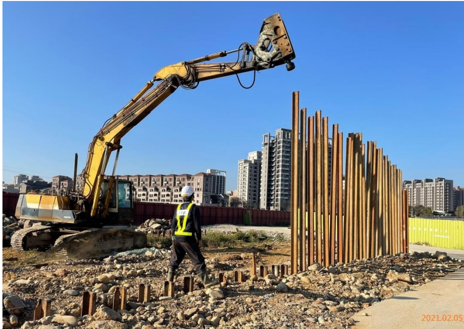
南出土段鋼軌樁打設
