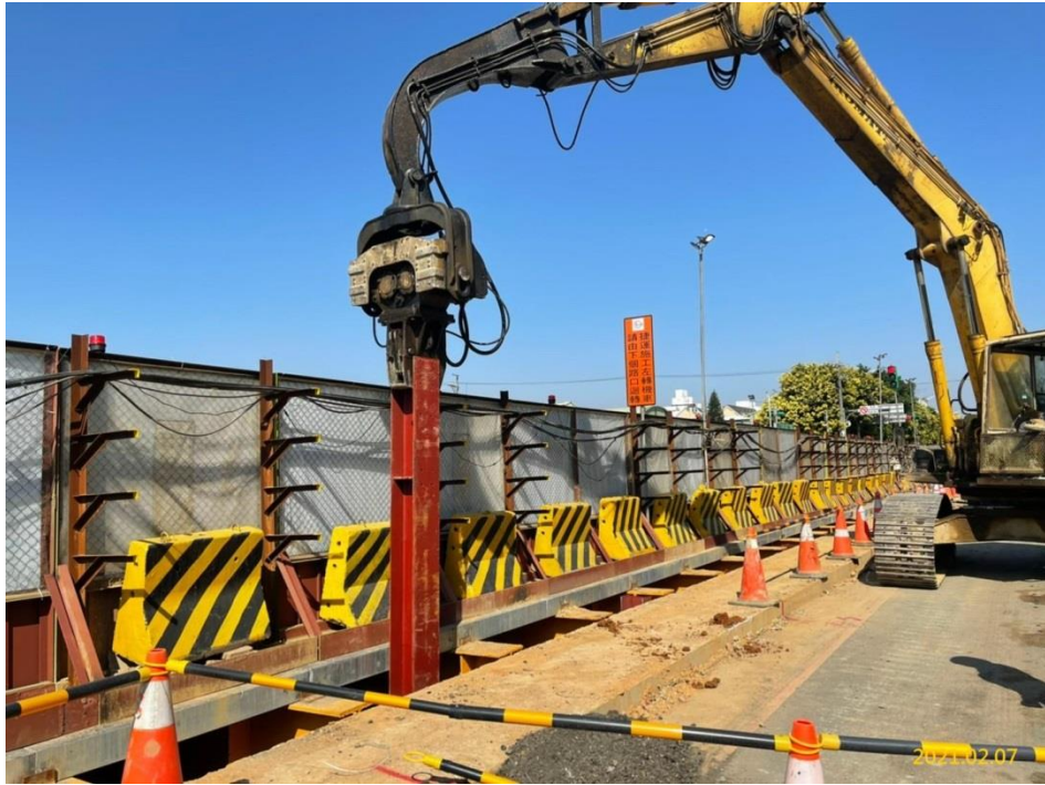
G03 站支撐型鋼樁打設
