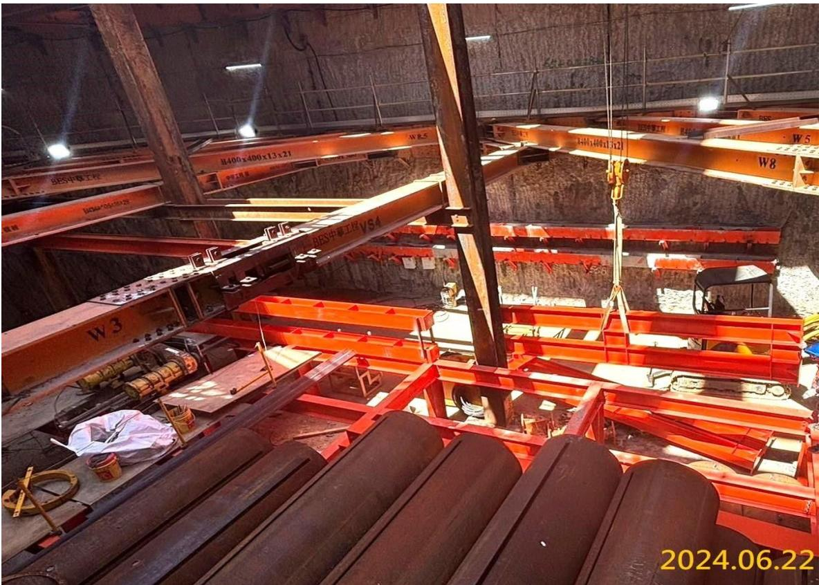
VS4 通風豎井管幕工程推進構台組裝
