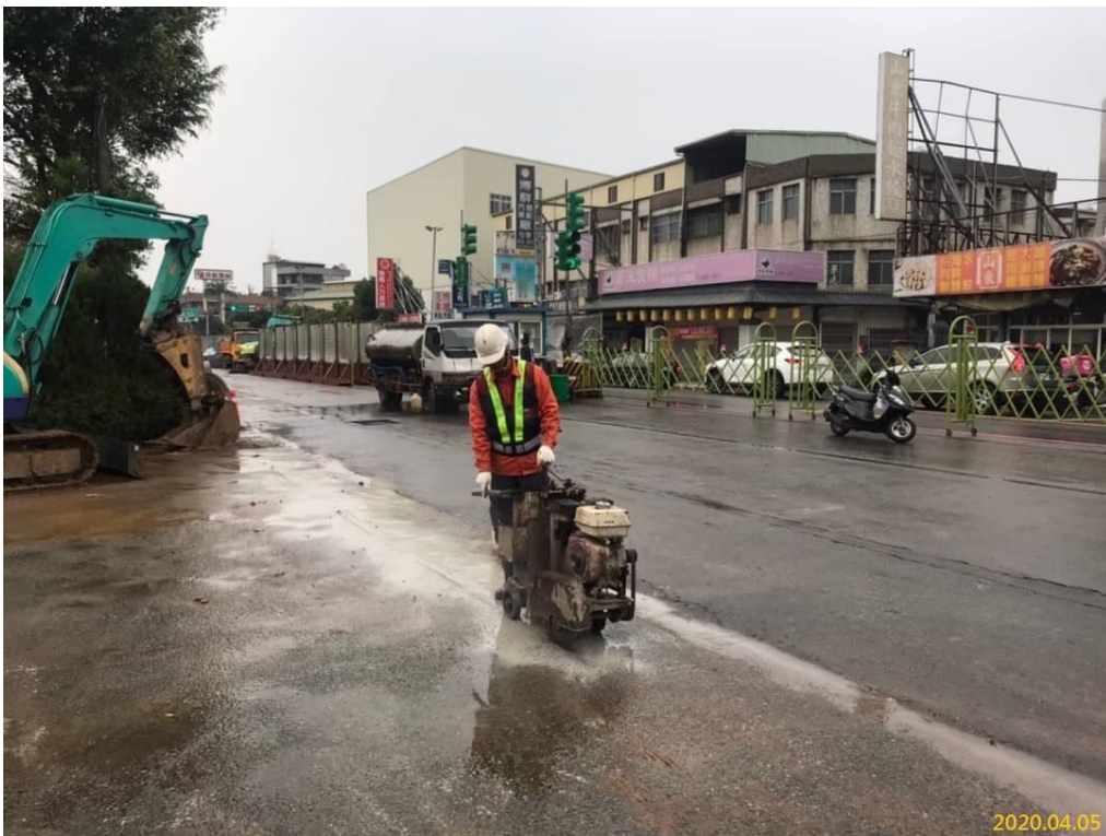
G03 站(巧克力街附近)臨時排水既有路面切割施作
