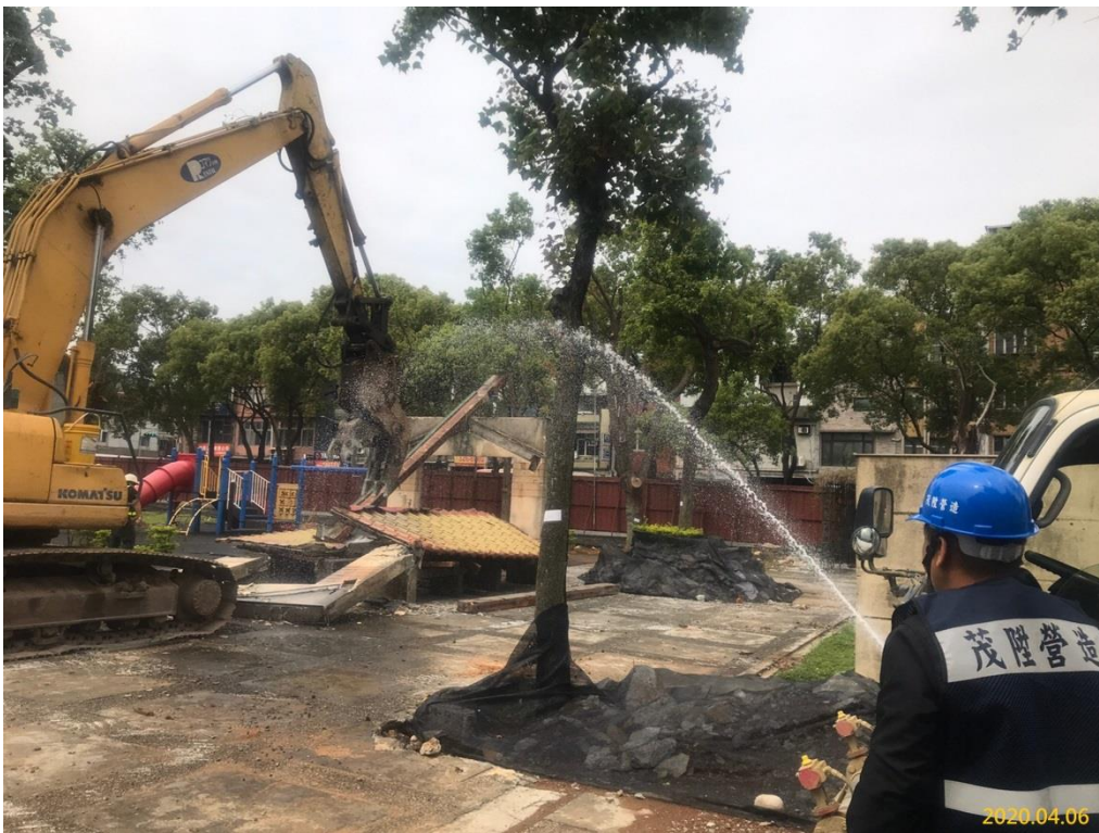
VS6 通風豎井(福豐公園)既有地上物拆除
