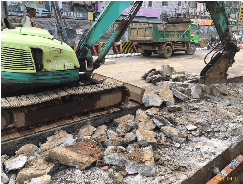
G03 站(巧克力街附近) 既有排水頂版破除
