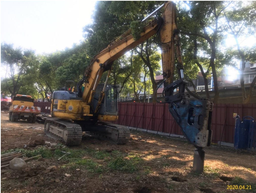
VS6 通風豎井(福豐公園)施工圍籬立柱基礎挖掘
