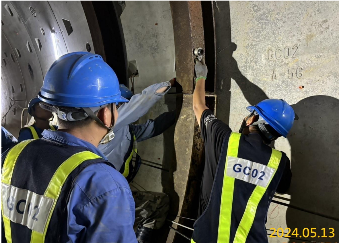
G03 站潛盾隧道發進前置作業
