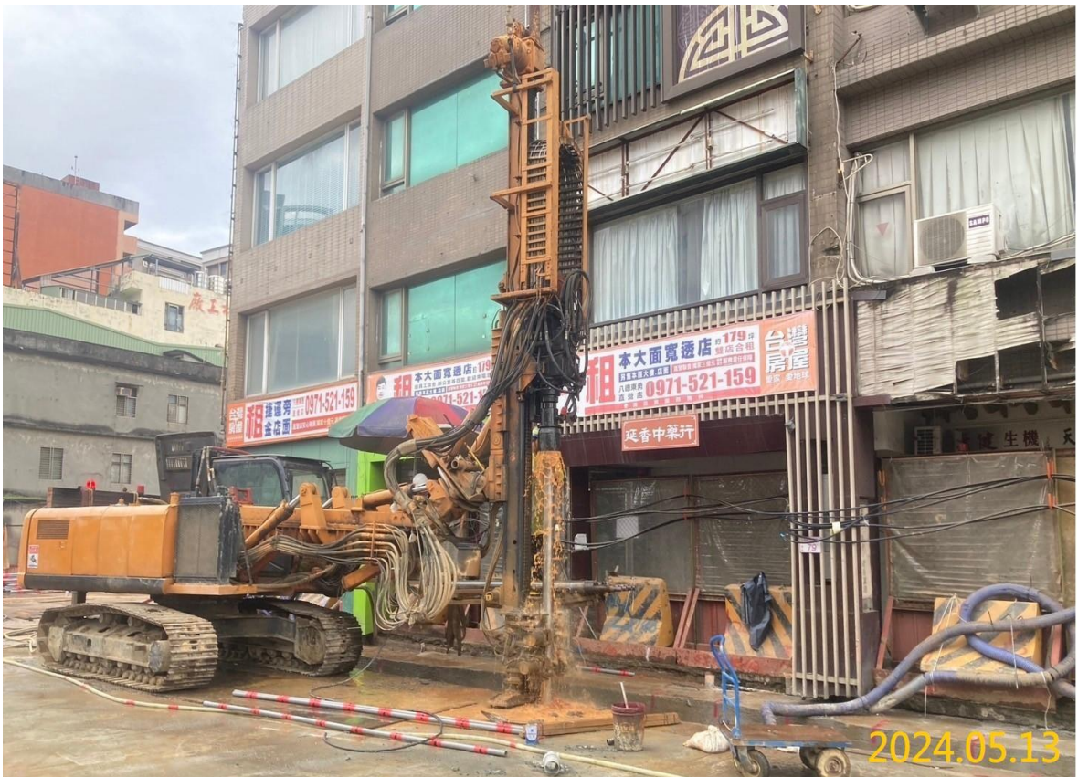
G04 站地盤處理施作
