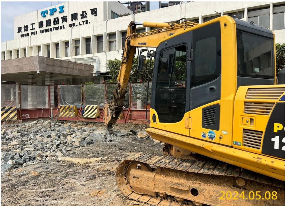
G05 出入口 A 鋪面破碎
