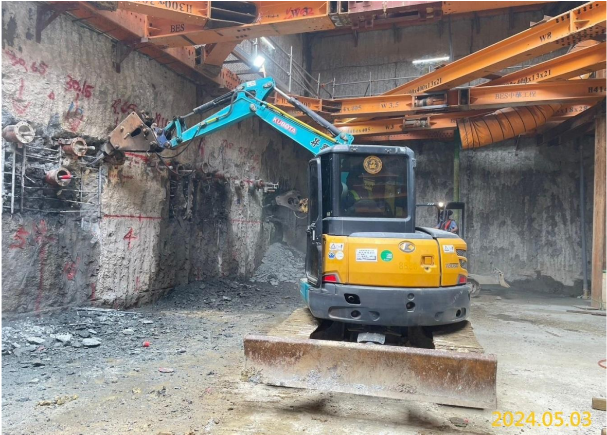
VS4 通風豎井管幕工程推進前鏡面框安裝
