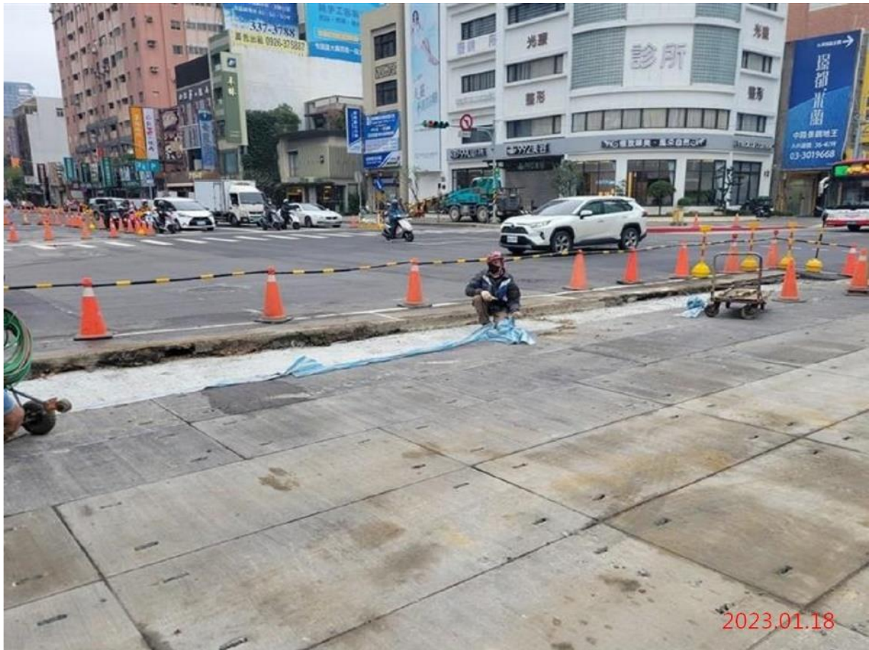
G10 站_北工區覆工系統施作(收邊)
