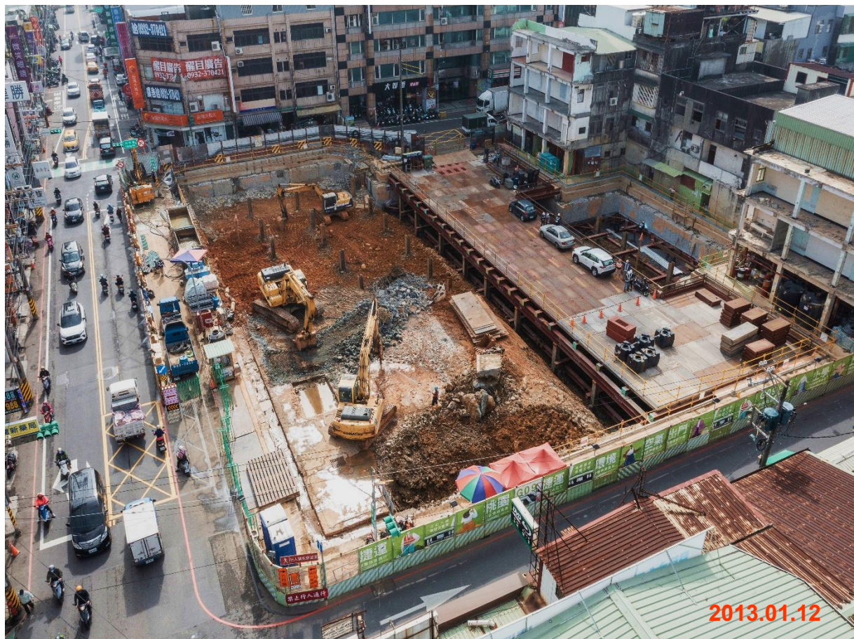
G09 站_站體開挖支撐及構台施作；中正路西側潛盾隧道連通道地盤改良
