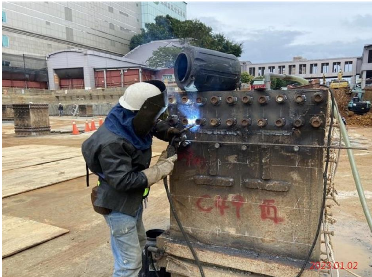
G07 站_逆打鋼柱續接器焊接
