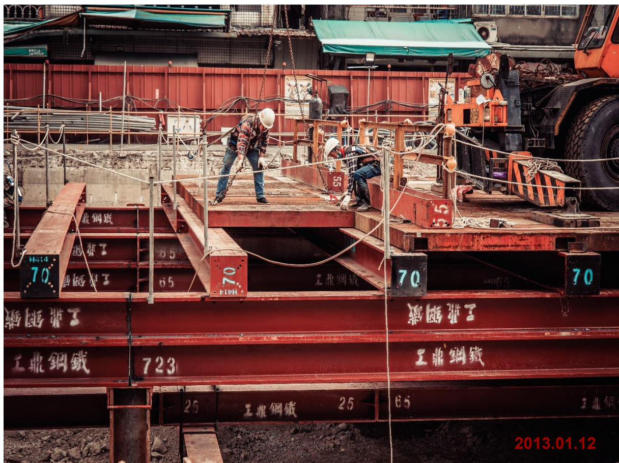
G08 站_站體第二區第一層支撐系統及構台施作
