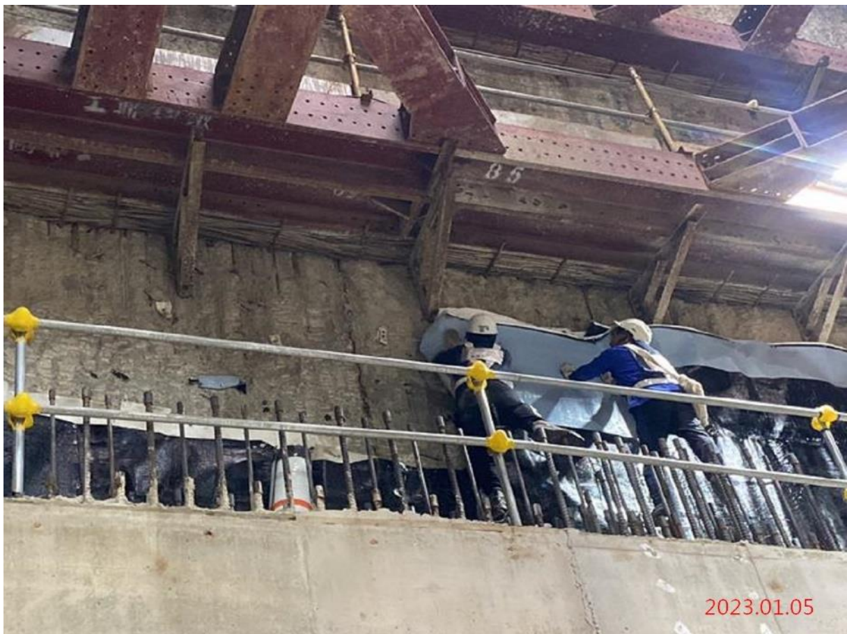
G11 站_站體軌道層側牆防水膜鋪設
