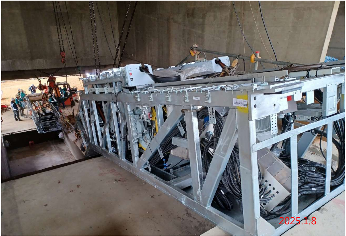
G31 站 1-2 號電扶梯吊裝作業
