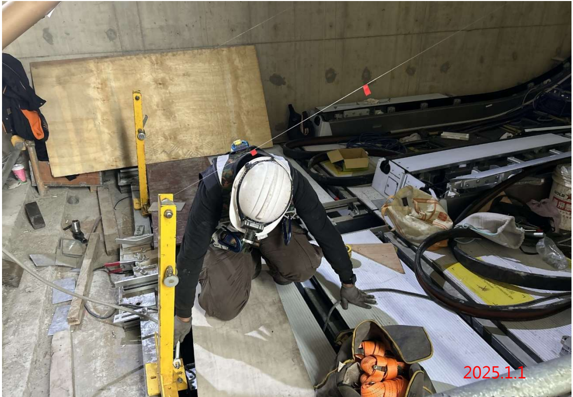
G13a 站 3-4 號電扶梯蓋板安裝，中心基準線放樣作業
