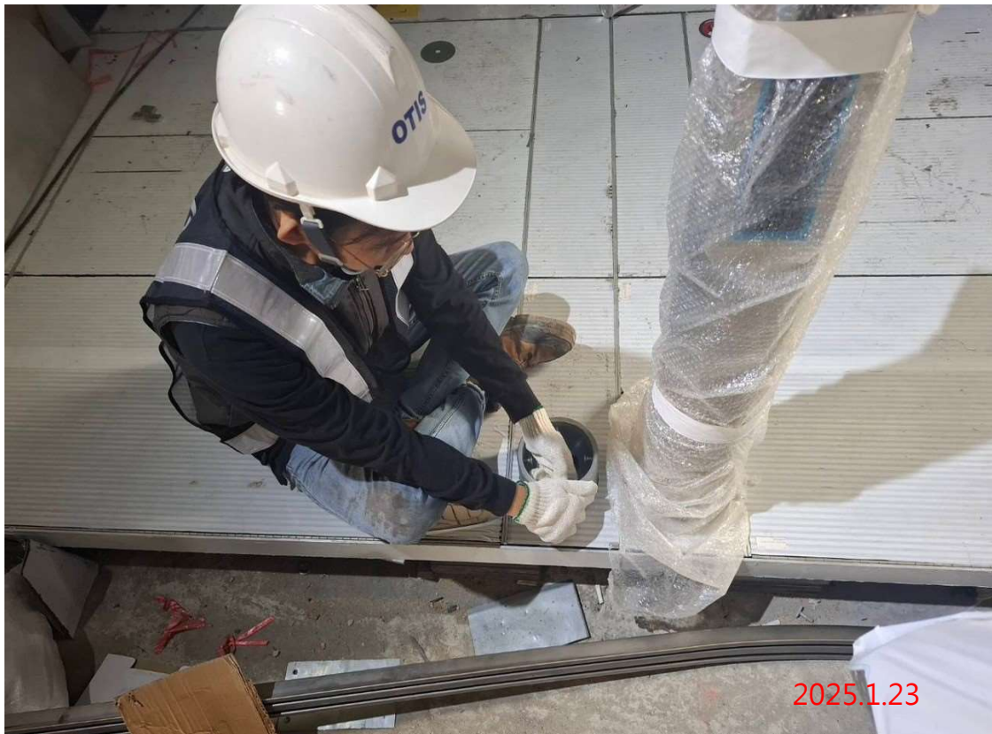
G31 站 5-6 號電扶梯高程調整作業
