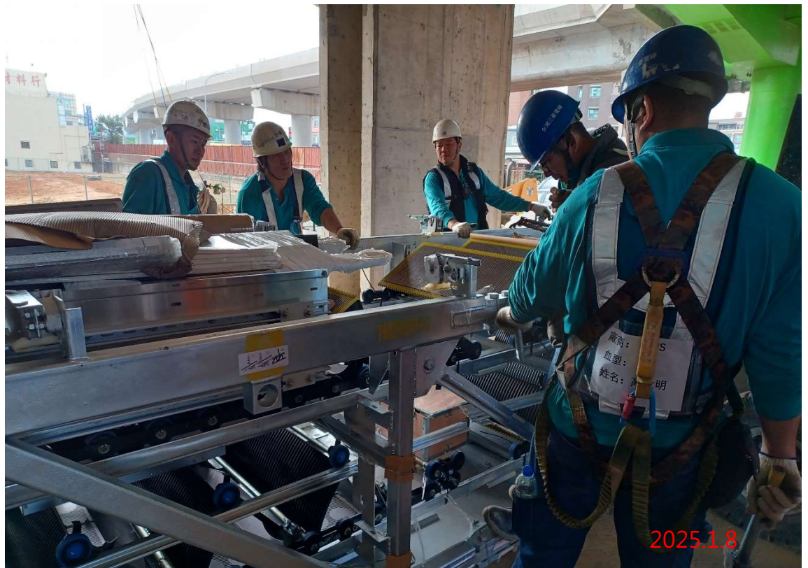
G31 站 1-2 號電扶梯吊裝作業
