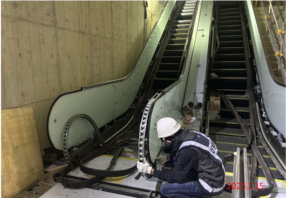
G13a 站 3-4 號電扶梯扶手玻璃調整及扶手軌道安裝作業
