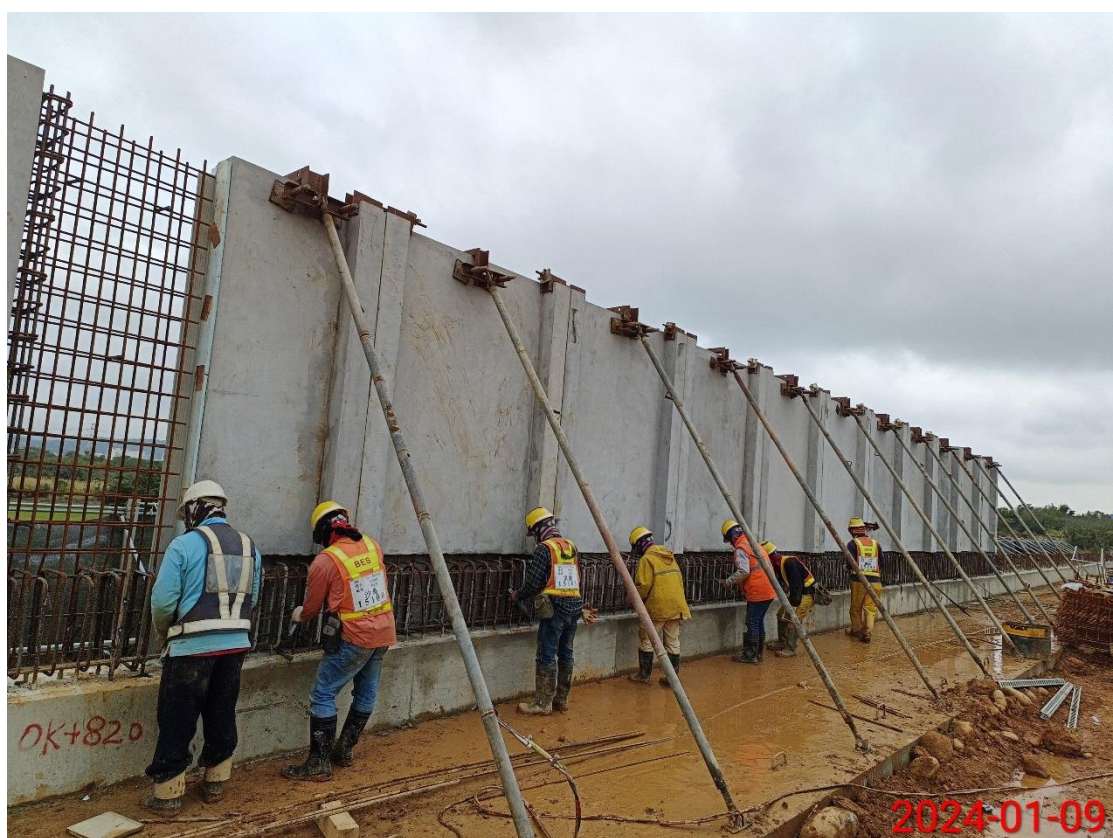
北機廠防洪牆施工
