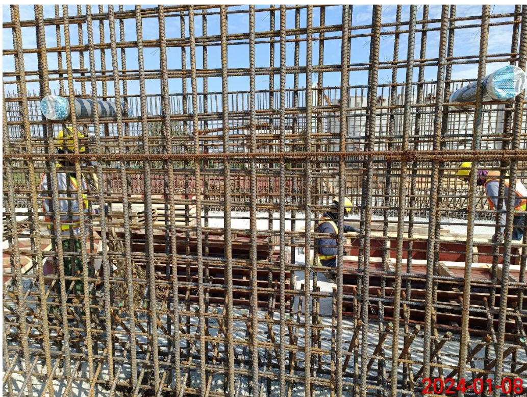
北機廠進離廠線施工
