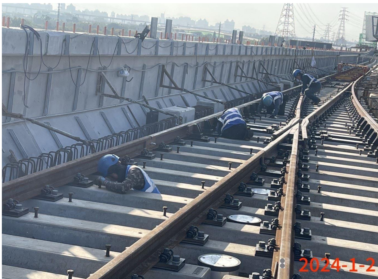
G13A-G14 站間軌道施工
