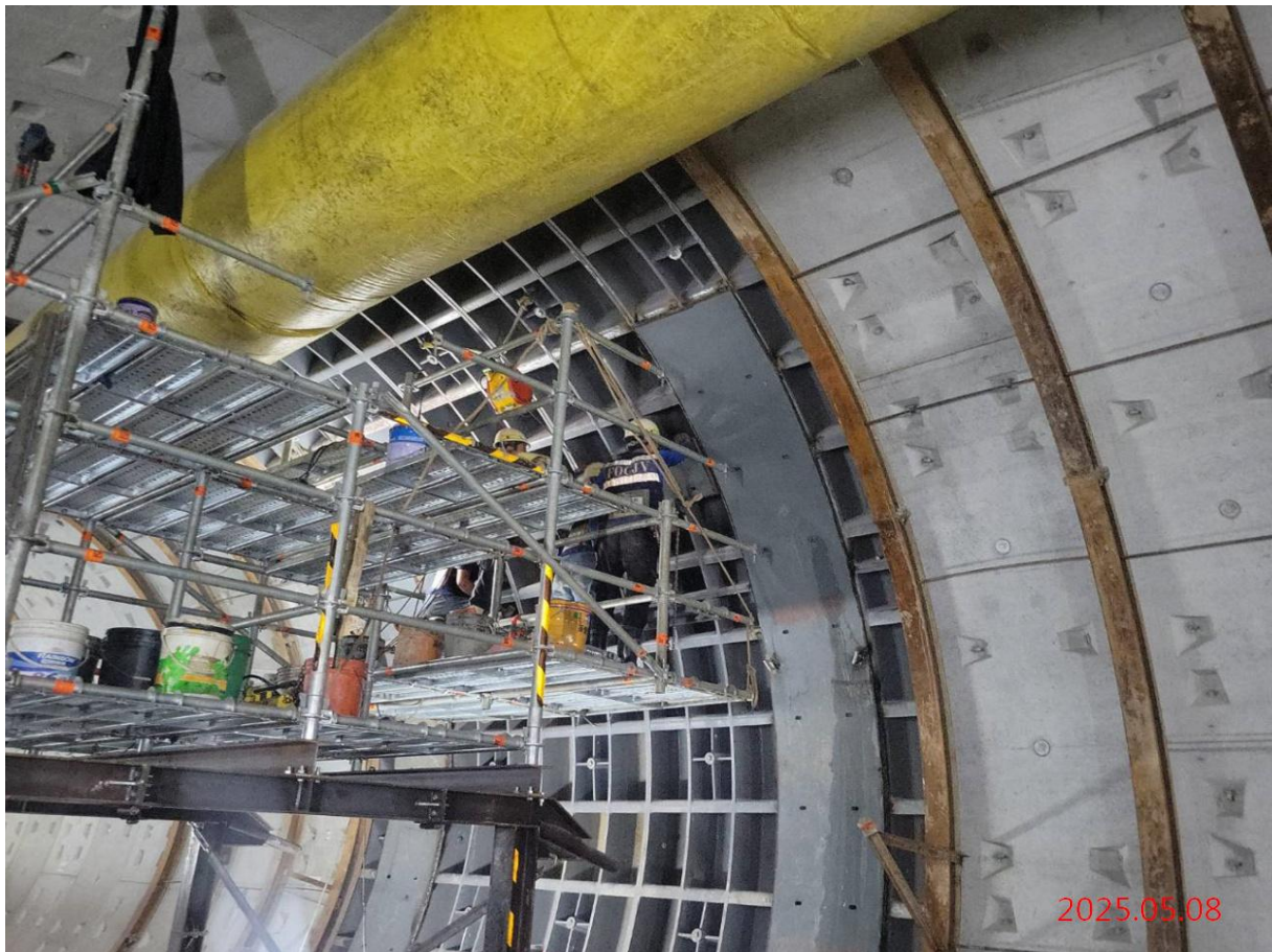
中圓潛盾隧道_隧道內鋼環撐補強鐵板施作
