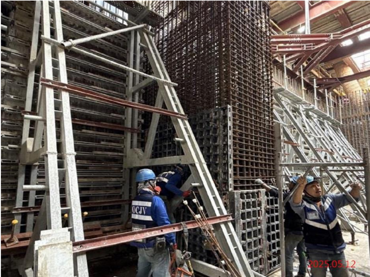
G09_B2F 柱牆施作
