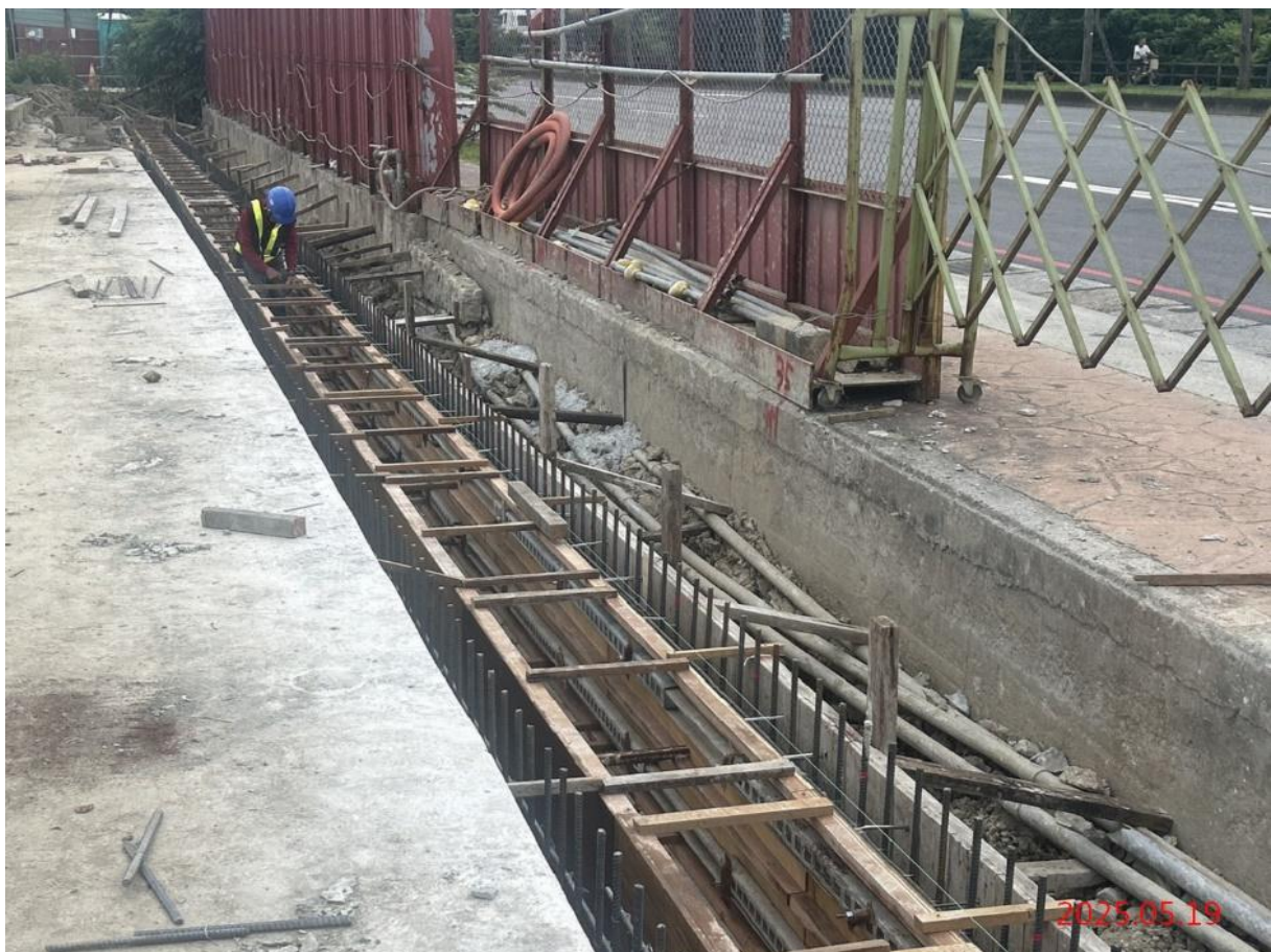
北出土段_排水溝施作
