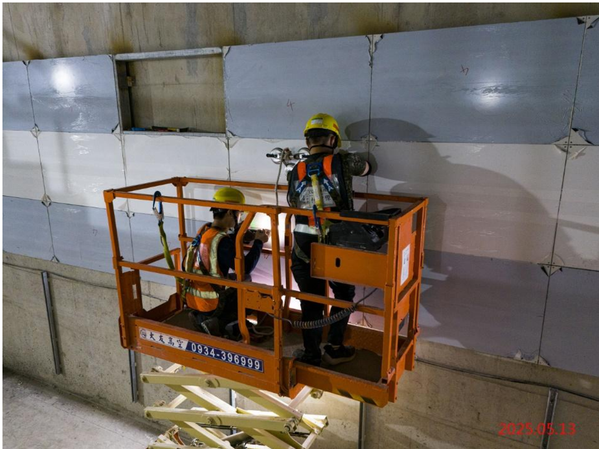
G12_站體軌道層側牆板施作
