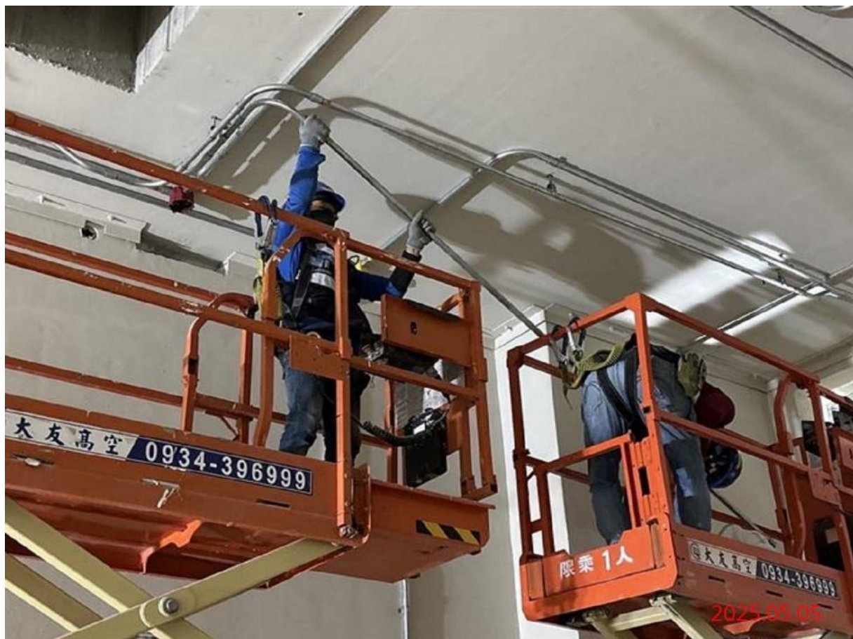
G12_站體月台層機房區電氣系統配管施作
