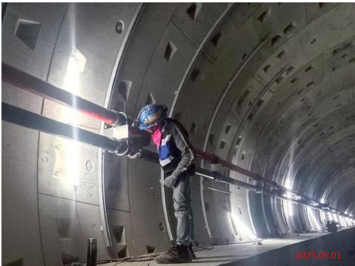
小圓潛盾隧道_排水系統消防管配管施作
