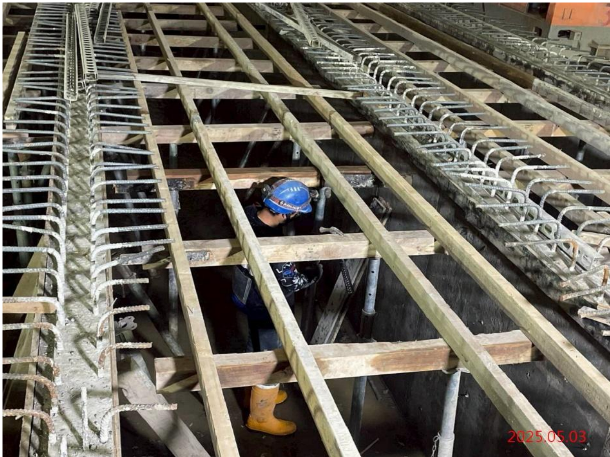
G10_站體軌道層月台版施作
