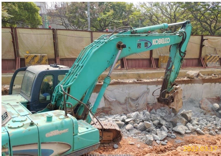
G06 站淺挖施作
