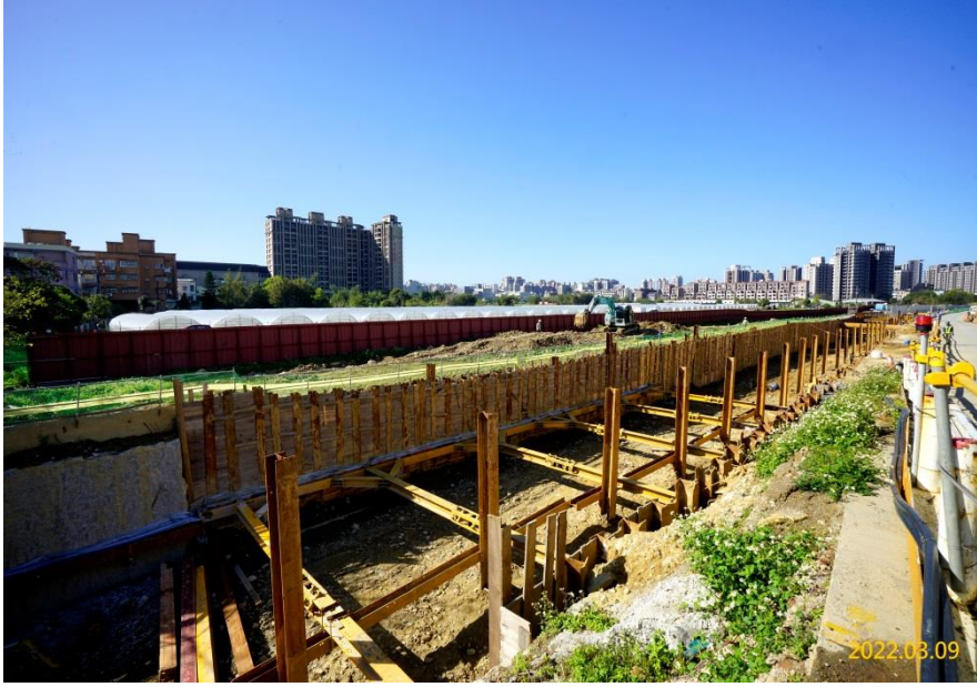
南出土段支撐架設
