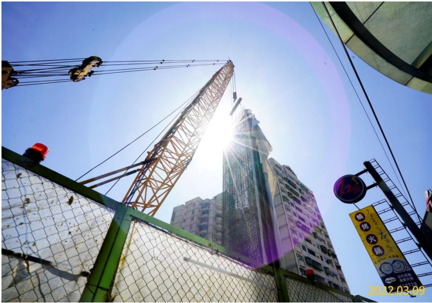
G04 站連續壁鋼筋籠吊運
