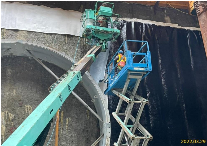
VS6 通風豎井結構體防水膜施作
