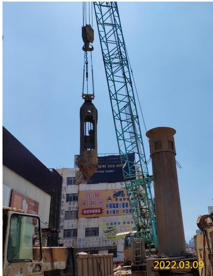
G05 站中間柱施作
