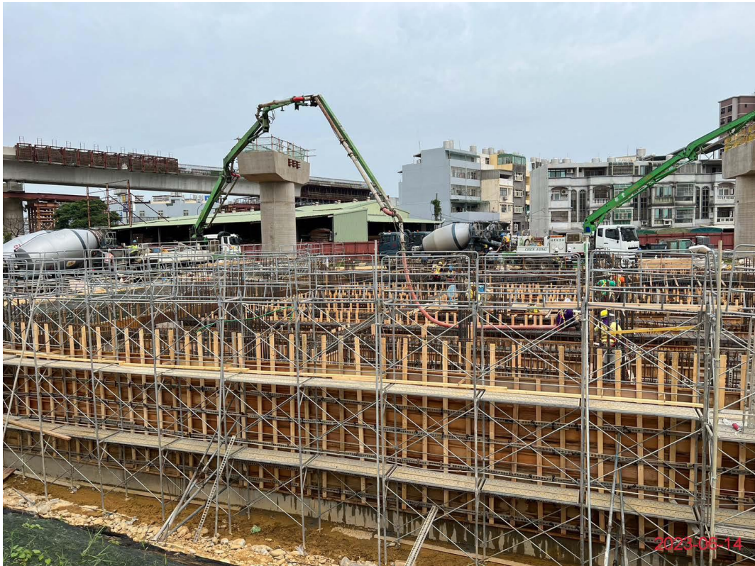
北機廠-變電區筏基牆身澆置
