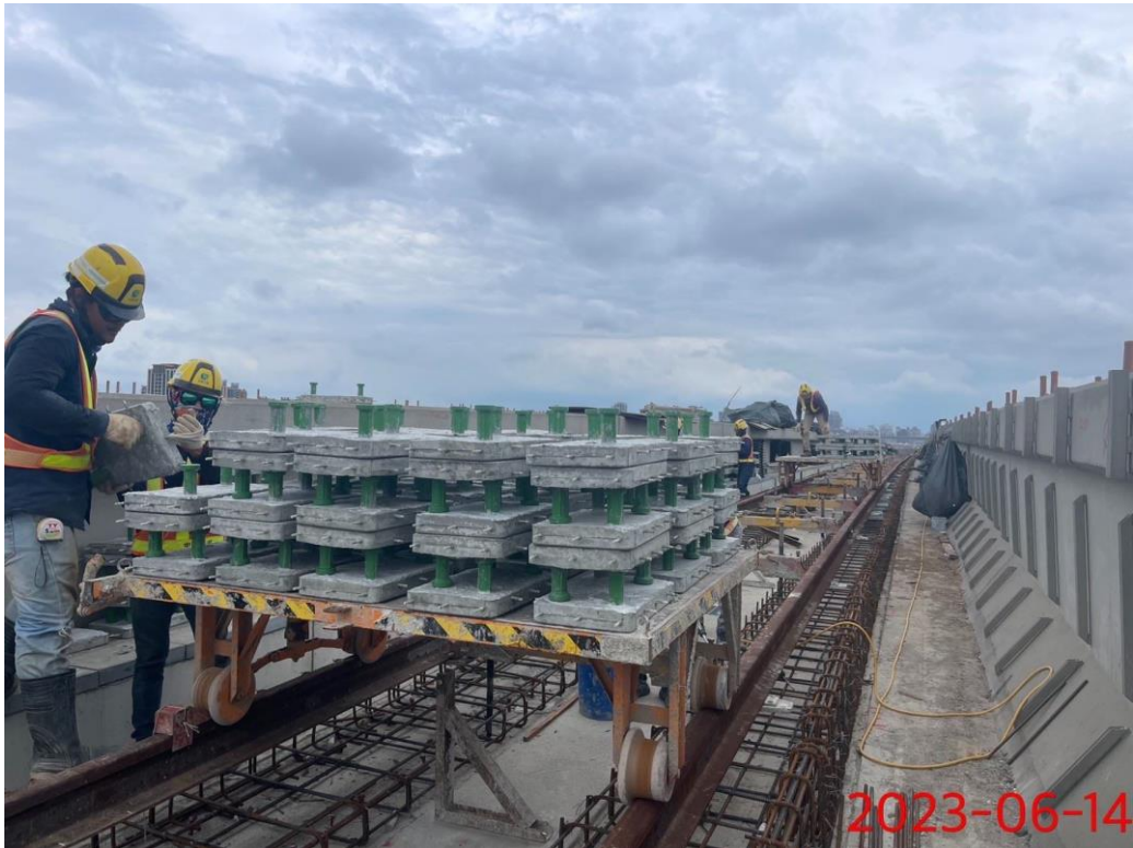
G13~G13a 下行線預鑄基底及基版佈設安裝(D42-D52)
