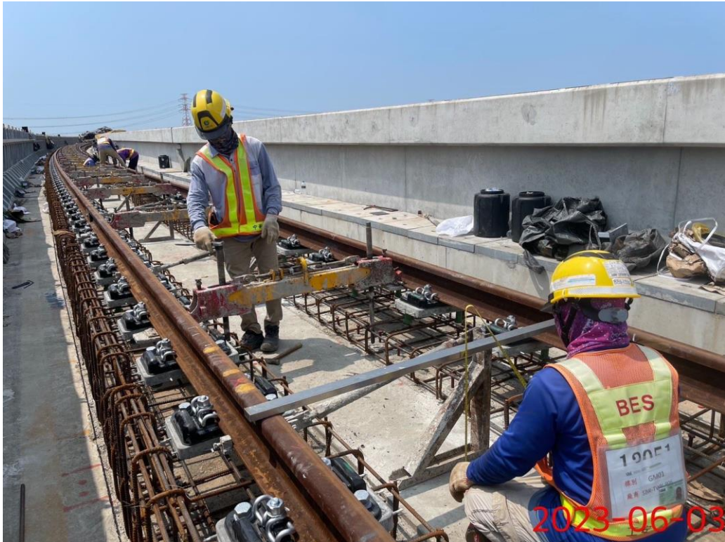
G13~G13a 下行線預鑄基底及基板佈設安裝 ( D28-D41)
