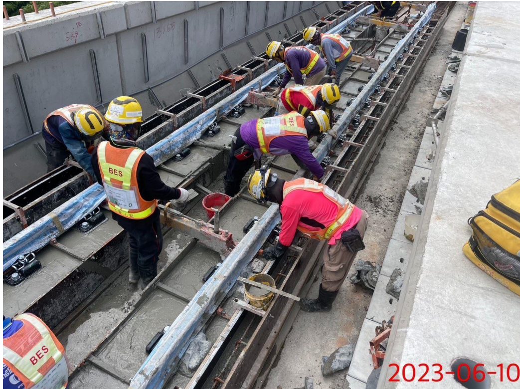
G13~G13a 下行線道床混凝土澆置(D28-D41)
