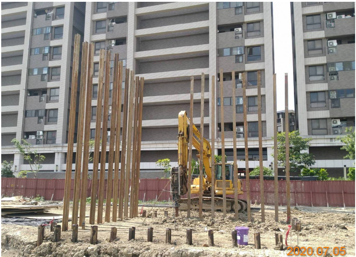
八德新闢道路 樁帽鋼軌樁打設
