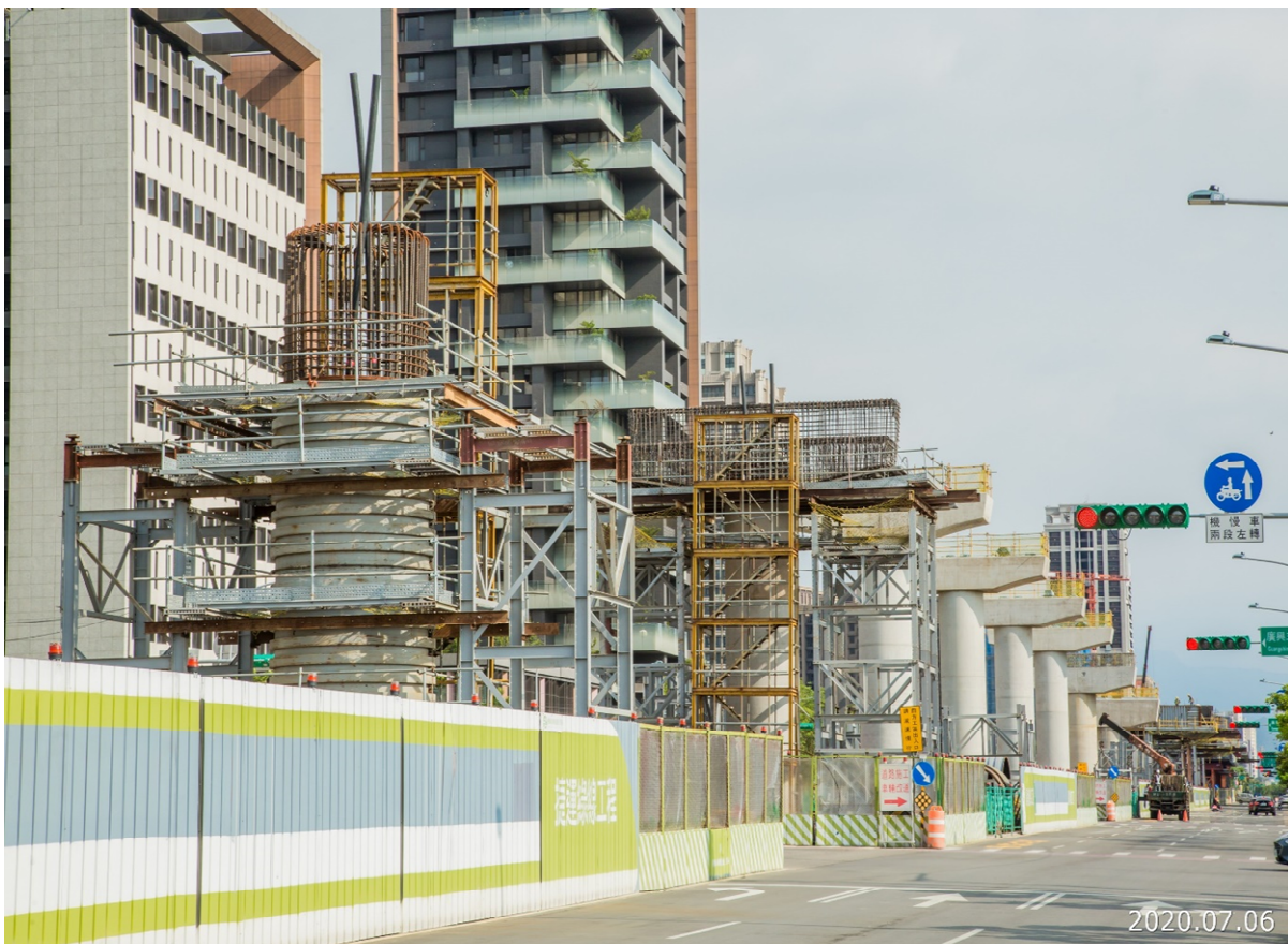
八德建德路 下部結構施作情形
