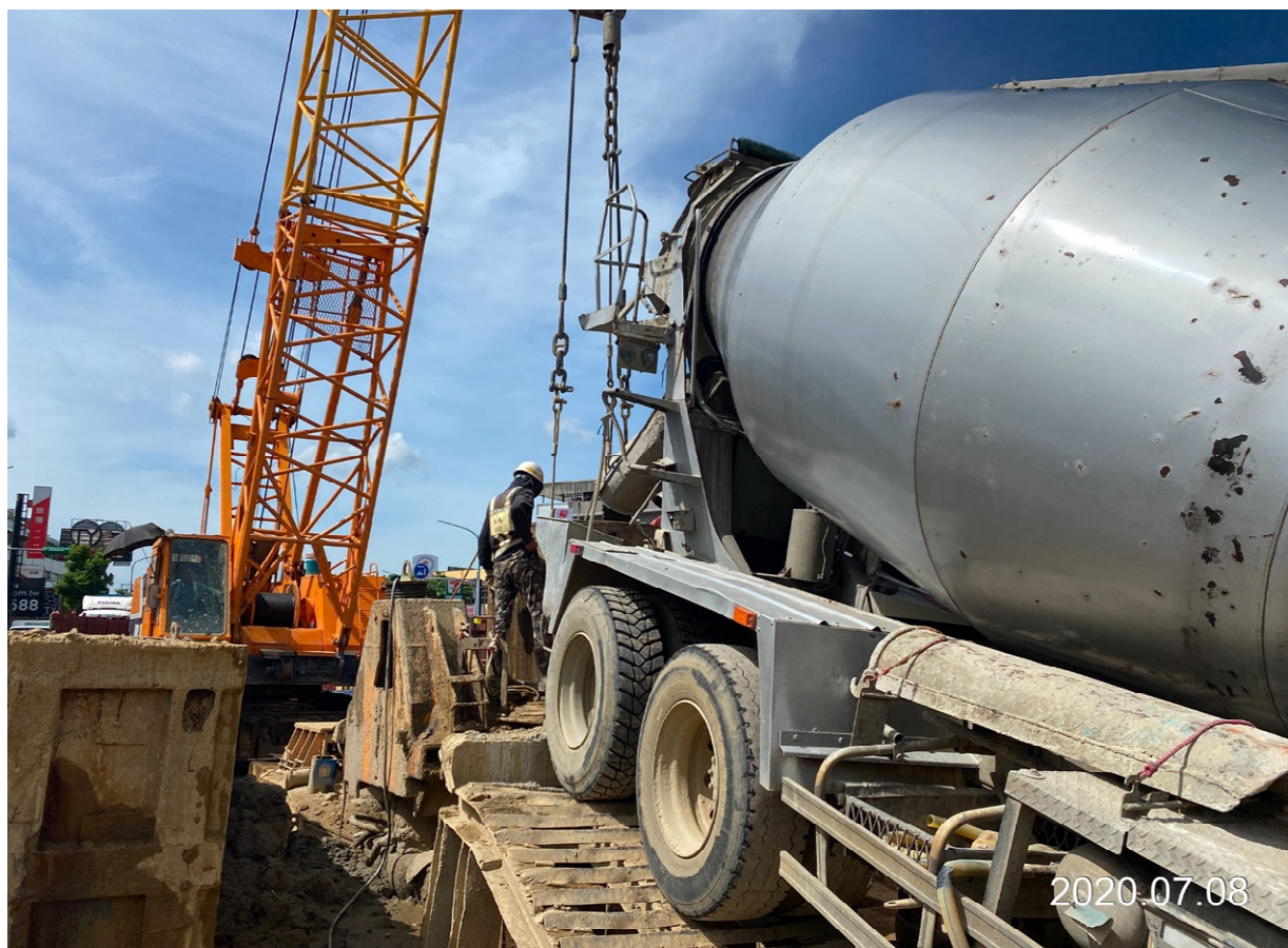
大園三民路 基樁混凝土澆置
