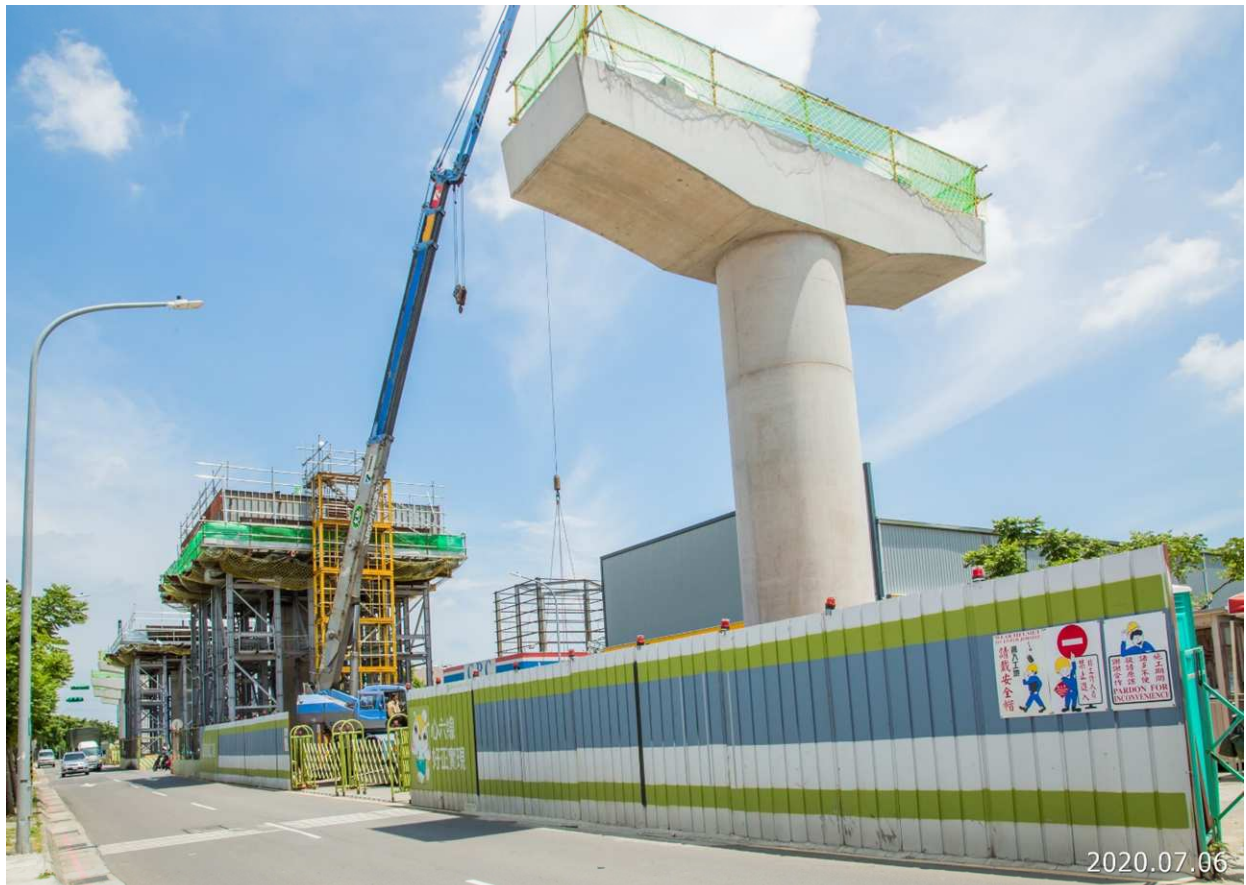
蘆竹中正北路 下部結構施作情形
