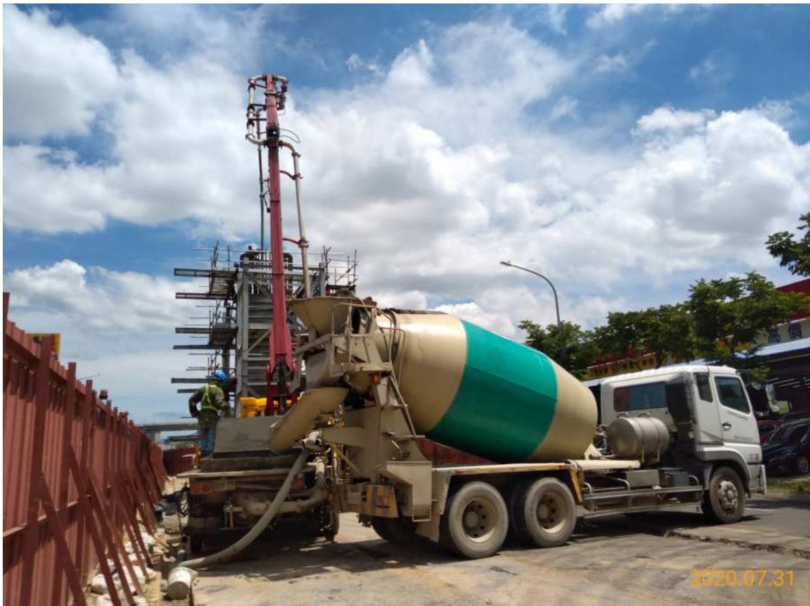
蘆竹中正北路 墩柱混凝土澆置
