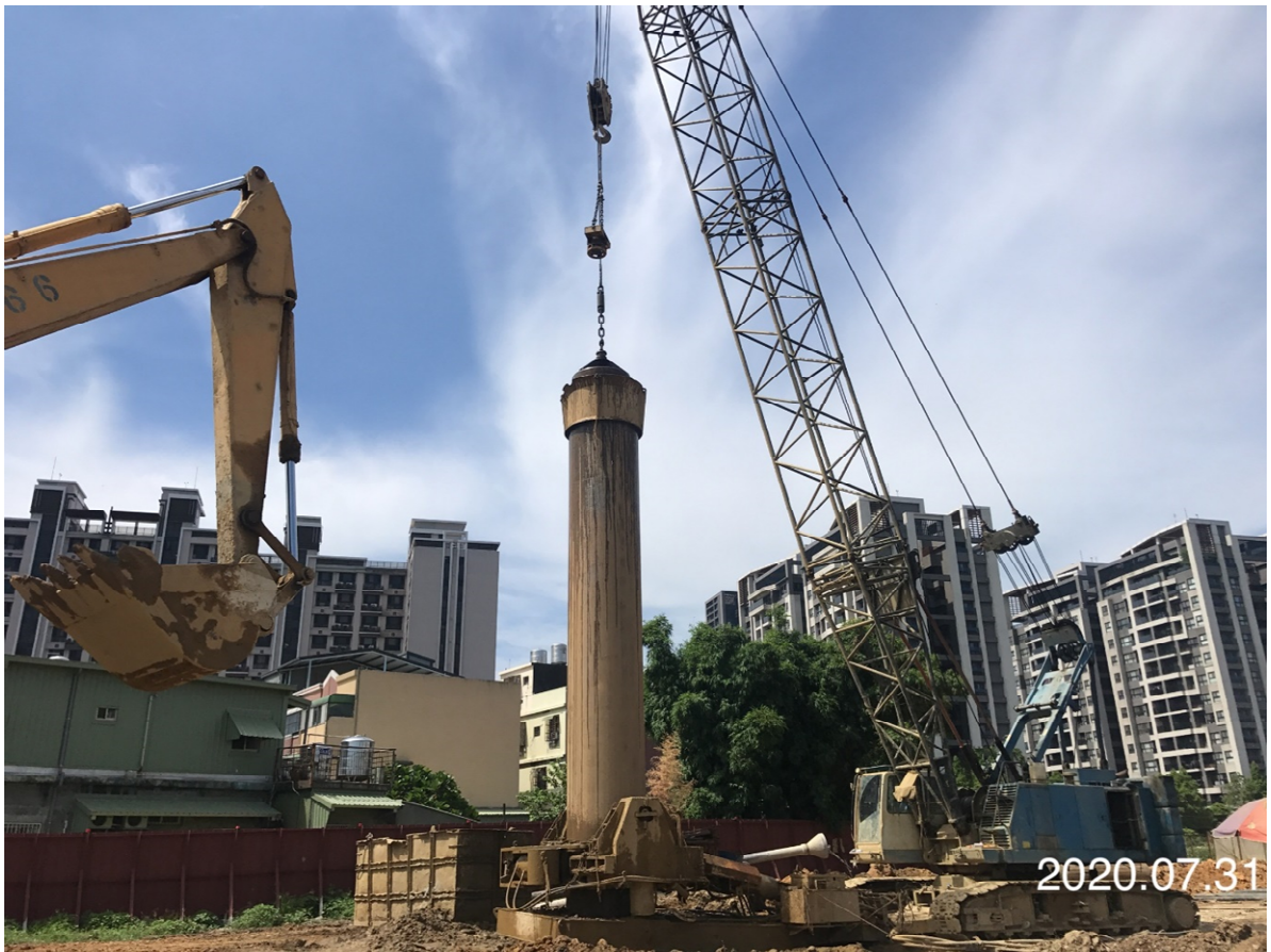
八德新闢道路 基樁鑽掘
