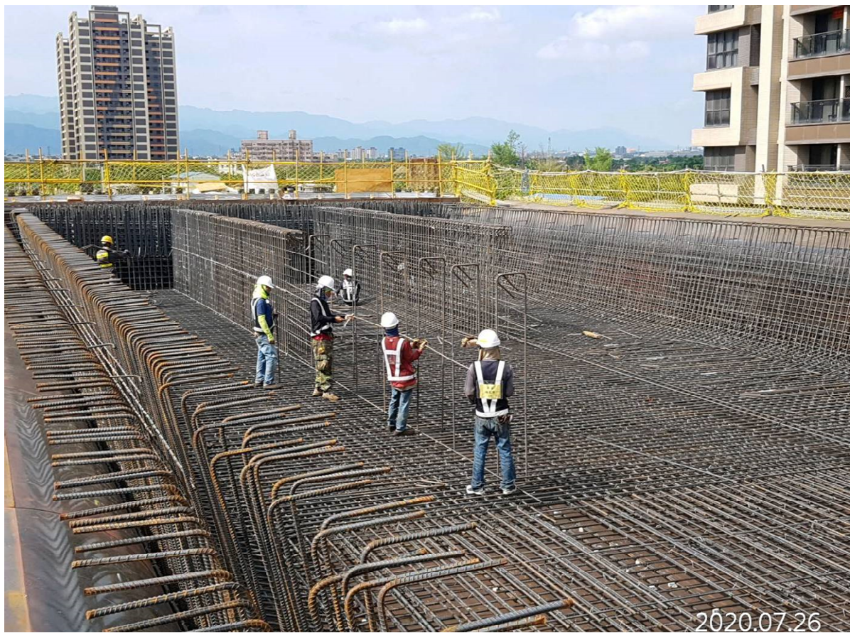
八德建德路 場撐箱型梁底版鋼筋綁紮
