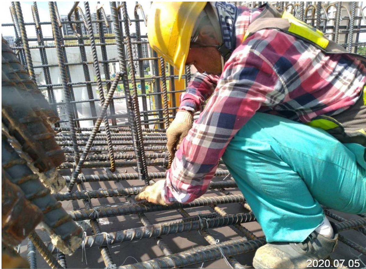
八德建德路 帽梁鋼筋綁紮
