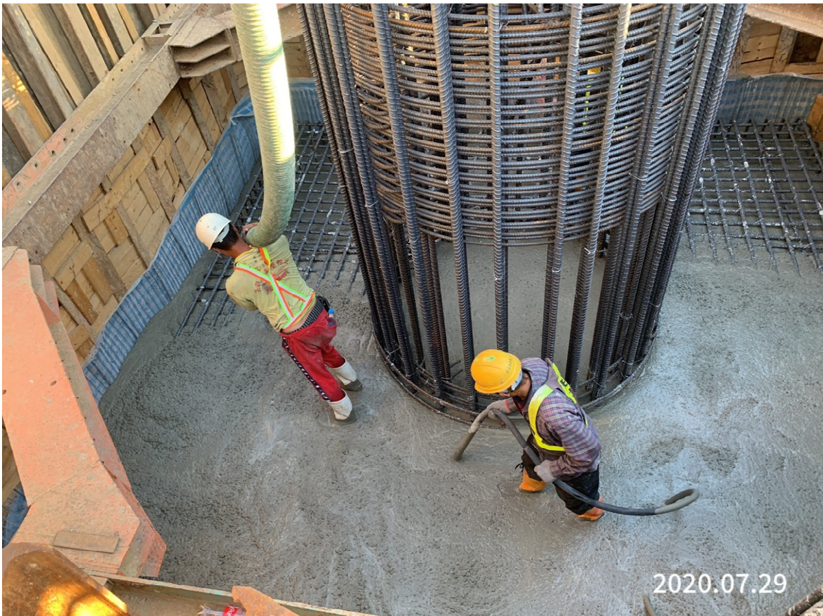
蘆竹中正北路 樁帽混凝土澆置
