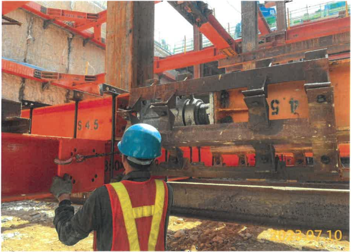
G03 出入口支撐架設
