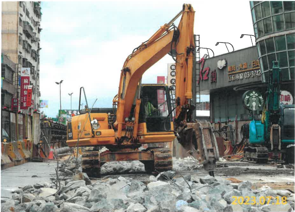
G04 站淺層開挖施作
