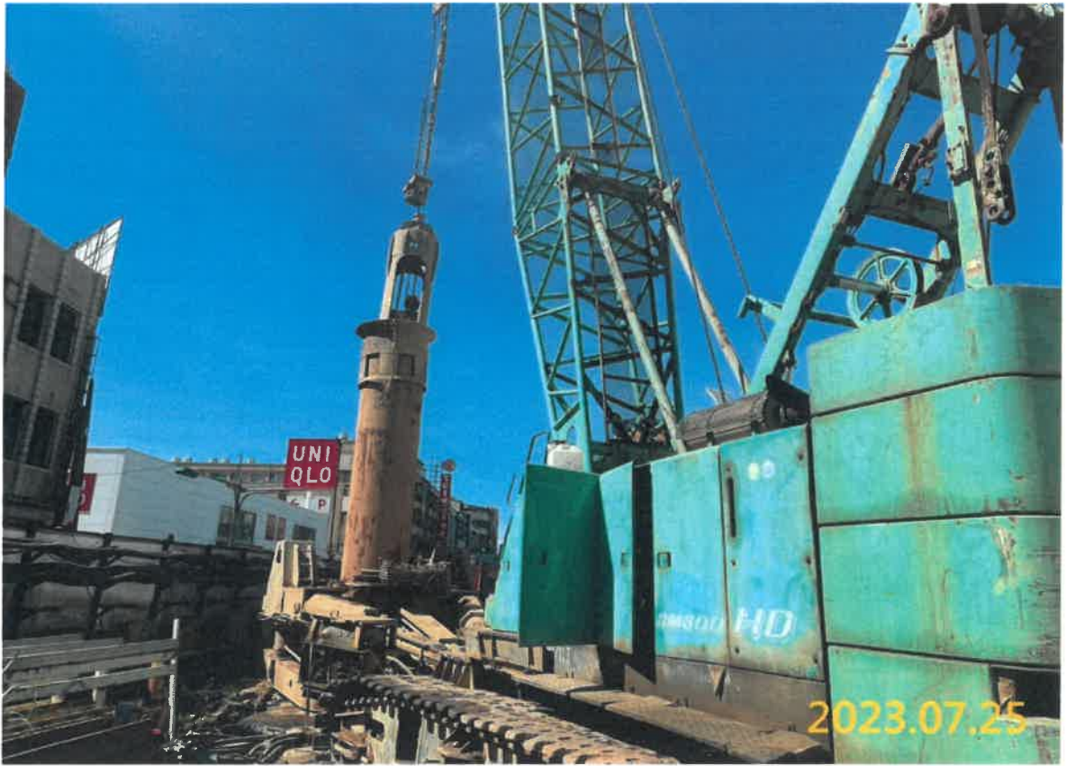
G05 站中間柱施作
