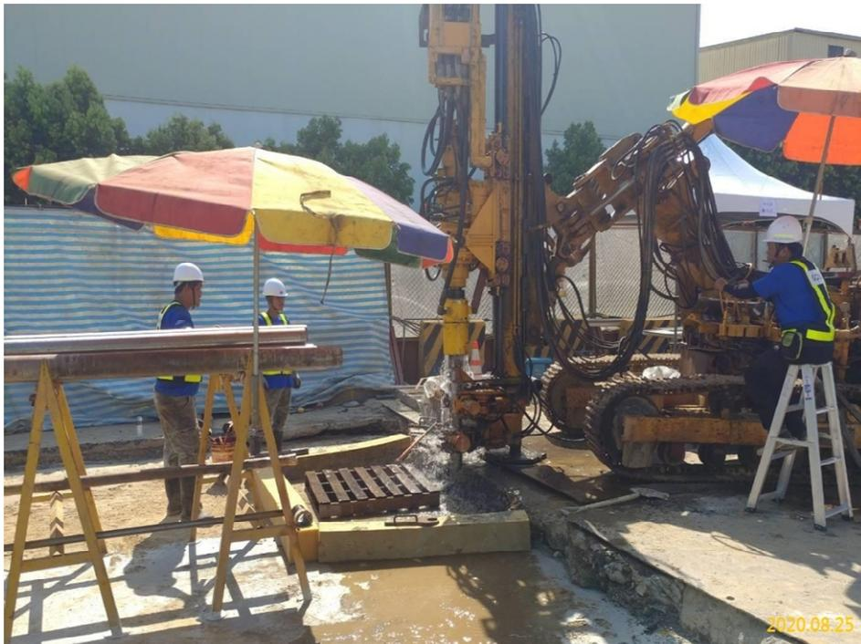
G03 站(巧克力街附近)潛盾隧道出發地盤處理灌漿鑽孔施作
