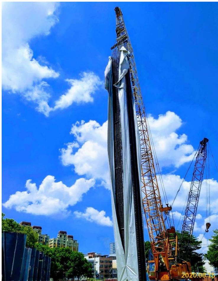
VS6 通風豎井(福豐公園)連續壁單元鋼筋籠吊放
