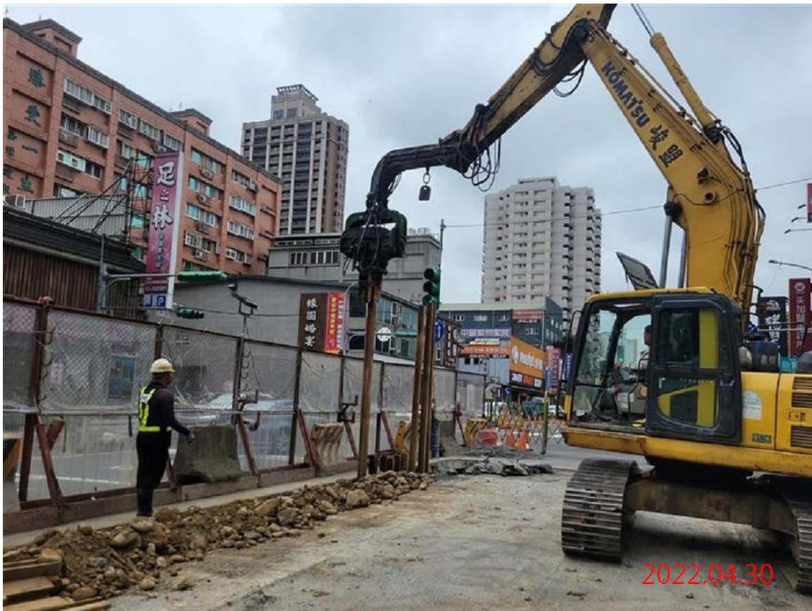
G10 站_站體鋼軌樁打設
