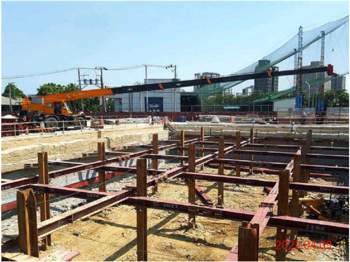
G12 站_開挖及支撐系統施作
