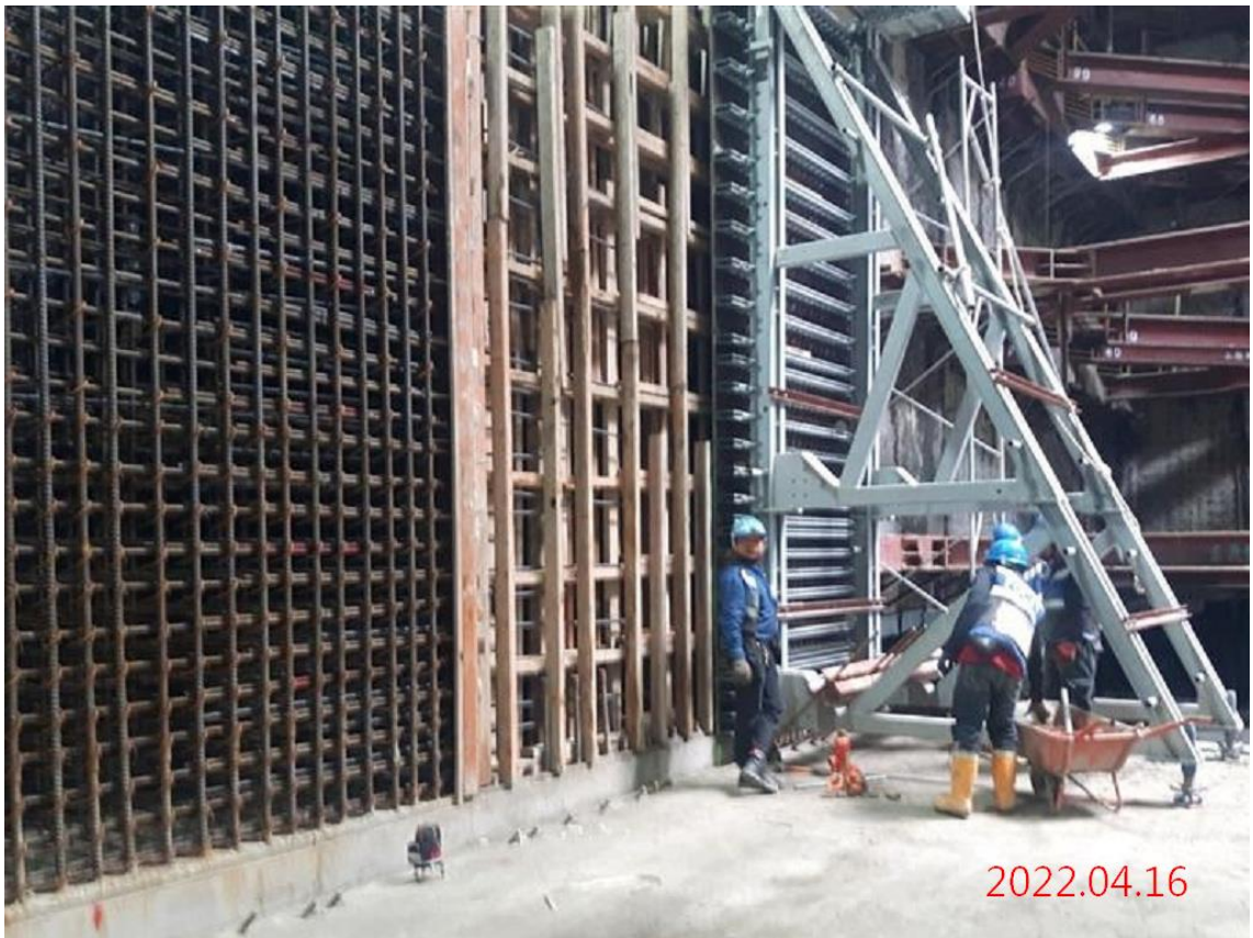
G12 站_站體結構軌道層牆模板組立
