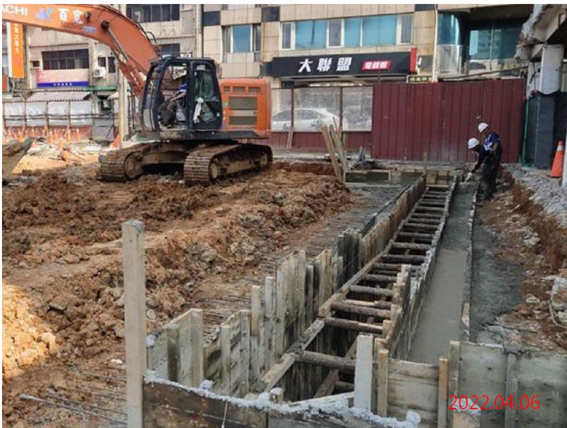
G09 站_連續壁導溝施作
