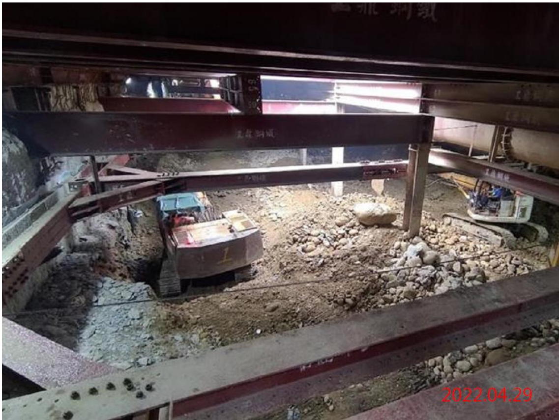
G11 站_站體開挖及支撐系統施作
