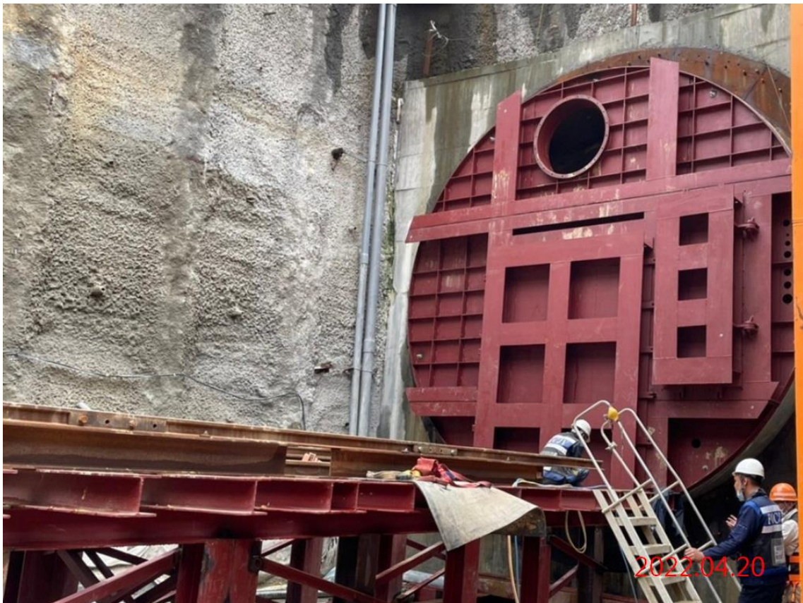
潛盾隧道_ 設備轉換(防洪閘門裝設)
