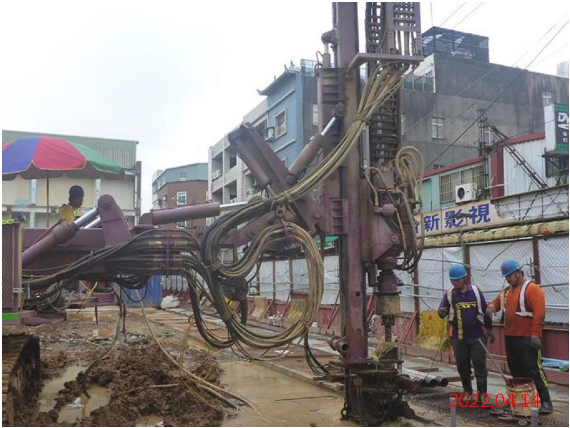
G09 站_連續壁槽溝保護施作
