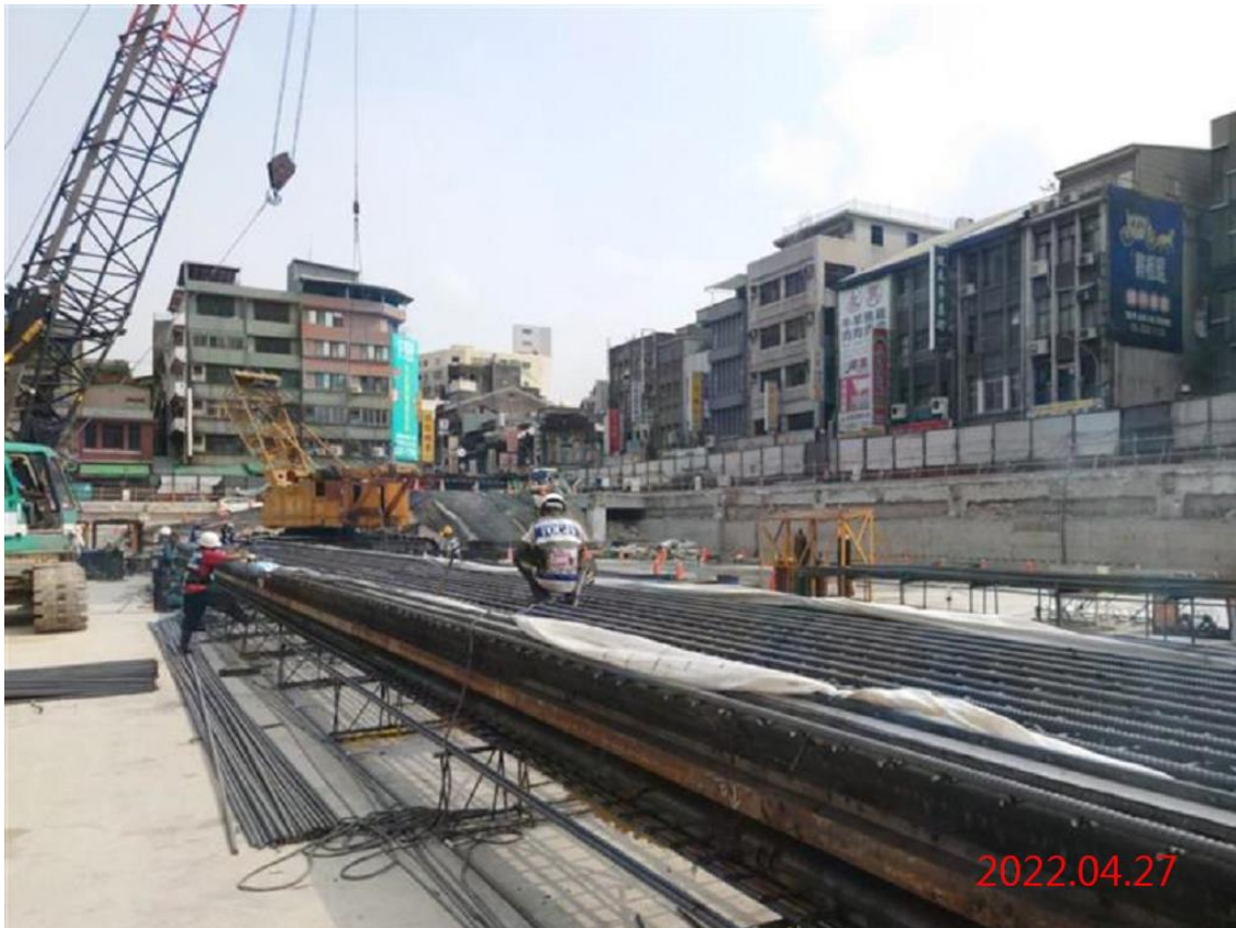
G08 站_連續壁鋼筋籠組立
