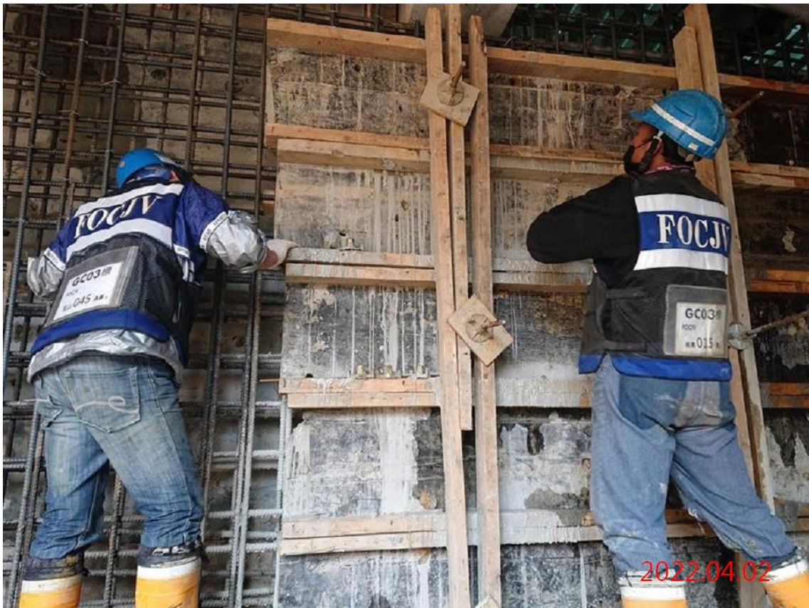
G08 站_深導溝施作
