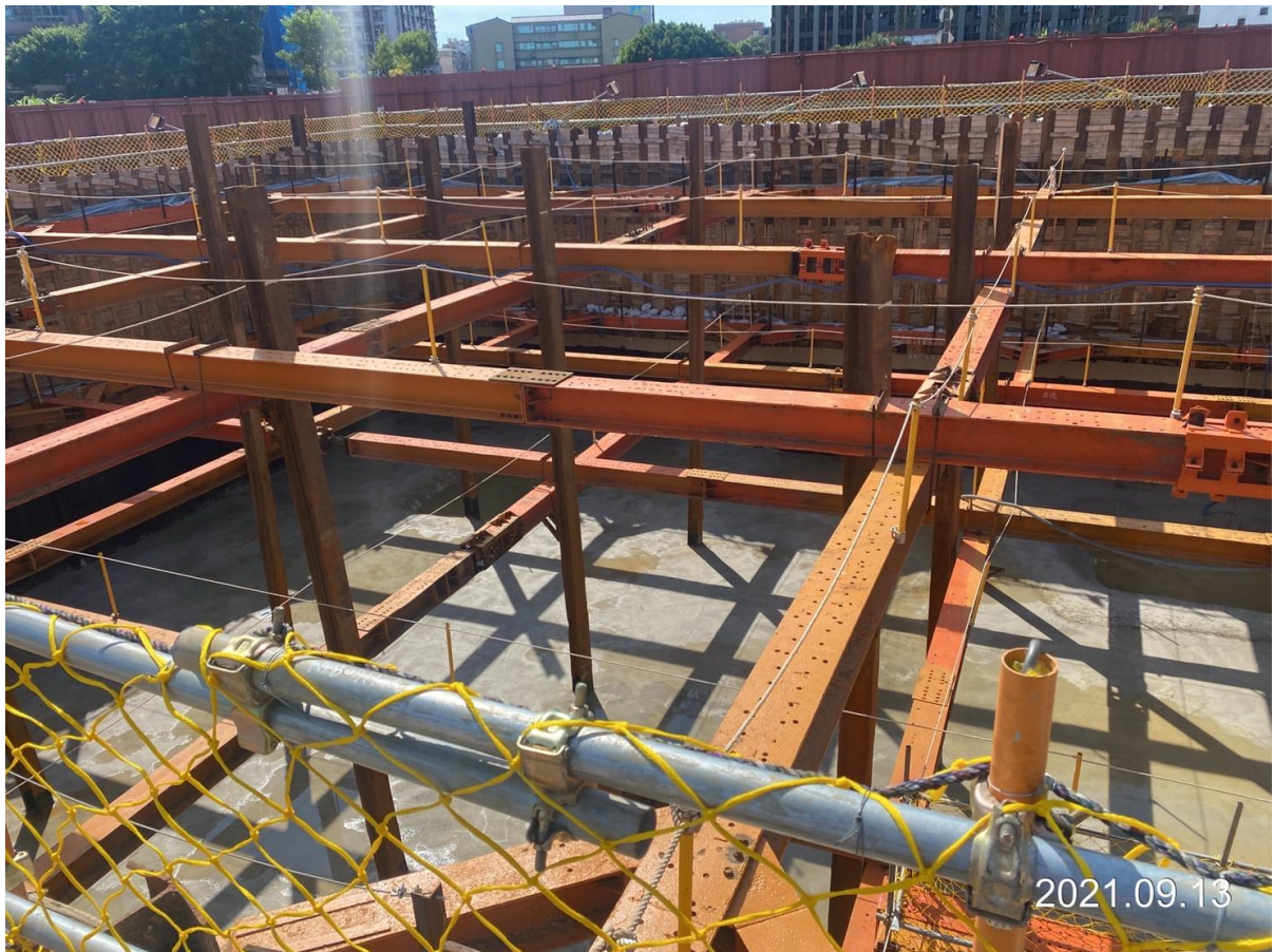
大園三民路二段 G31 車站出入口施工現況
