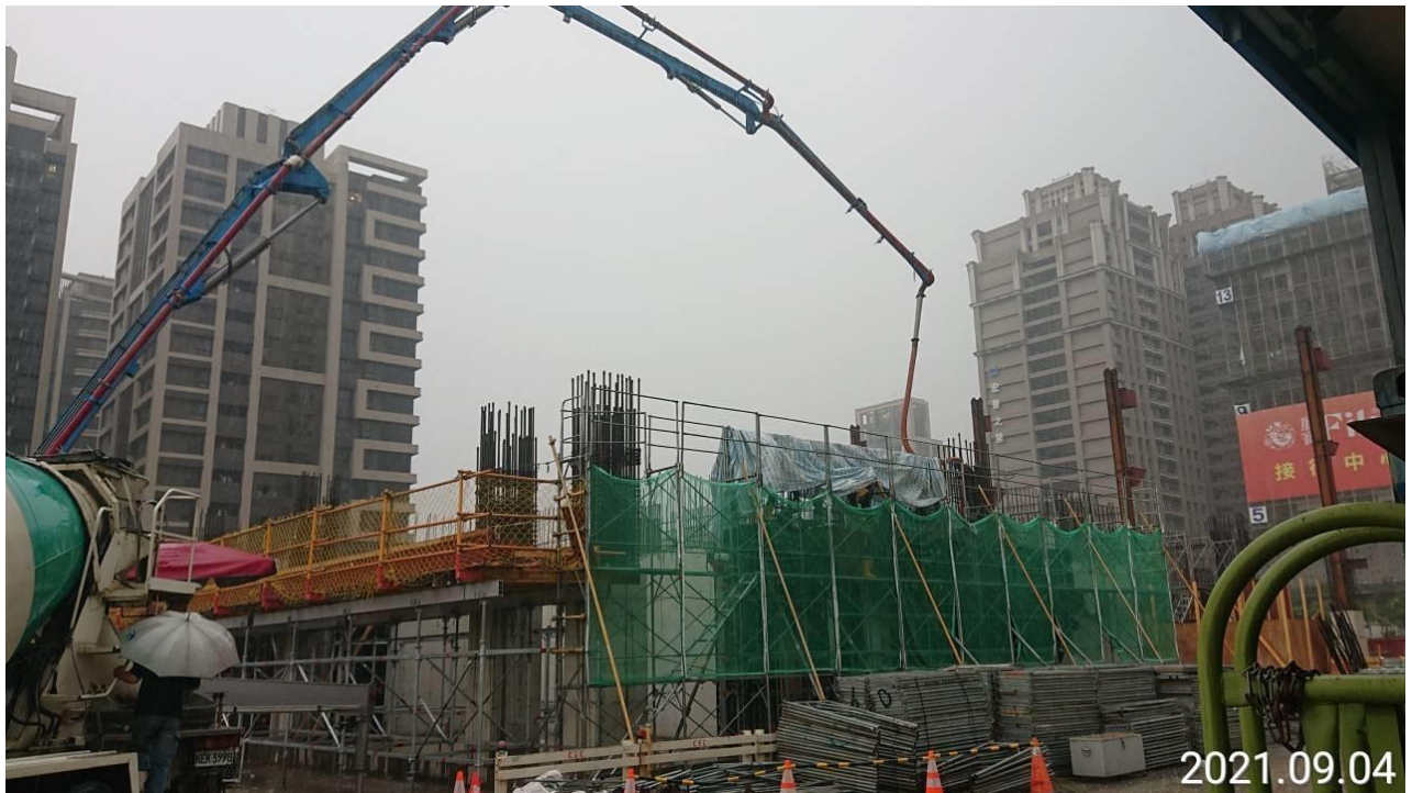
八德新闢道路 G0 車站出入口 1 樓柱牆混凝土澆置
