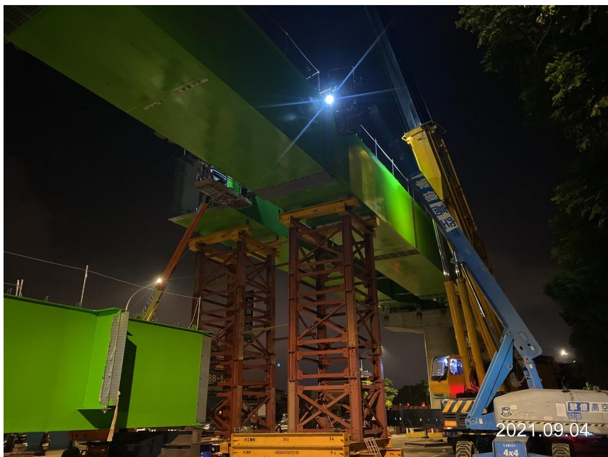
蘆竹中正北路 鋼箱型梁夜間吊裝
