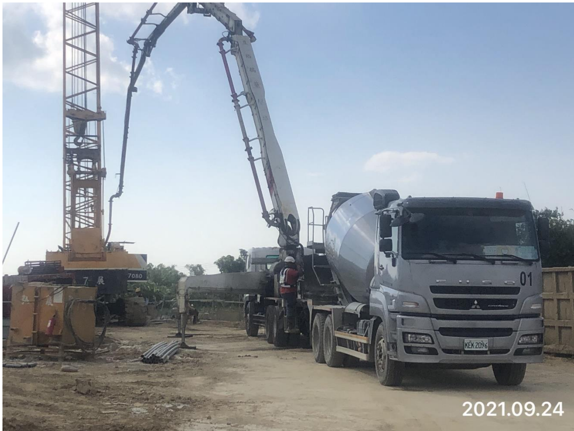
大園三民路二段 基樁混凝土澆置
