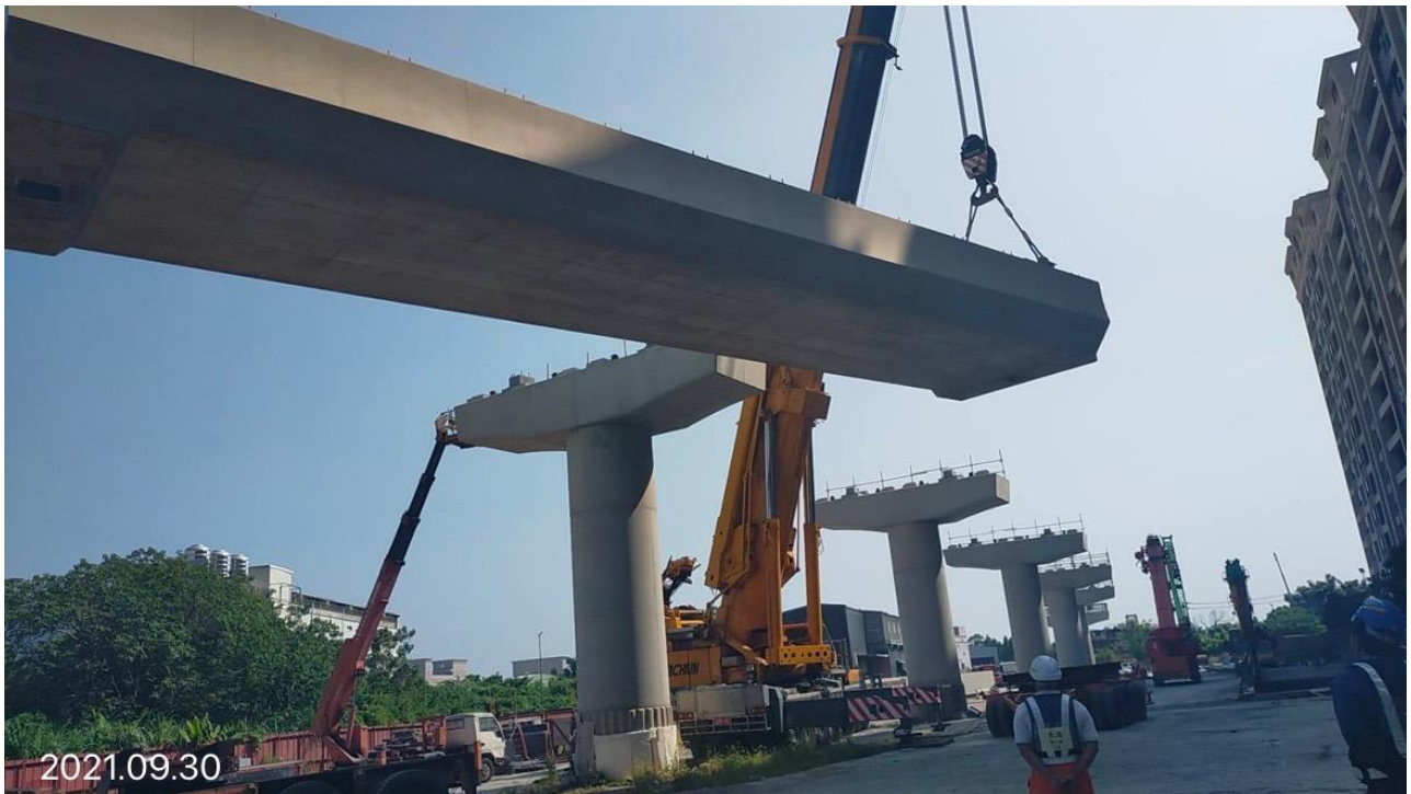
八德新闢道路 預鑄混凝土 U 型梁吊裝
