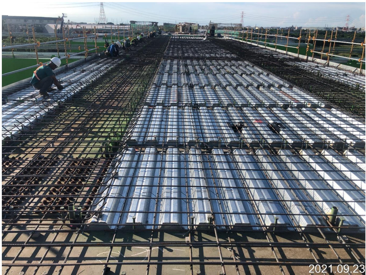
蘆竹中正北路 G13 車站軌道版鋼筋綁紮
