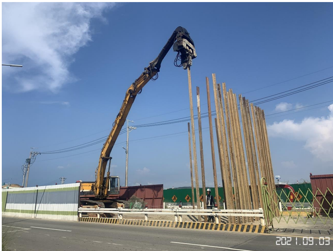
大園坑菓路 樁帽鋼軌樁打設
