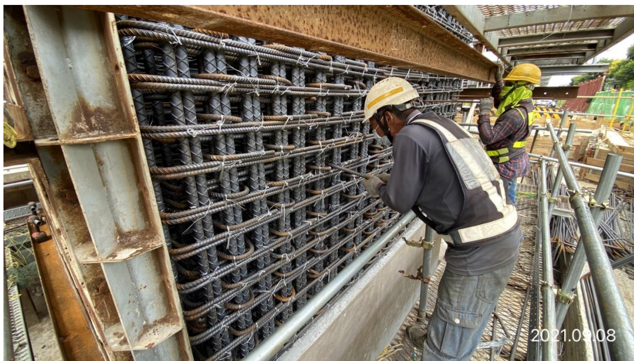
蘆竹南崁路二段 帽梁鋼筋綁紮
