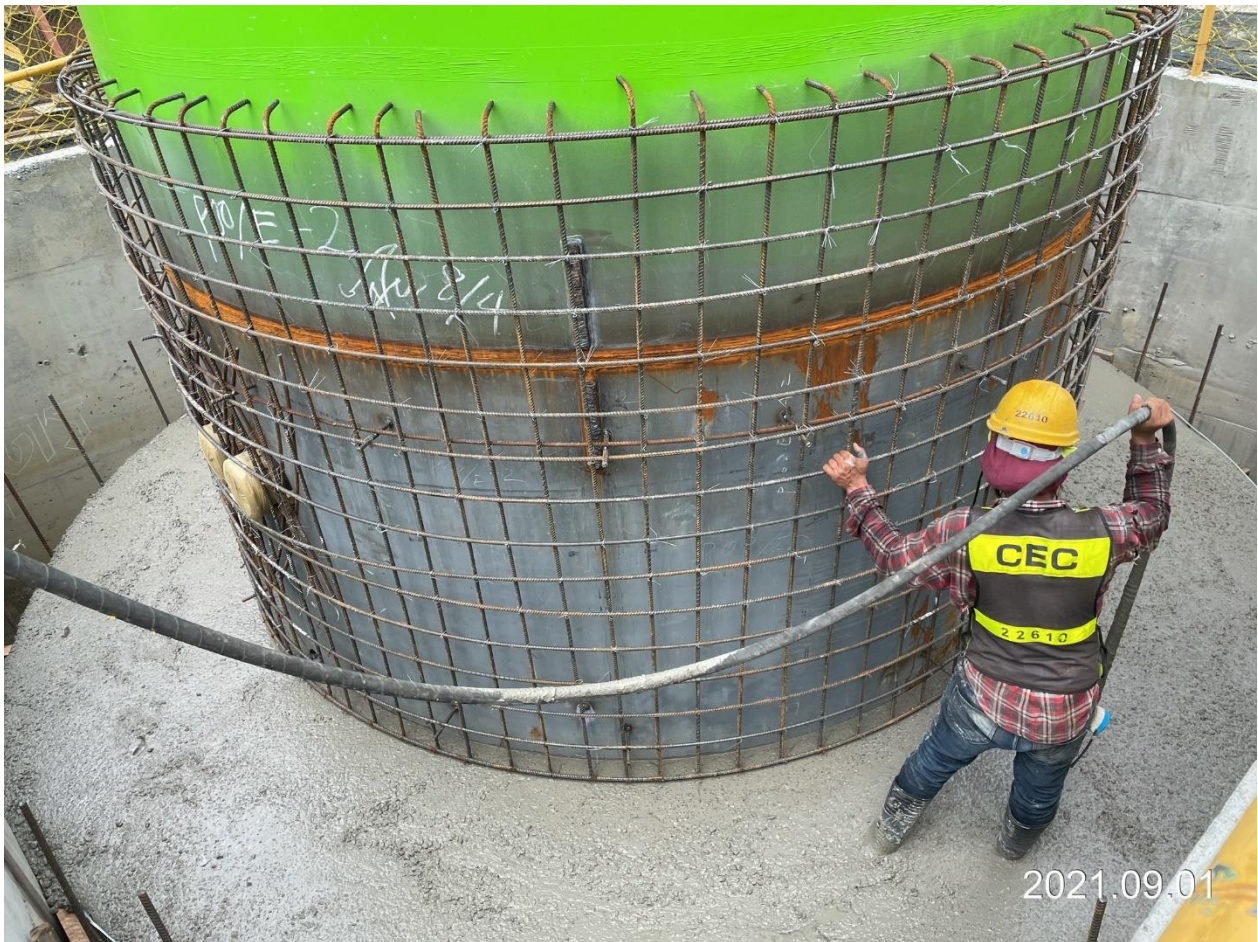
八德建德路 鋼墩柱保護墩基座混凝土澆置
