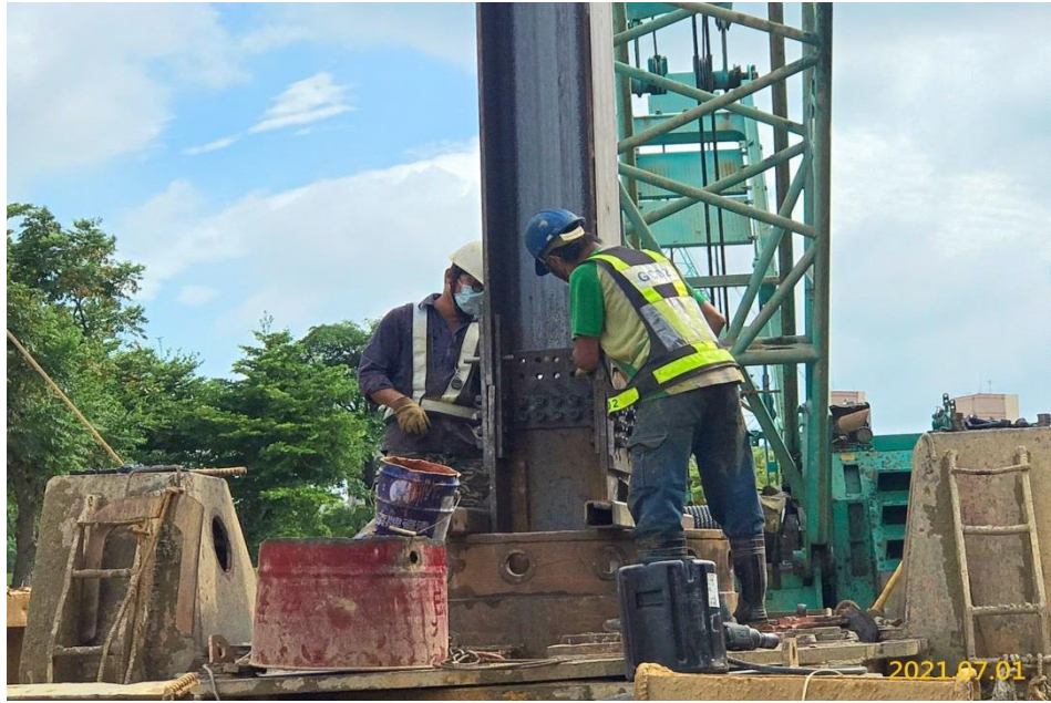
G06 站中間柱施作
