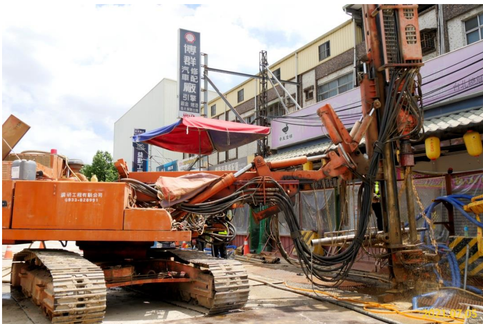
G03 站地盤處理施作
