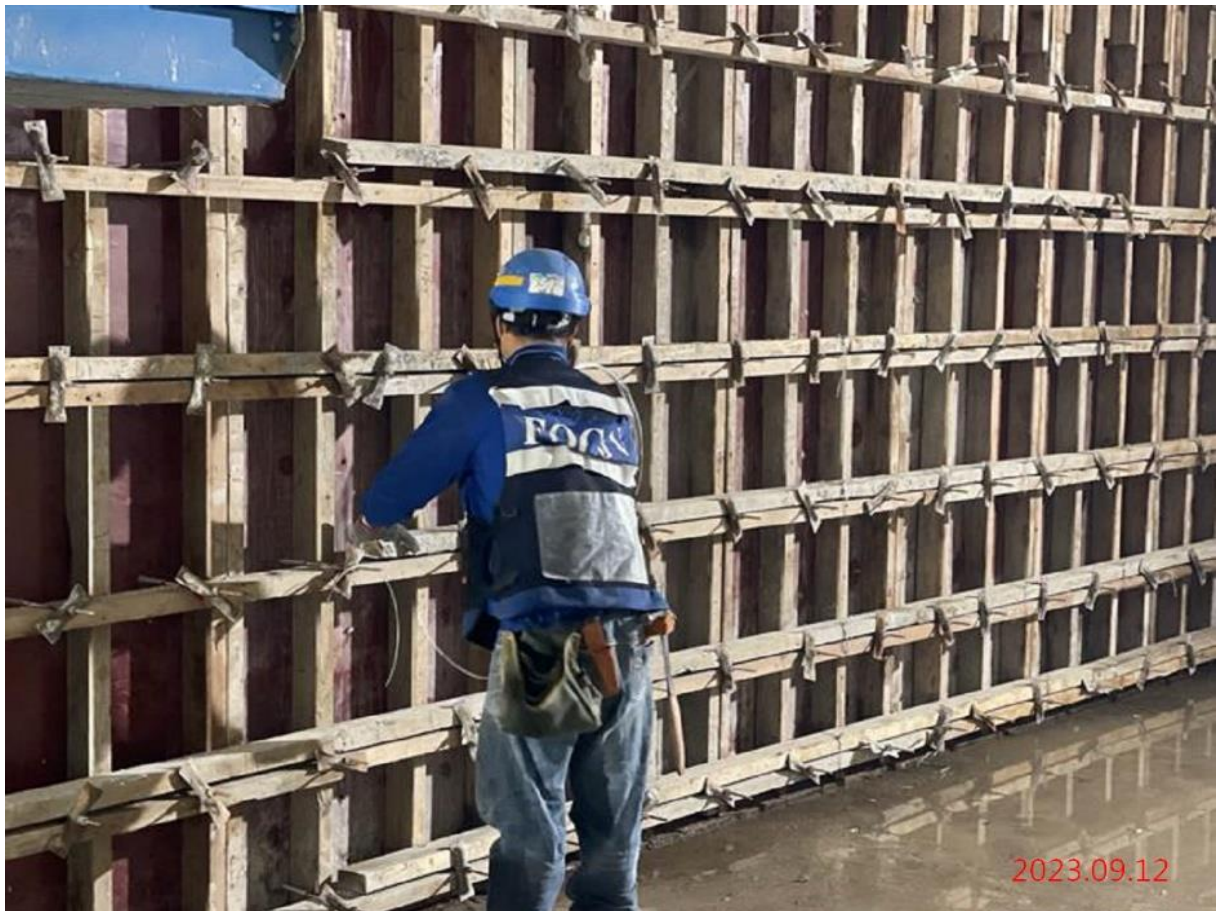
G12_出入口 A 穿堂層隔間牆模板作業
