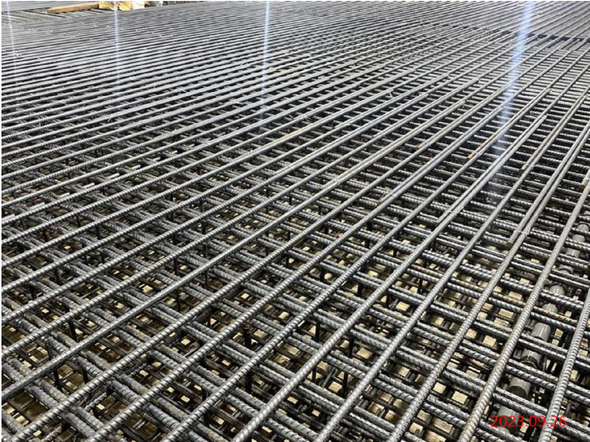
G07_結構 B2F 第一、二區上版筋綁紮
