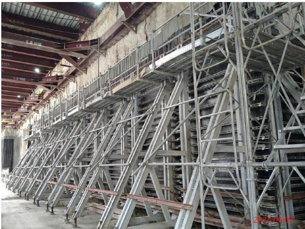
G11_出入口穿堂層側牆模板組立
