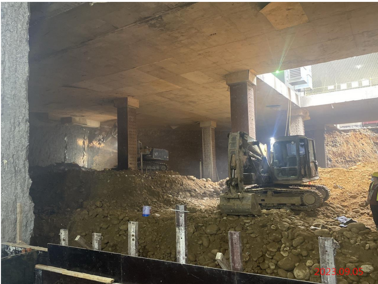
G07_結構 B2F 第三、四區開挖
