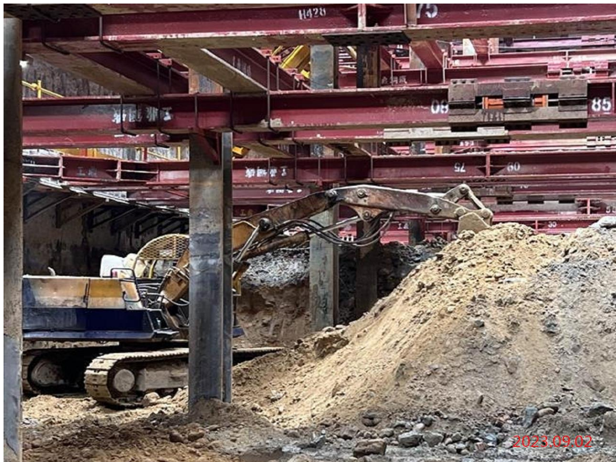
G08_第七層開挖
