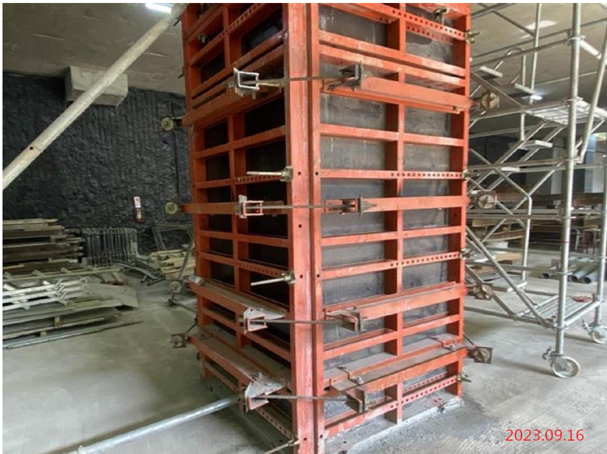
G07_結構 B1F 第二區 SRC 柱模板組立
