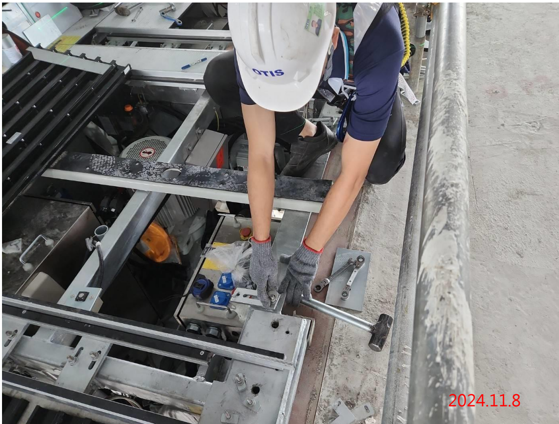
G14 站 5、6 號電扶梯床板安裝,高程調整作業
