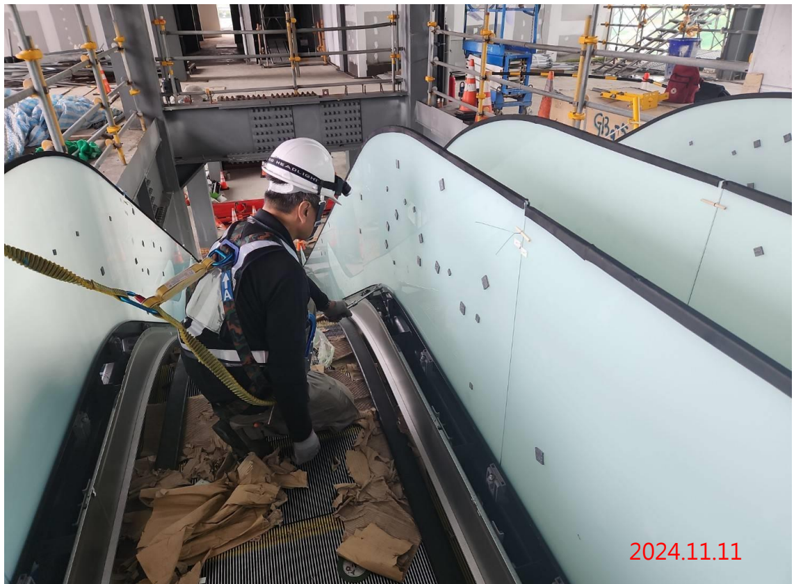
G13a 站 5、6 號電扶梯扶手玻璃安裝
