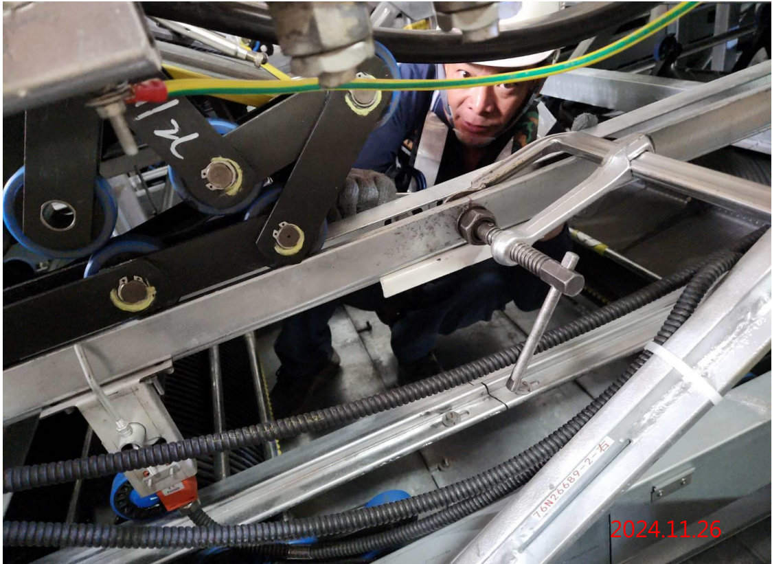
G13a 站 5、6 號電扶梯踏階安裝調整
