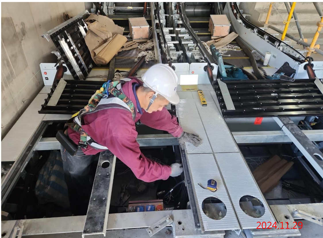
G14 站 1、2 號電扶梯高程調整及床板安裝作業
