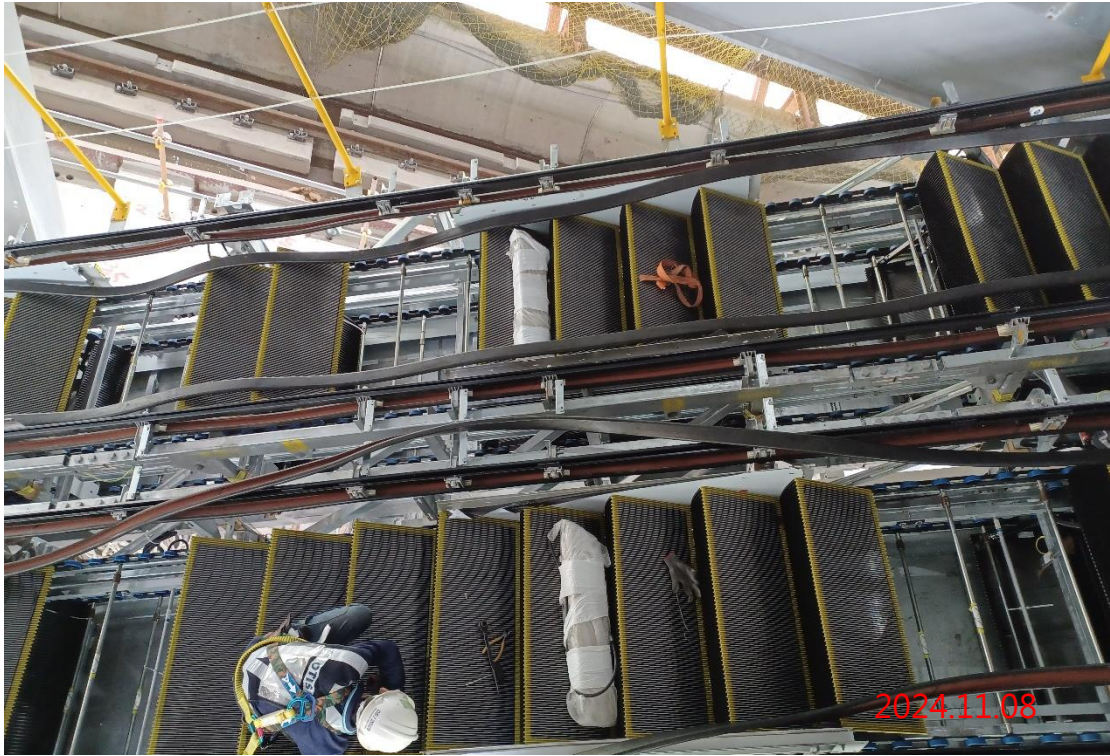
G14 站 5、6 號電扶梯玻璃座安裝調整作業
