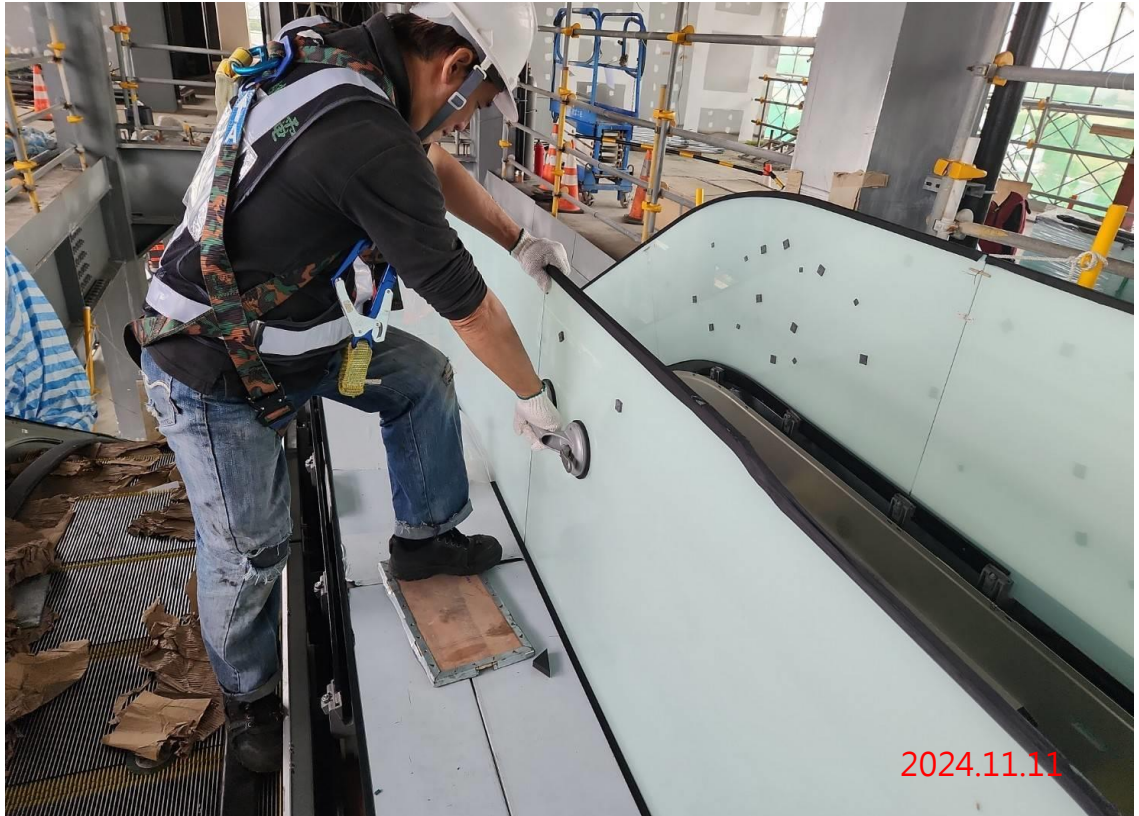
G13a 站 5、6 號電扶梯扶手玻璃安裝
