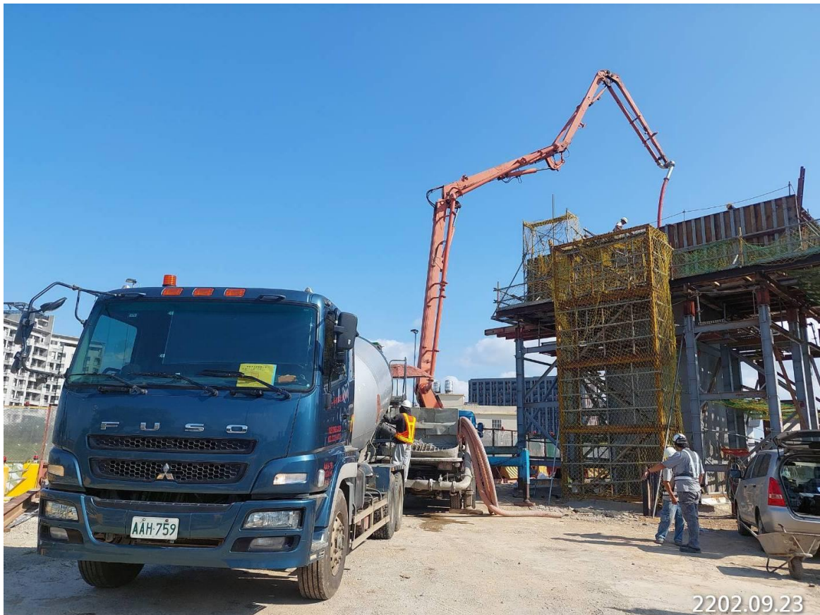
大園坑菓路 帽梁混凝土澆置
