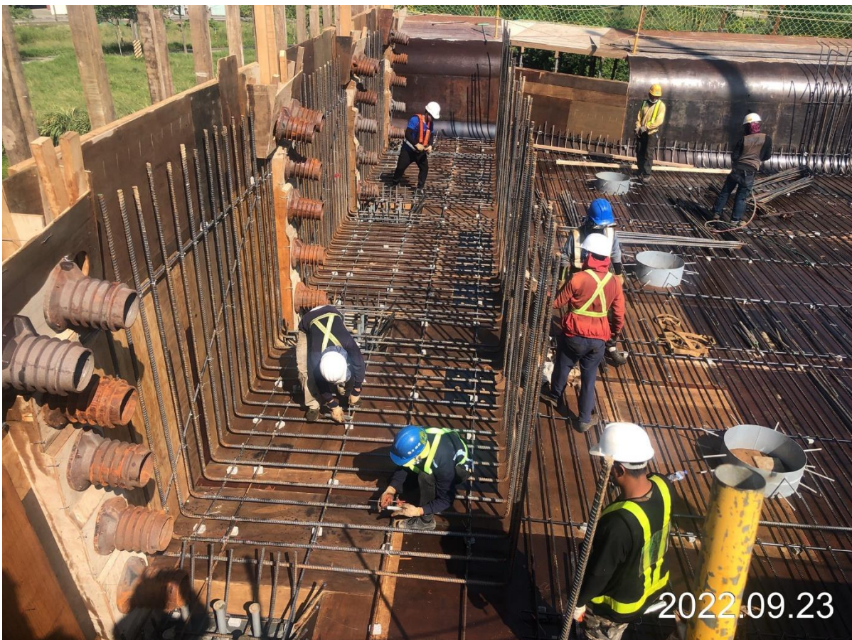
大園坑菓路 場撐箱型梁鋼筋綁紮
