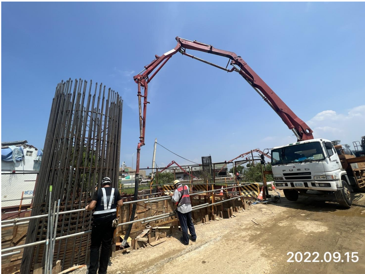
大園三民路二段 樁帽混凝土澆置
