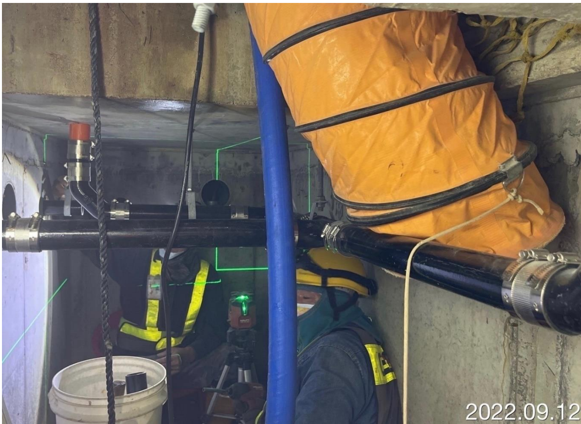
八德新關道路 G02 車站出入口 B1F 筏基層排水管施作
