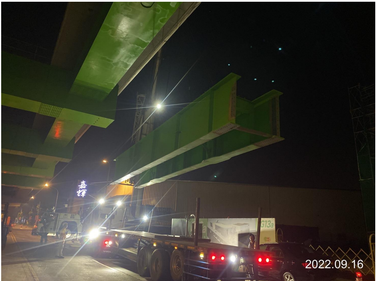
蘆竹中正北路 G13a 車站鋼構吊裝
