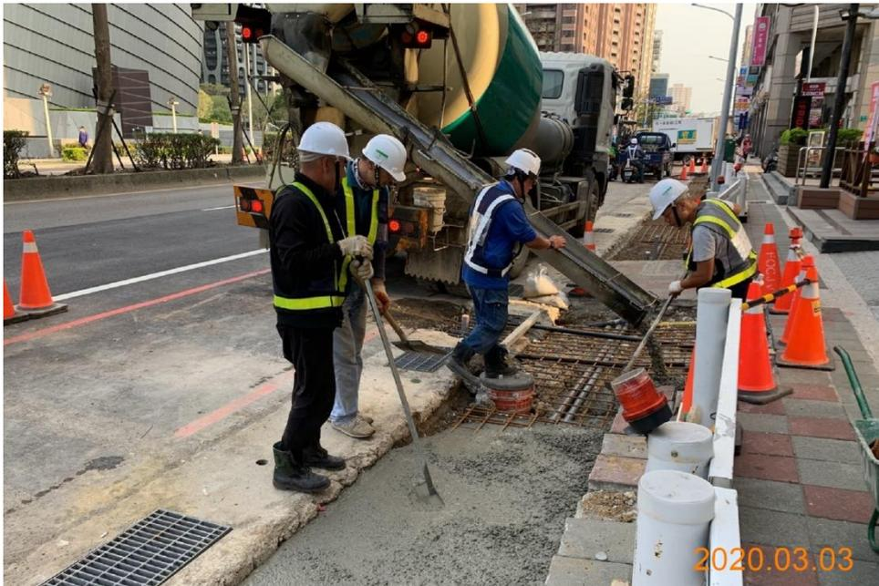
G11 站中正路西側(同德六街至南平路)人行道削減鋪面及場鑄臨時溝蓋板混凝土澆置
