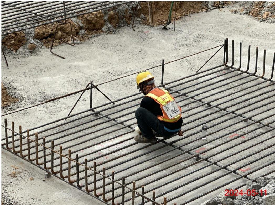
北機廠備品倉庫基礎鋼筋綁紮作業
