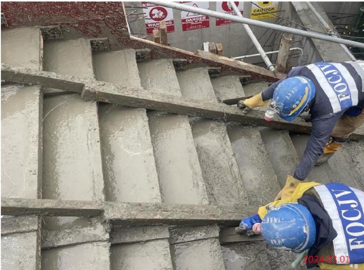
G12\_出入口 A 夾層樓梯混凝土澆置
