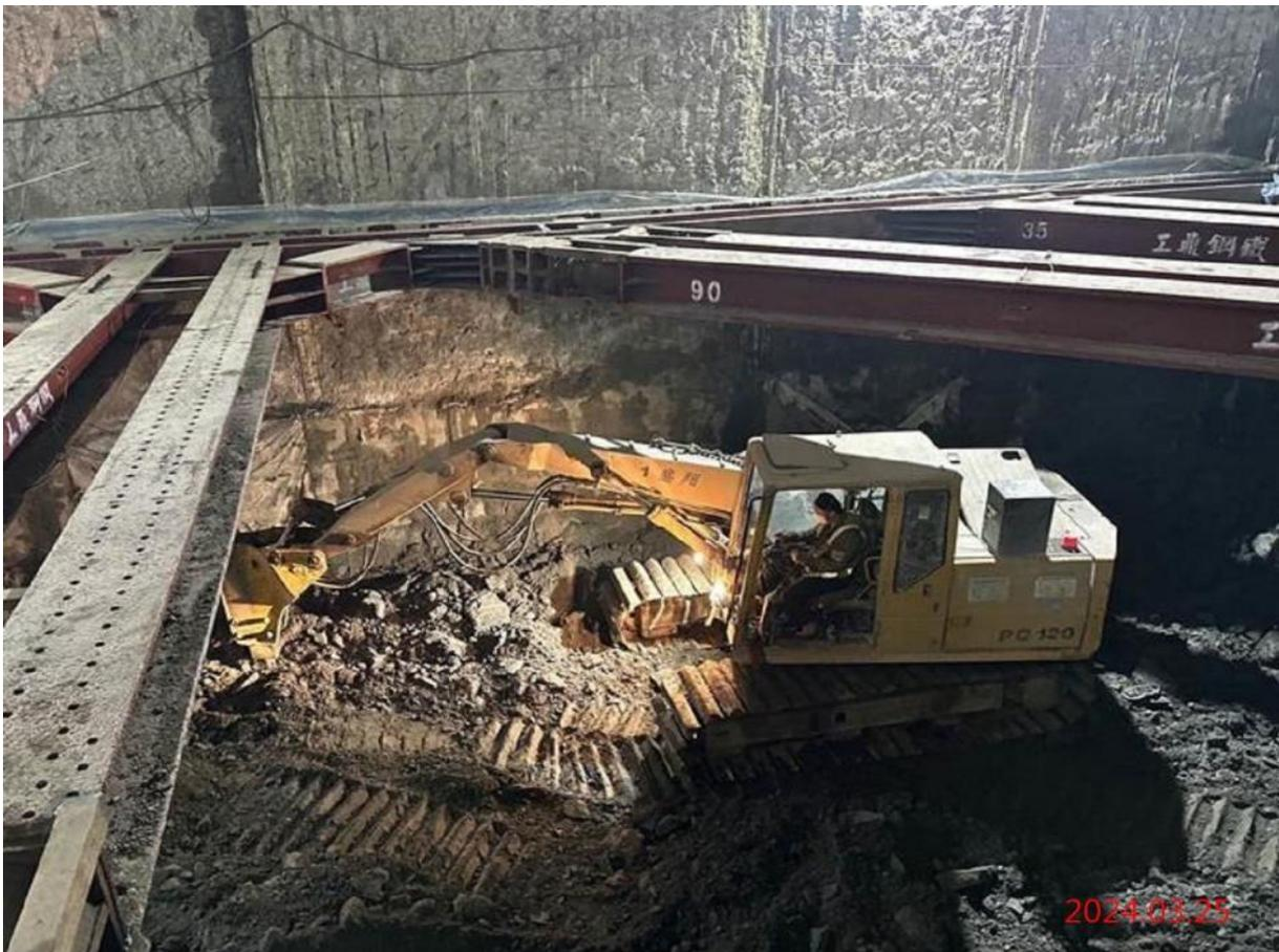
G07\_結構 B3F 軌道層土方開挖
