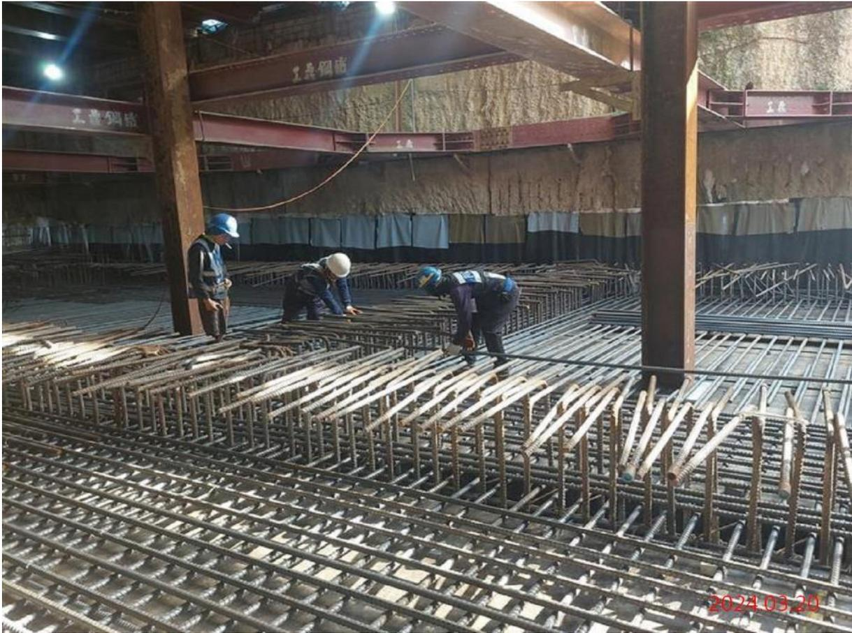
G11\_出入口夾層版鋼筋加工綁紮
