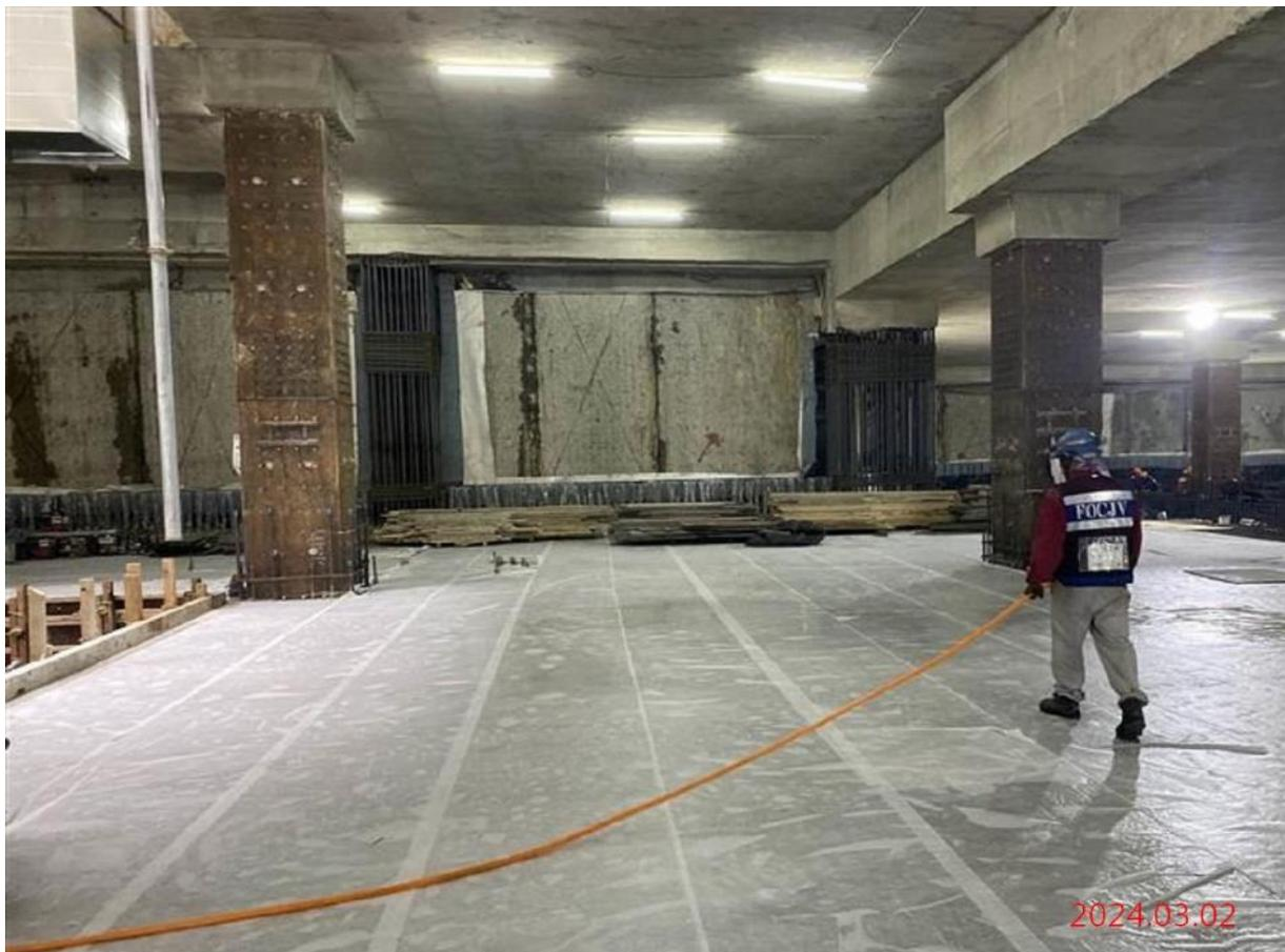
G07\_結構 B3F 樓板混凝土養護
