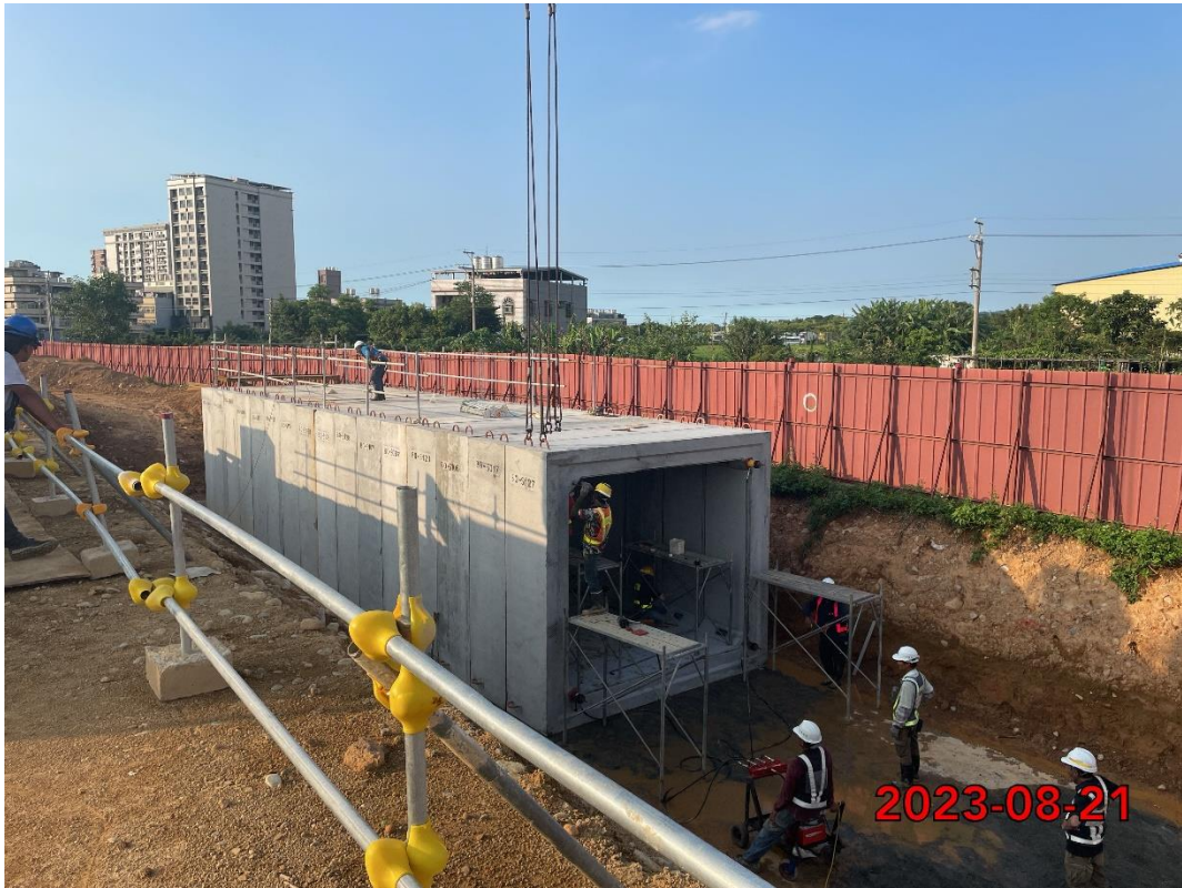
北機廠-B0 預鑄箱涵吊裝作業
