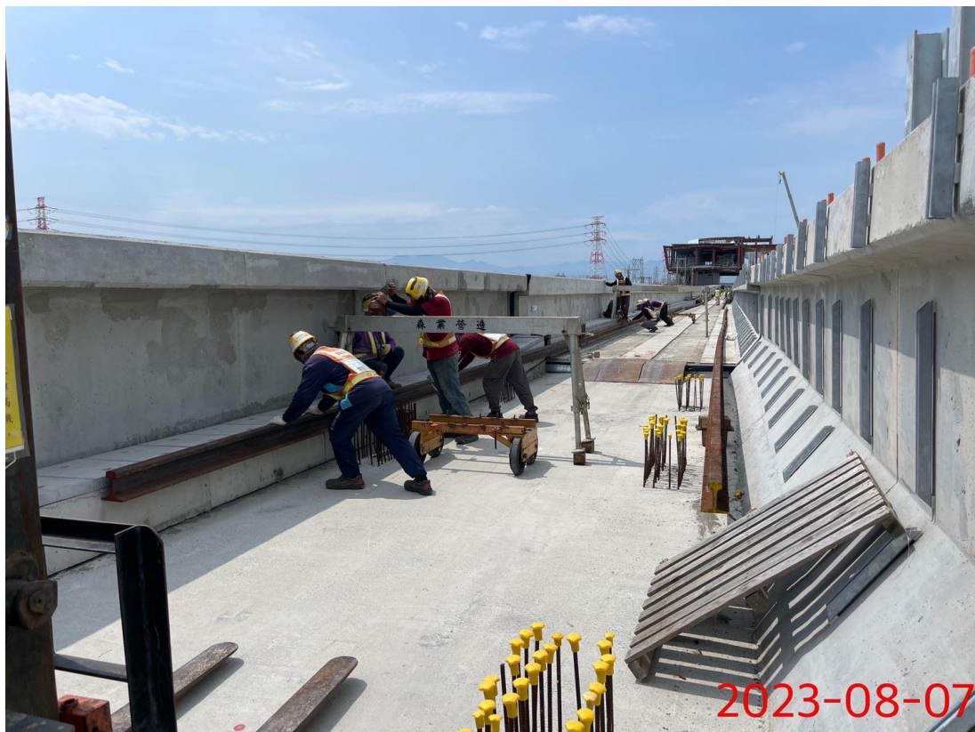
G13a~G14~NBHI 鋼軌整頓及佈設
