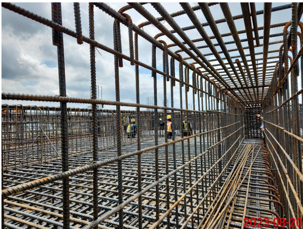
北機廠-駐車廠辦公室基礎版鋼筋綁紮
