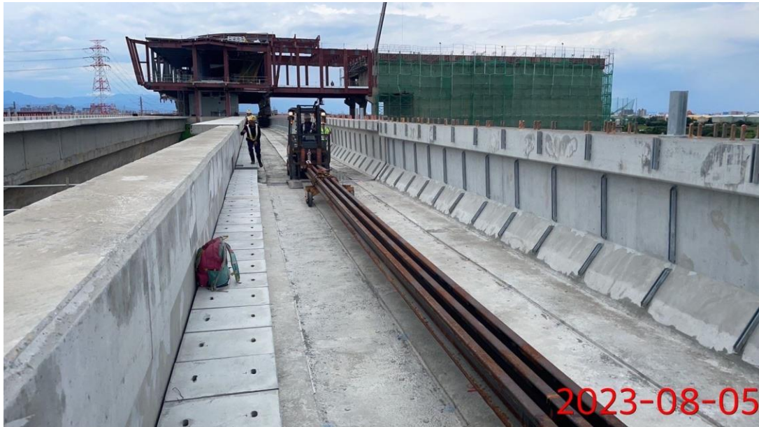
G13a~G14 鋼軌整頓及佈設
