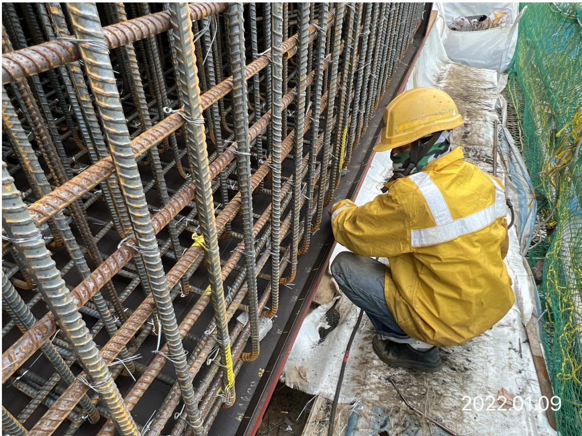
蘆竹蘆興街 帽梁鋼筋綁紮
