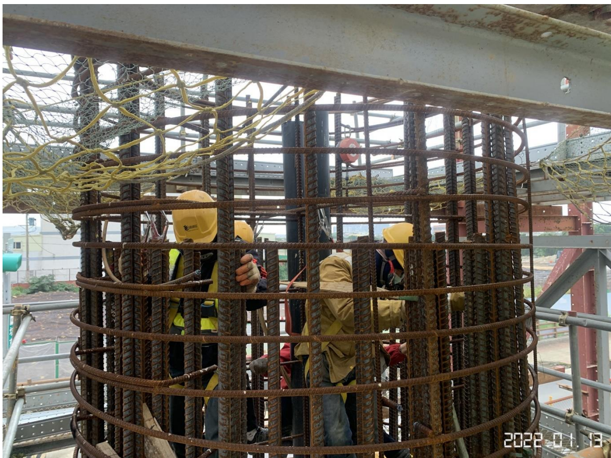
大園坑菓路 墩柱鋼筋綁紮
