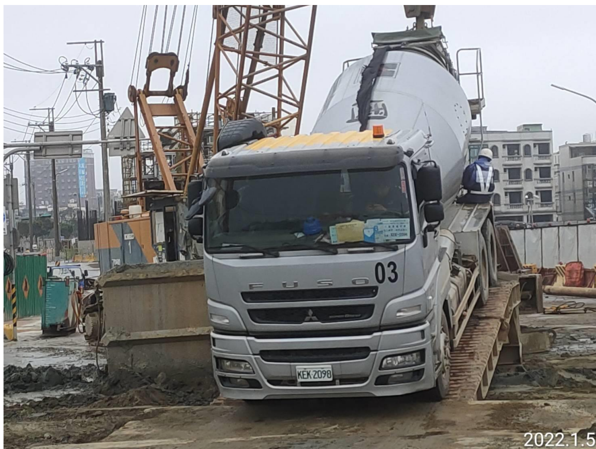
大園坑菓路 基樁混凝土澆置
