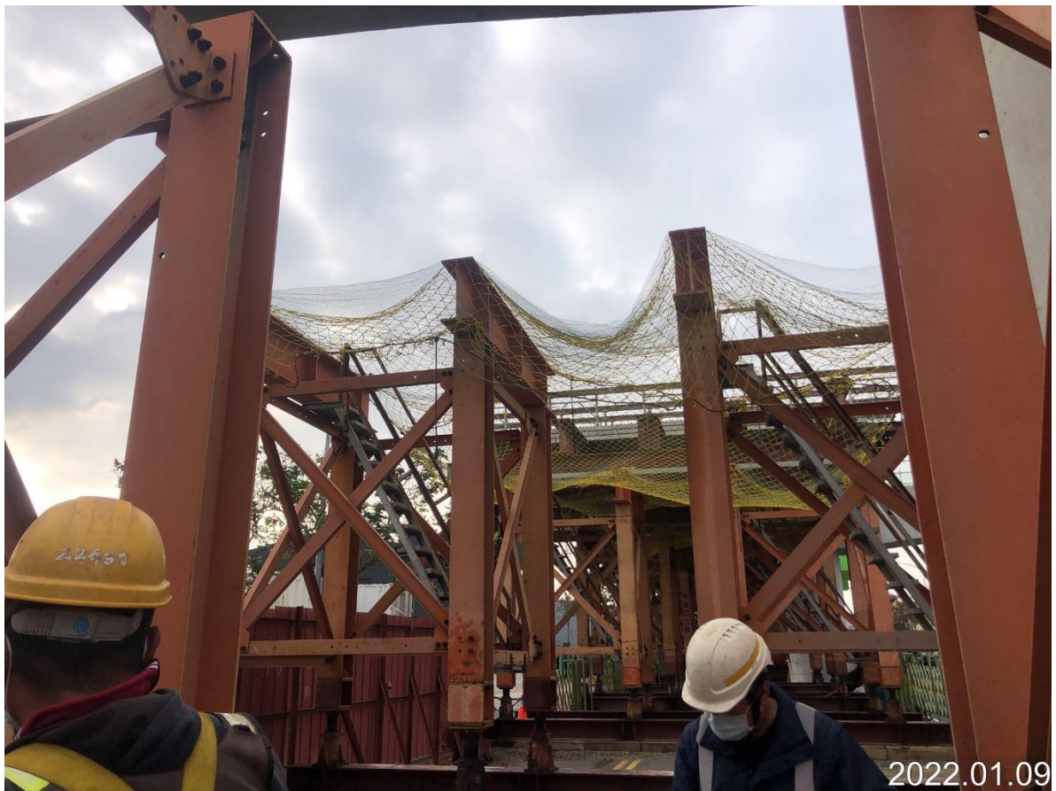
蘆竹中正北路 場撐箱型梁模板組立
