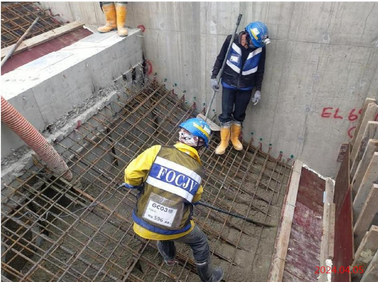
G12\_出入口 A 夾層電扶梯版混凝土澆置
