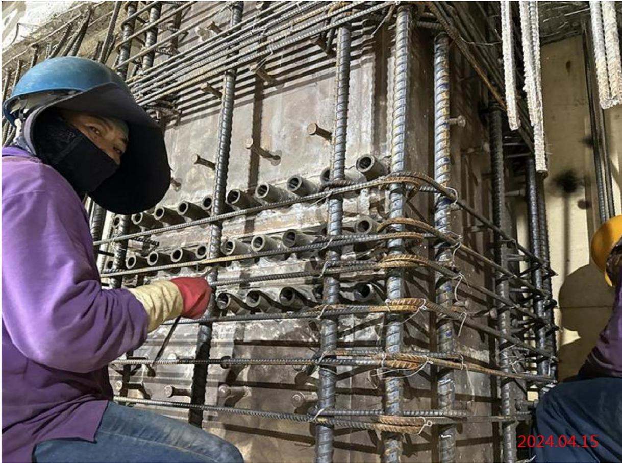
G07\_結構 B3F 第一區 SRC 柱鋼筋綁紮
