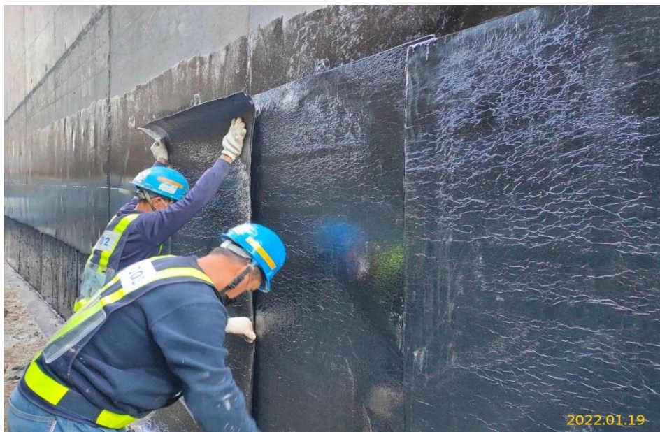
南出土結構體牆身防水膜施作
