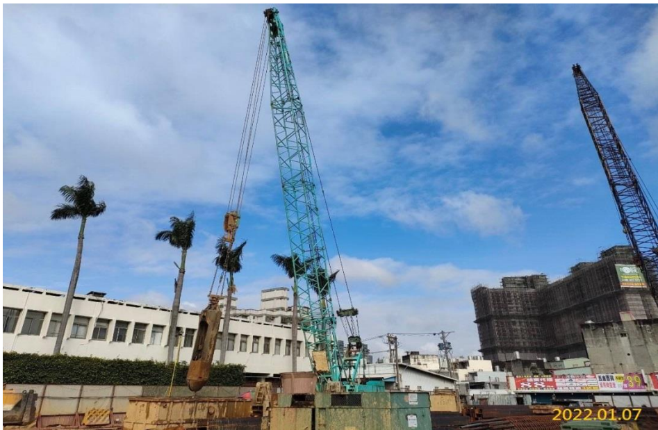
G05 站中間柱施作
