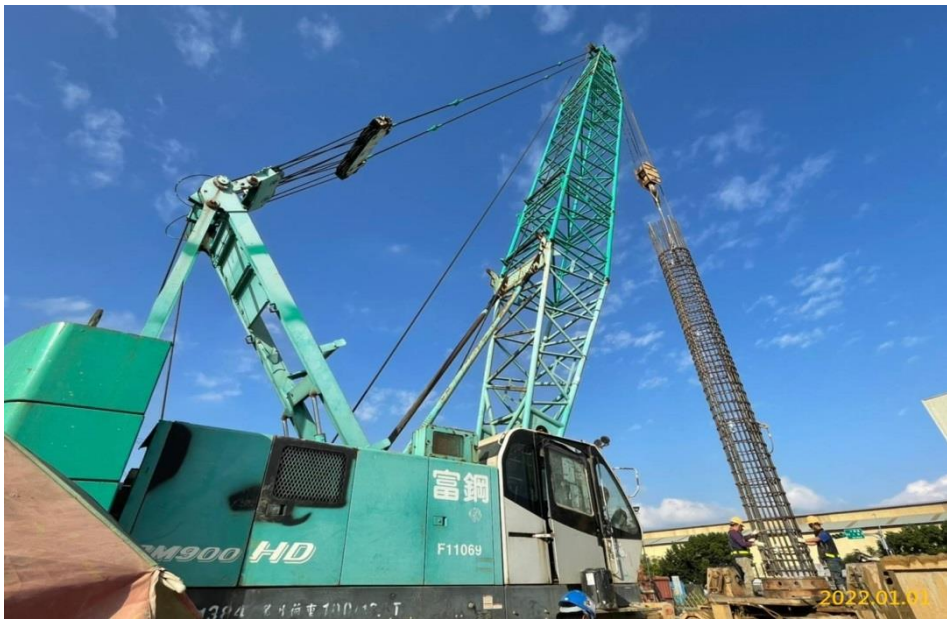
G03 站中間柱施作
