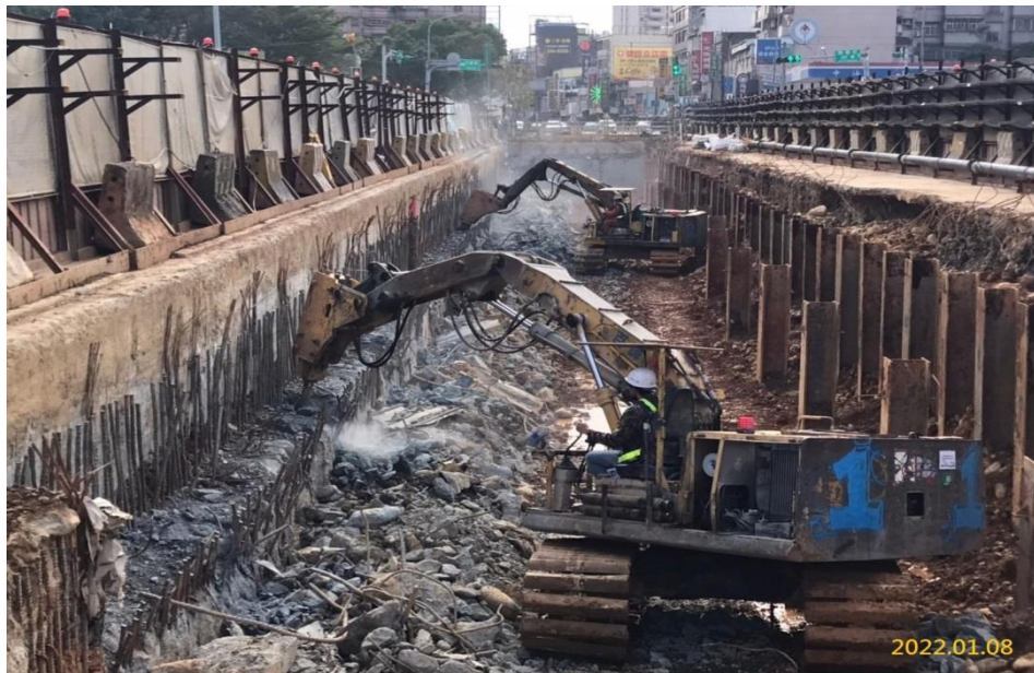
G06 站連續壁壁面修飾作業
