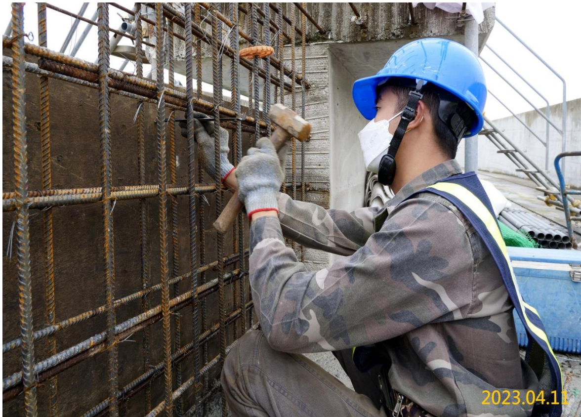
南出土段結構體模板組立
