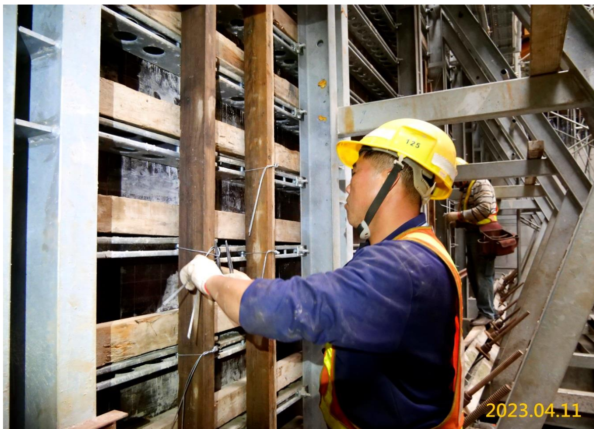
VS6 通風豎井結構牆系統模板組立
