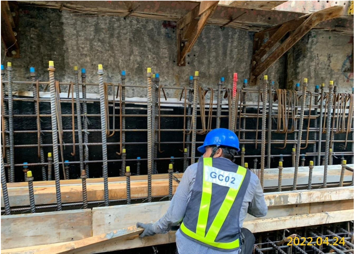
南出土段結構體止水帶安裝
