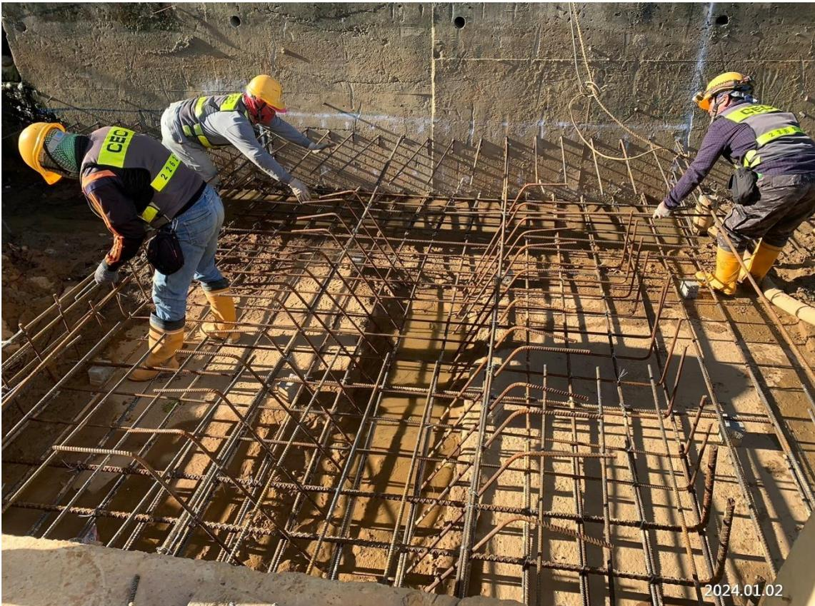
G13 車站出入口擋土牆及箱涵基礎鋼筋綁紮
