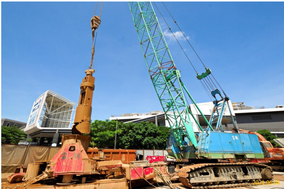
VS4 通風豎井中間柱施作
