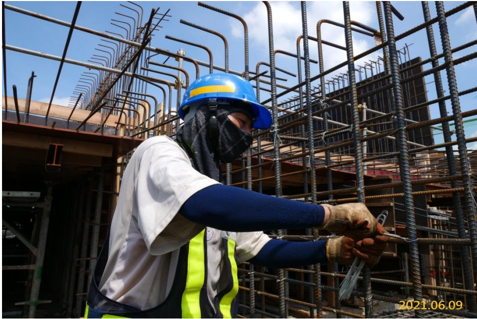
南出土結構體單元鋼筋綁紮
