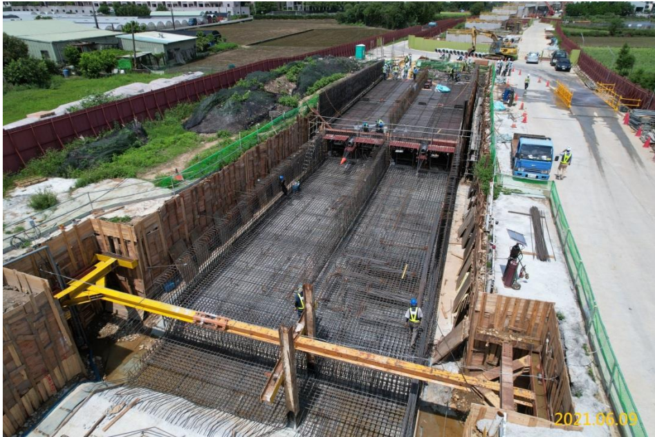
南出土段結構體施作
