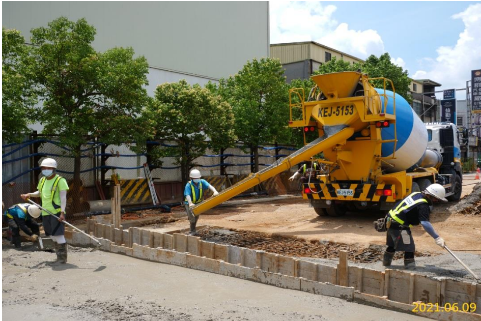
G03 站連續壁導溝鋪面施作
