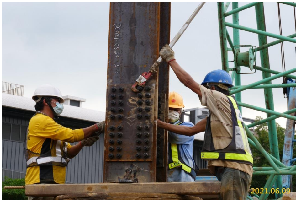
VS4 通風豎井中間柱施作
