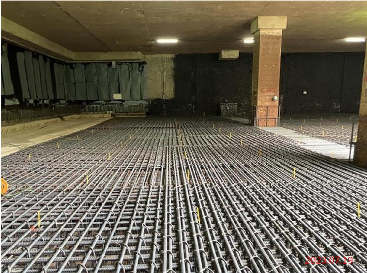
G07 站\_站體結構 B1FL 鋼筋綁紮
