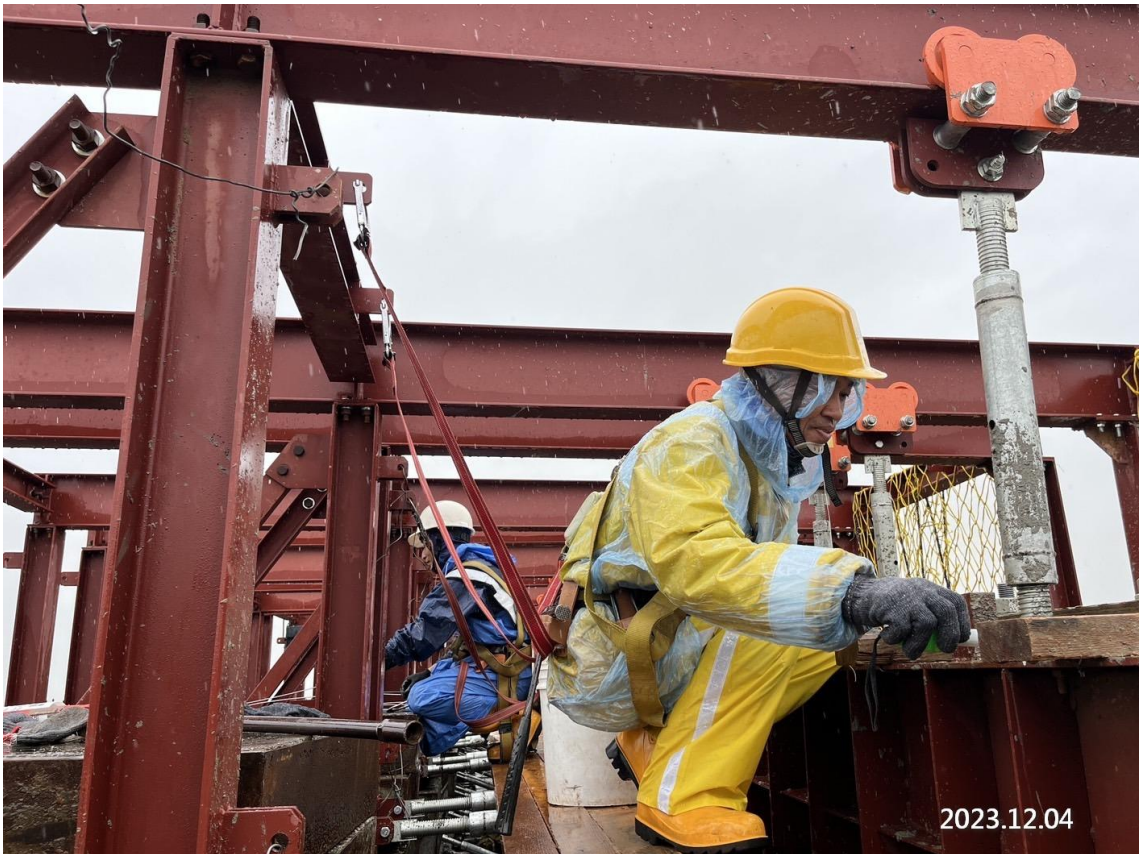
P14-32~P14-31 下行線胸牆預埋件安裝
