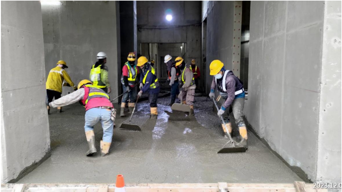
G14 車站出入口一樓及二樓混凝土墊層澆置
