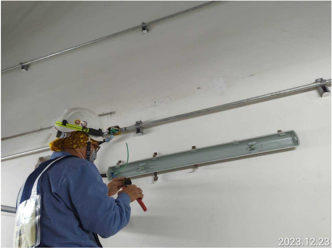
G13a 站電氣管路施作
