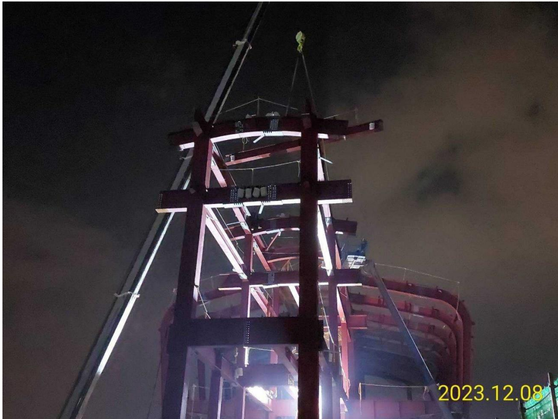
G14 站體鋼結構吊裝
