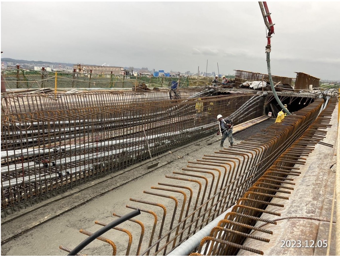
PD-1~PD-2 第二階段底版混凝土澆置
