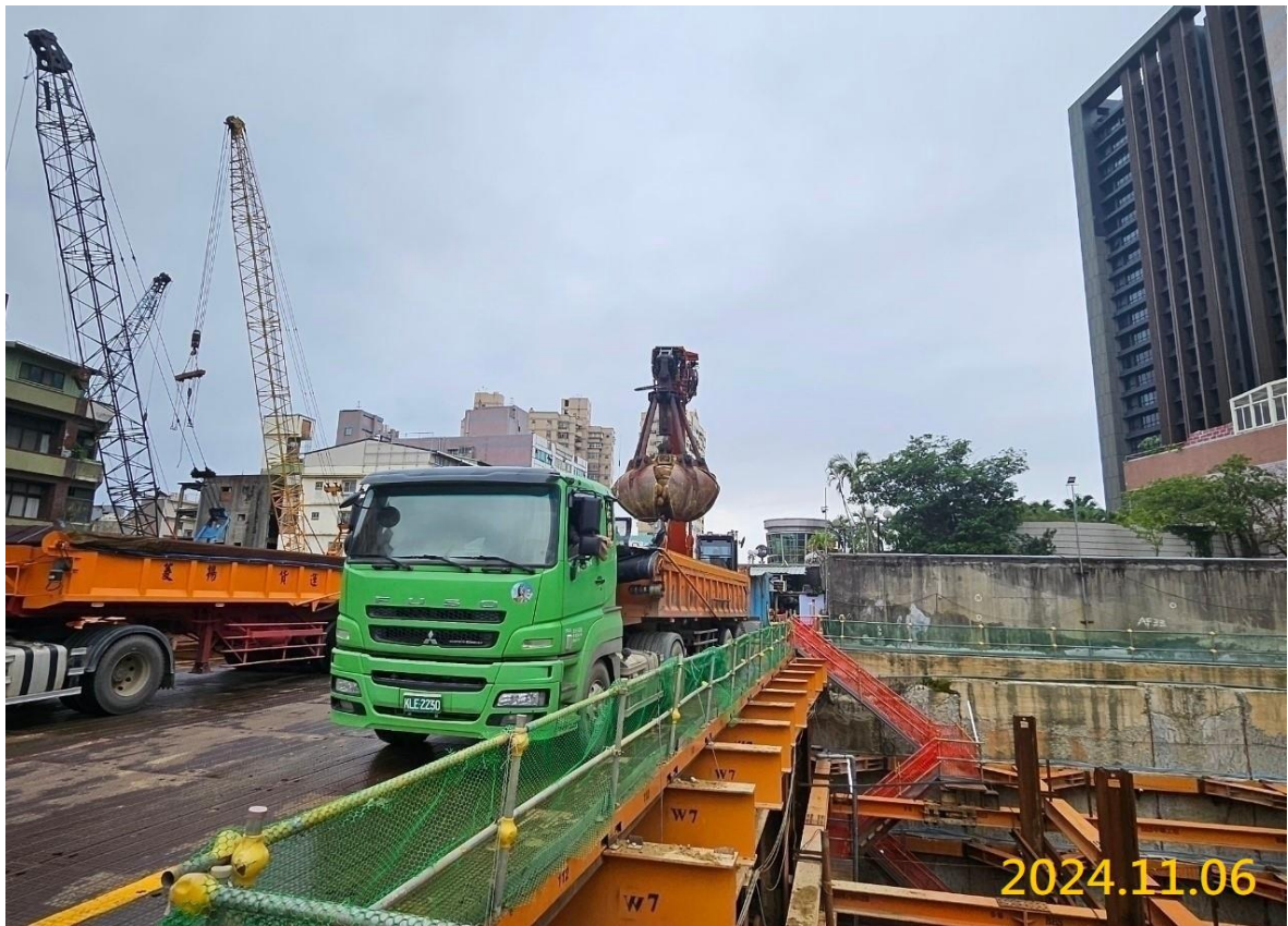
G04 出入口土方開挖作業
