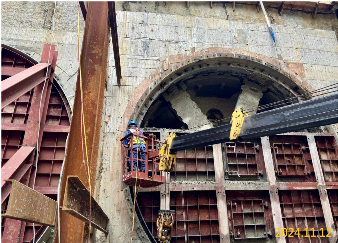
G03 站-南出土上行線潛盾隧道_到達艙拆除作業
