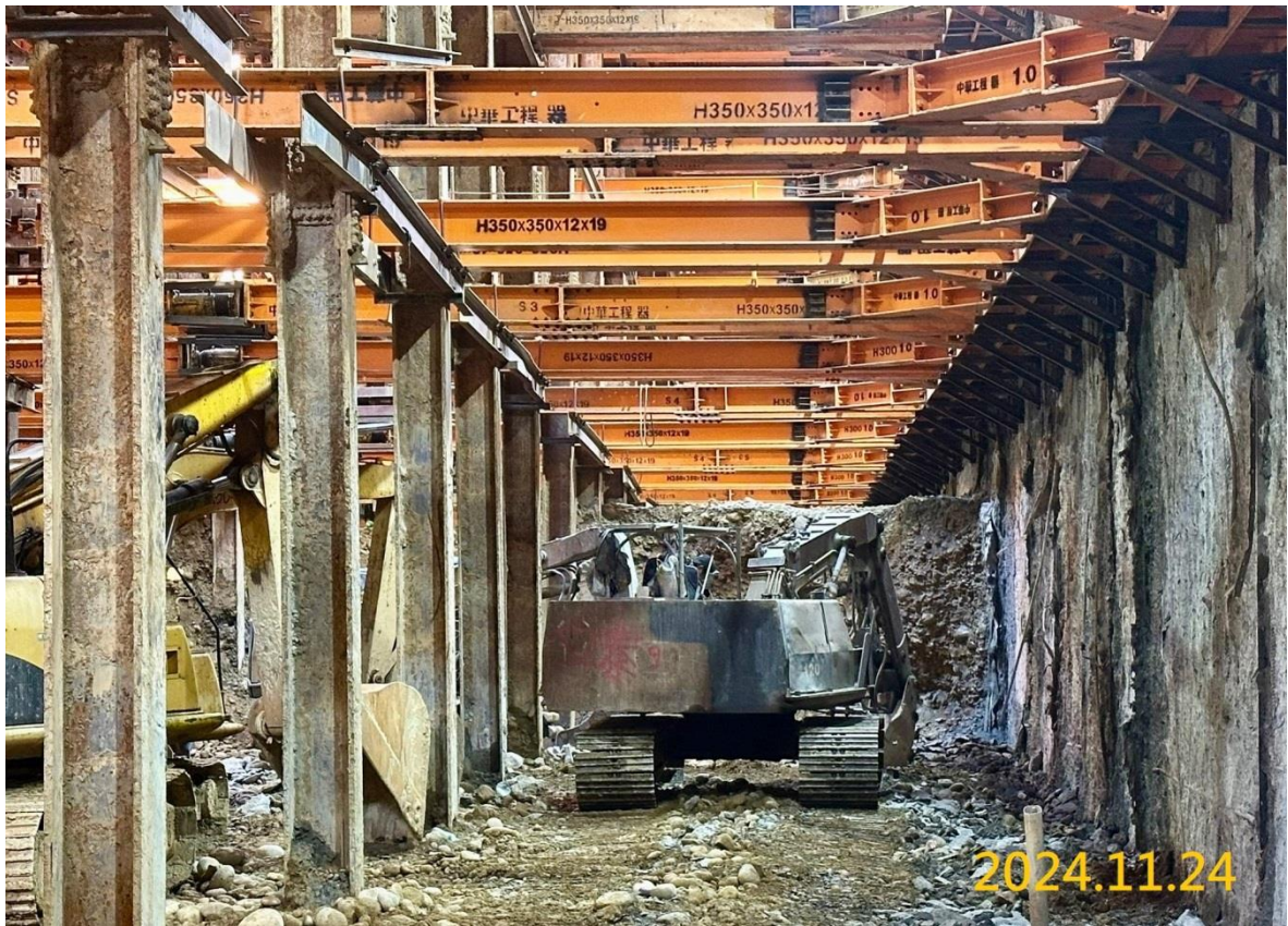
G06 站支撐架設
