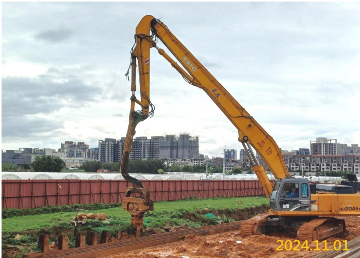
南出土段擋土設施拔除
