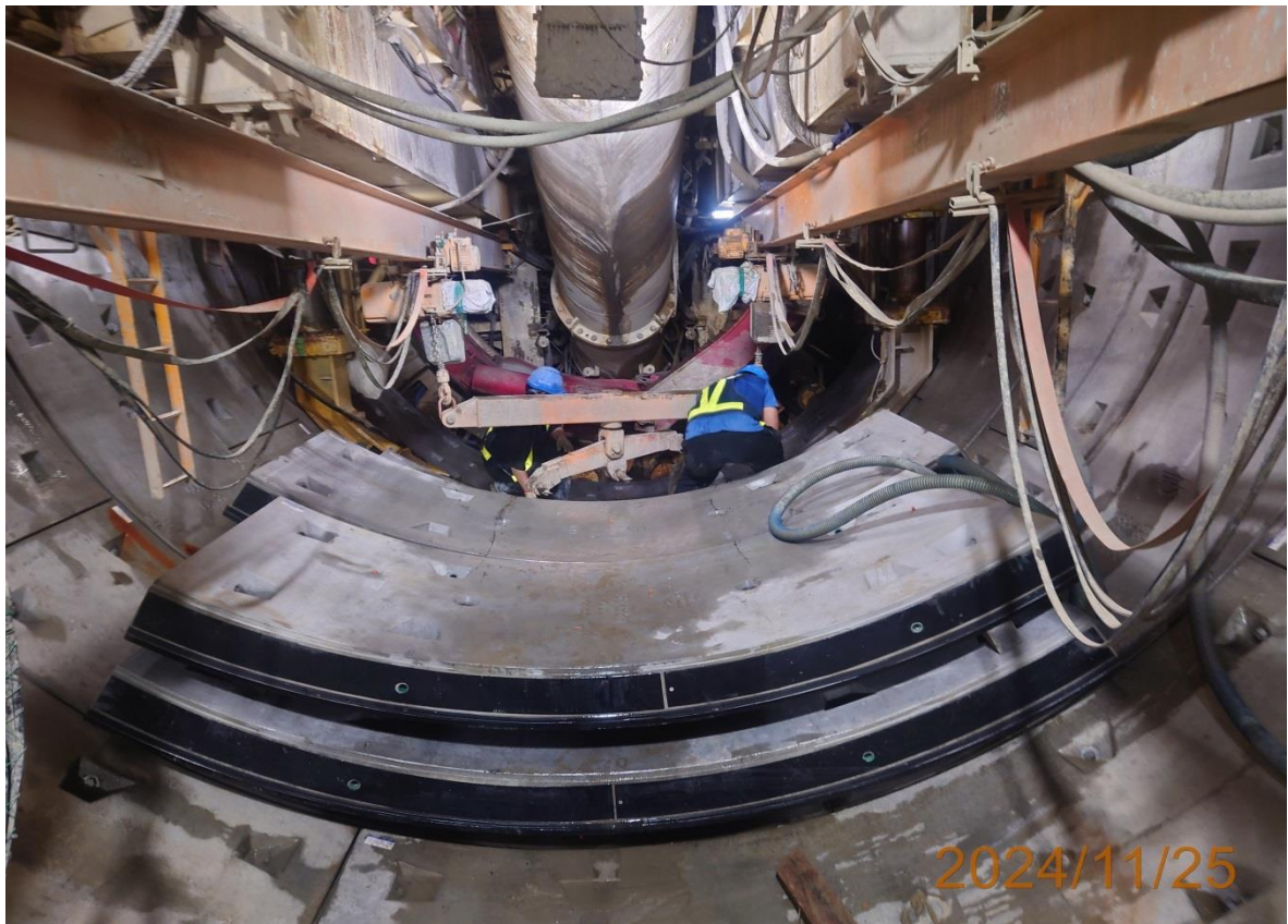
G03 站-南出土下行線潛盾隧道_掘進施作
