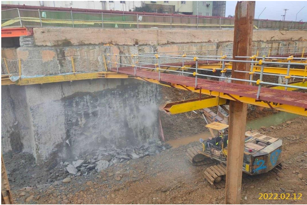
南出土結構體開挖後連續壁面修飾
