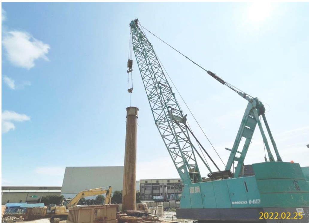
G03 站中間柱施作
