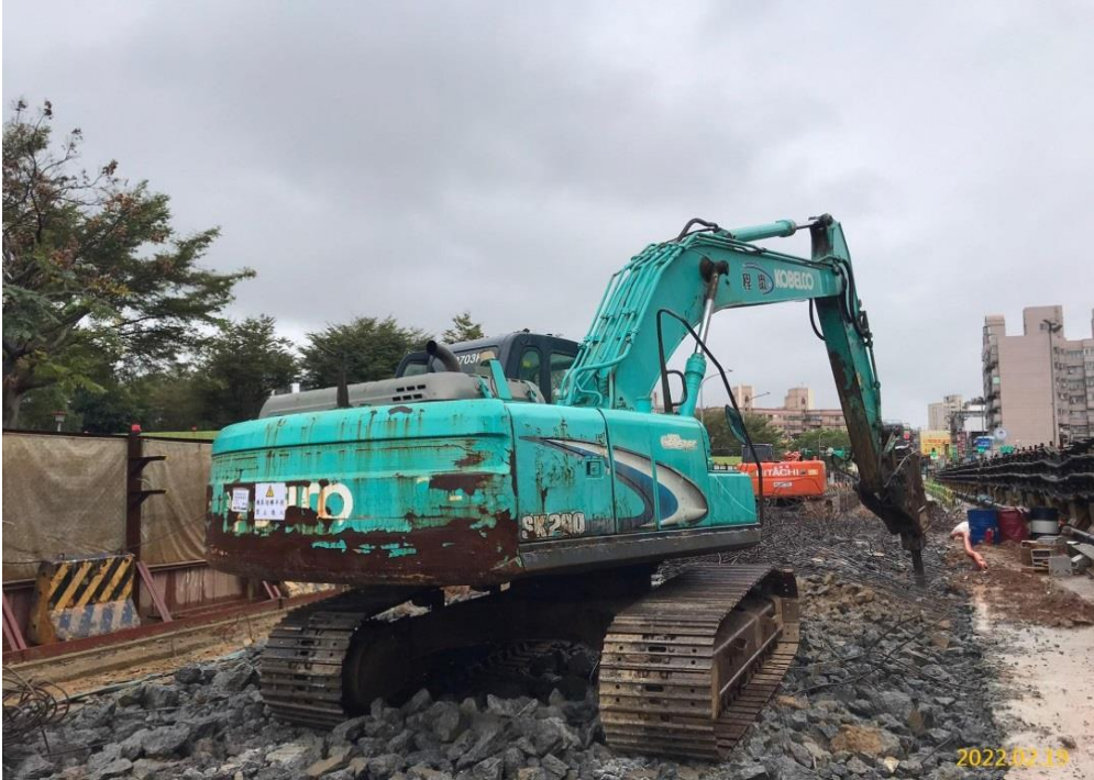
G06 站淺挖施作
