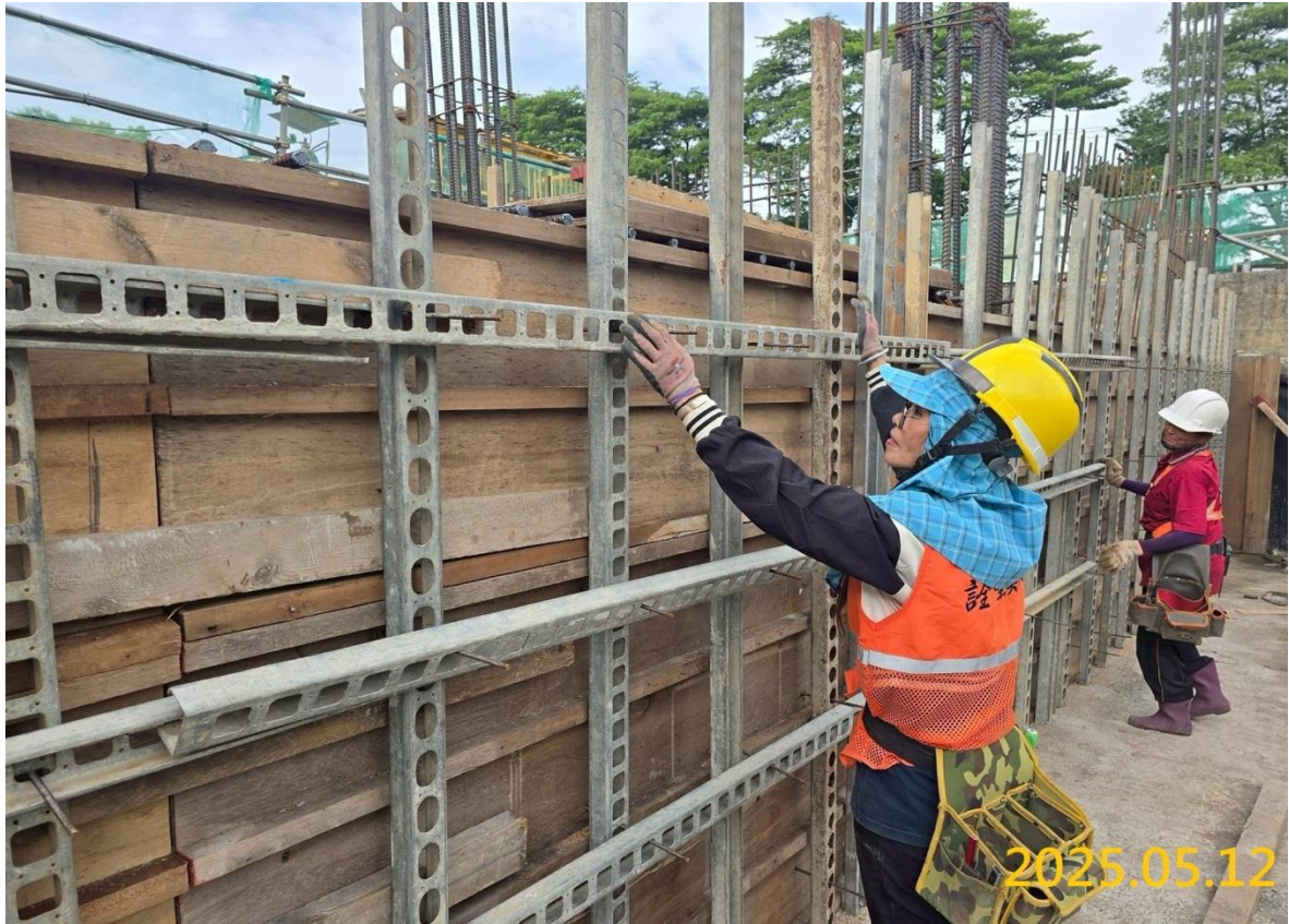
VS6 通風豎井地面層結構施作
