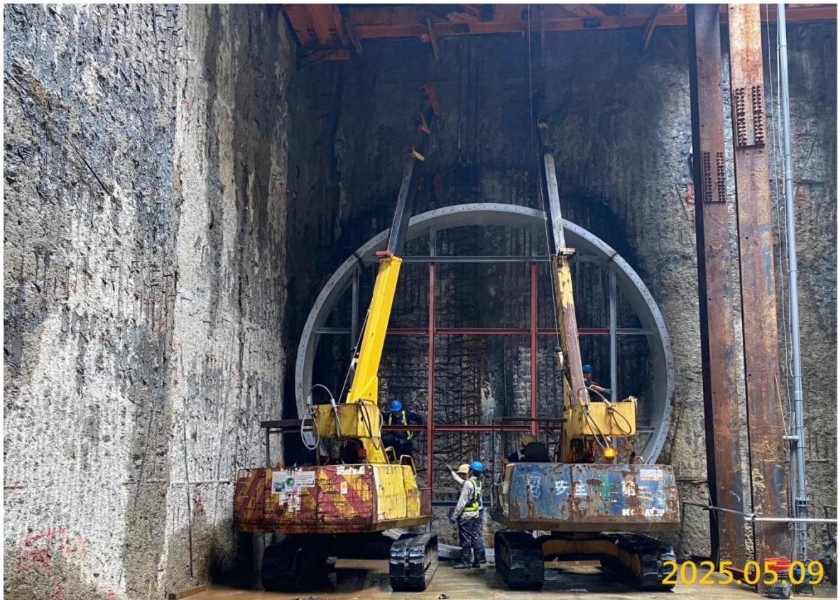
G05 站潛盾隧道鏡面框安裝
