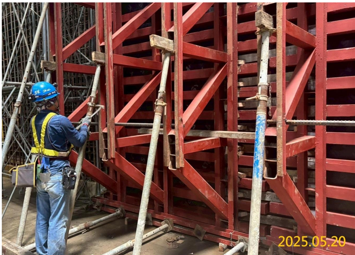
VS4 通風豎井路線段 B2F 結構牆施作
