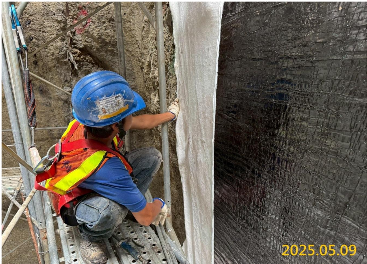
VS5 通風豎井 B2F 結構牆防水膜施作
