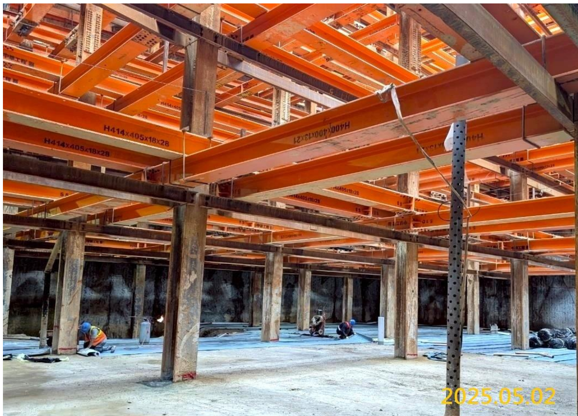
G04 出入口 B 底板防水膜施作
