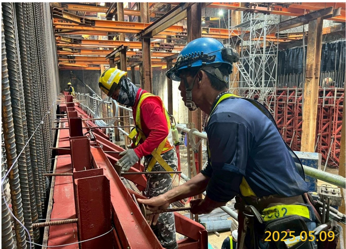
G05 站 B2F 結構牆施作
