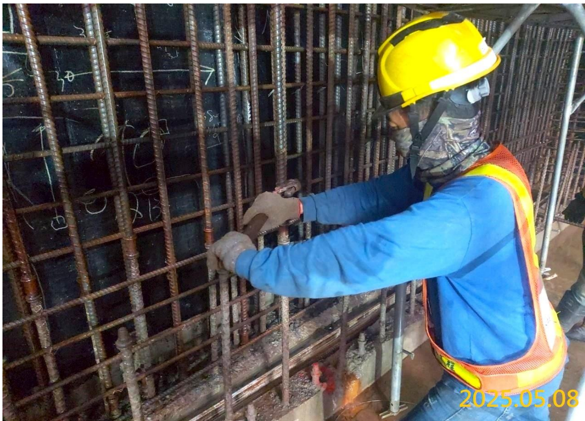
G03 出入口 A B3F 結構牆施作
