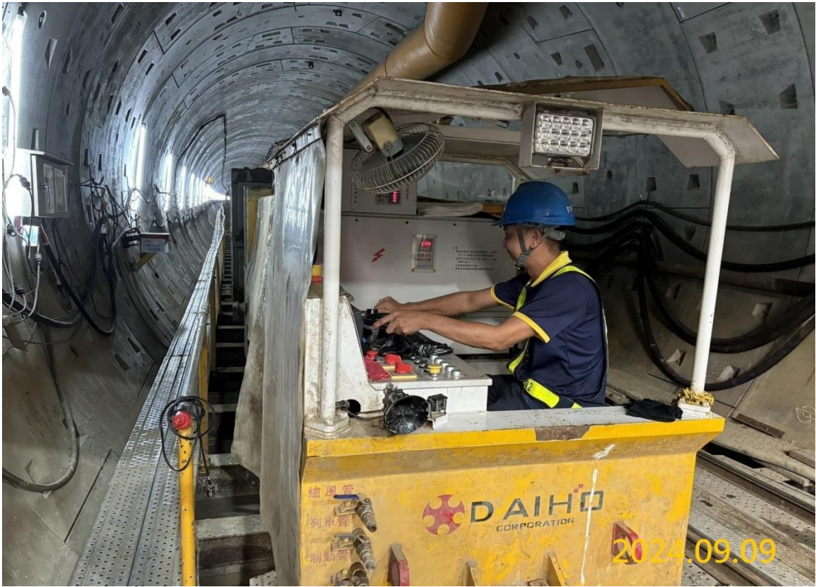
G03 站潛盾隧道掘進施作
