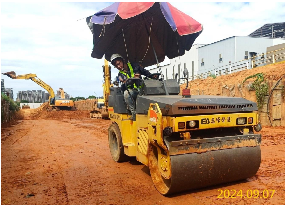
南出土段結構回填
