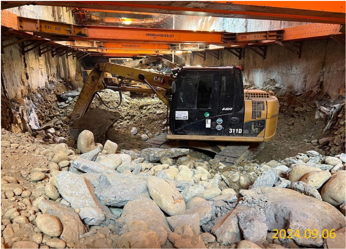
維修軌開挖施作
