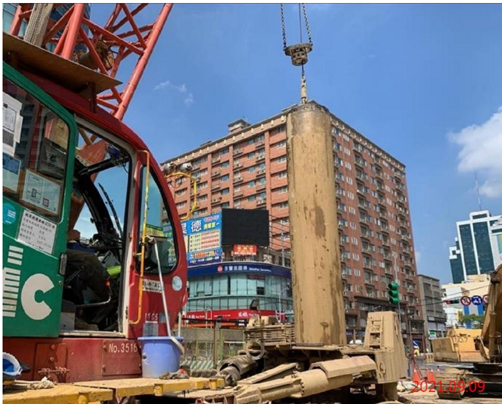
G11 站_中間柱施作
