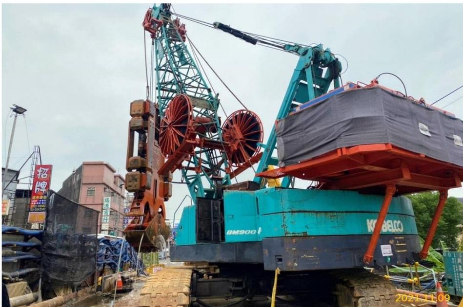
VS4 通風豎井中間柱挖掘作業
