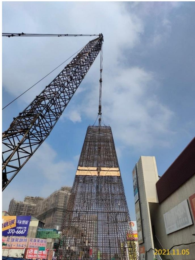
G05 站鋼筋籠吊運作業
