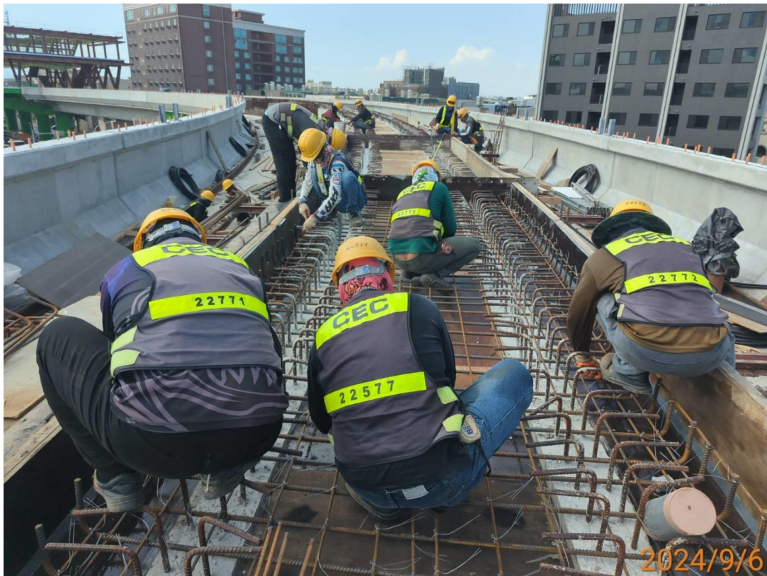
GC01_自辦組_DU31-02 中間步道(鋼筋綁紮綁紮)
