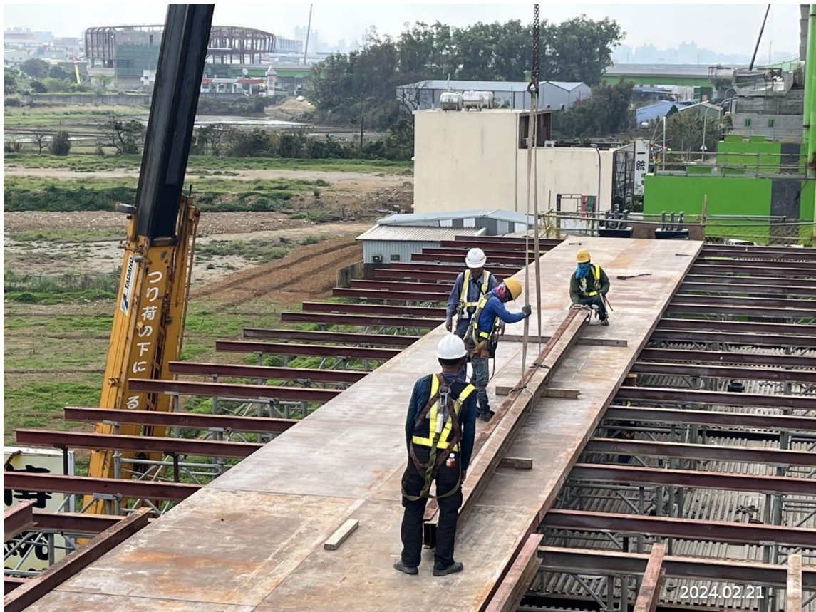
北段上構_DU14-07 上行線支撐架組立
