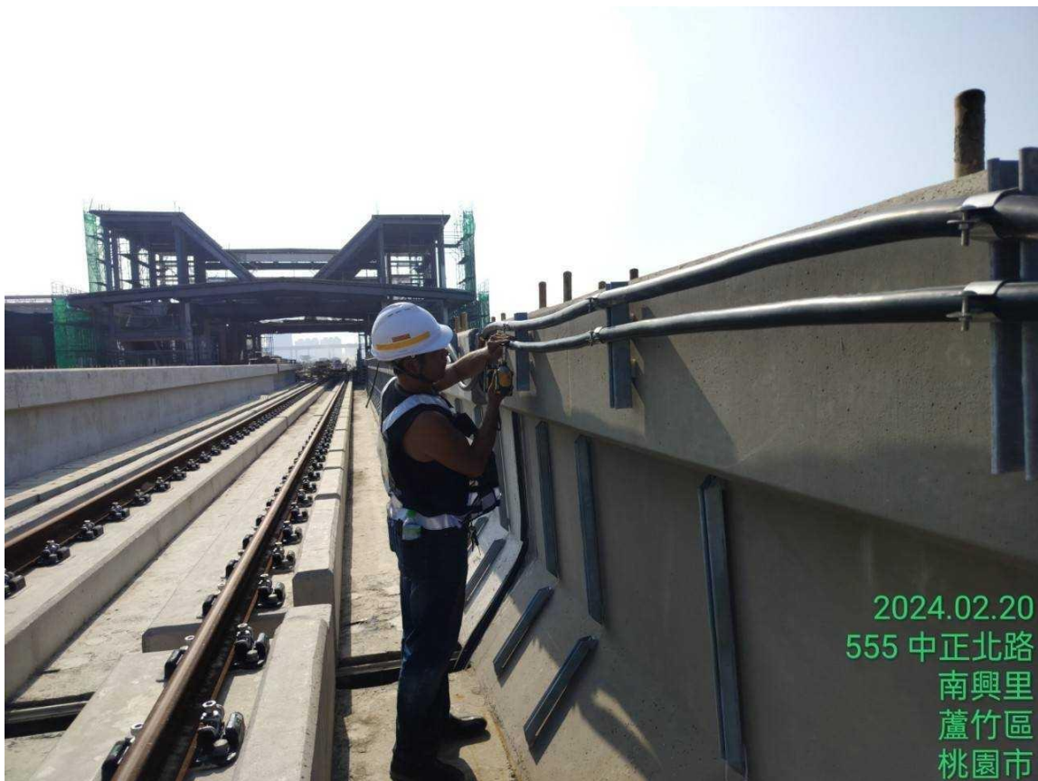
G13 車站高架佈覽施作
