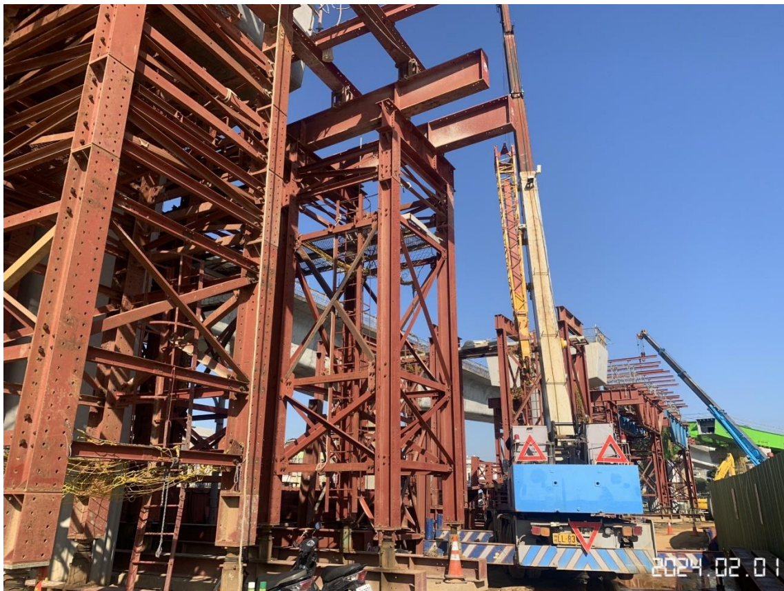
北段上構_PD-2~PD-3 第三階段支撐架組立
