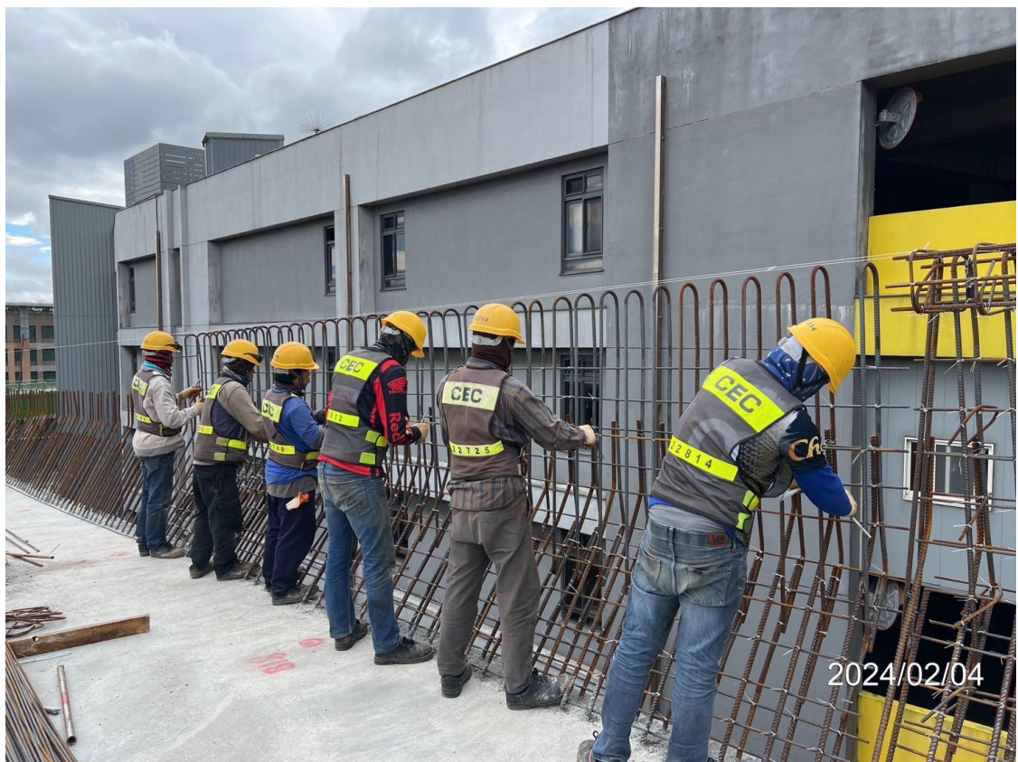
DU13a-09 橋梁胸牆鋼筋綁紮
