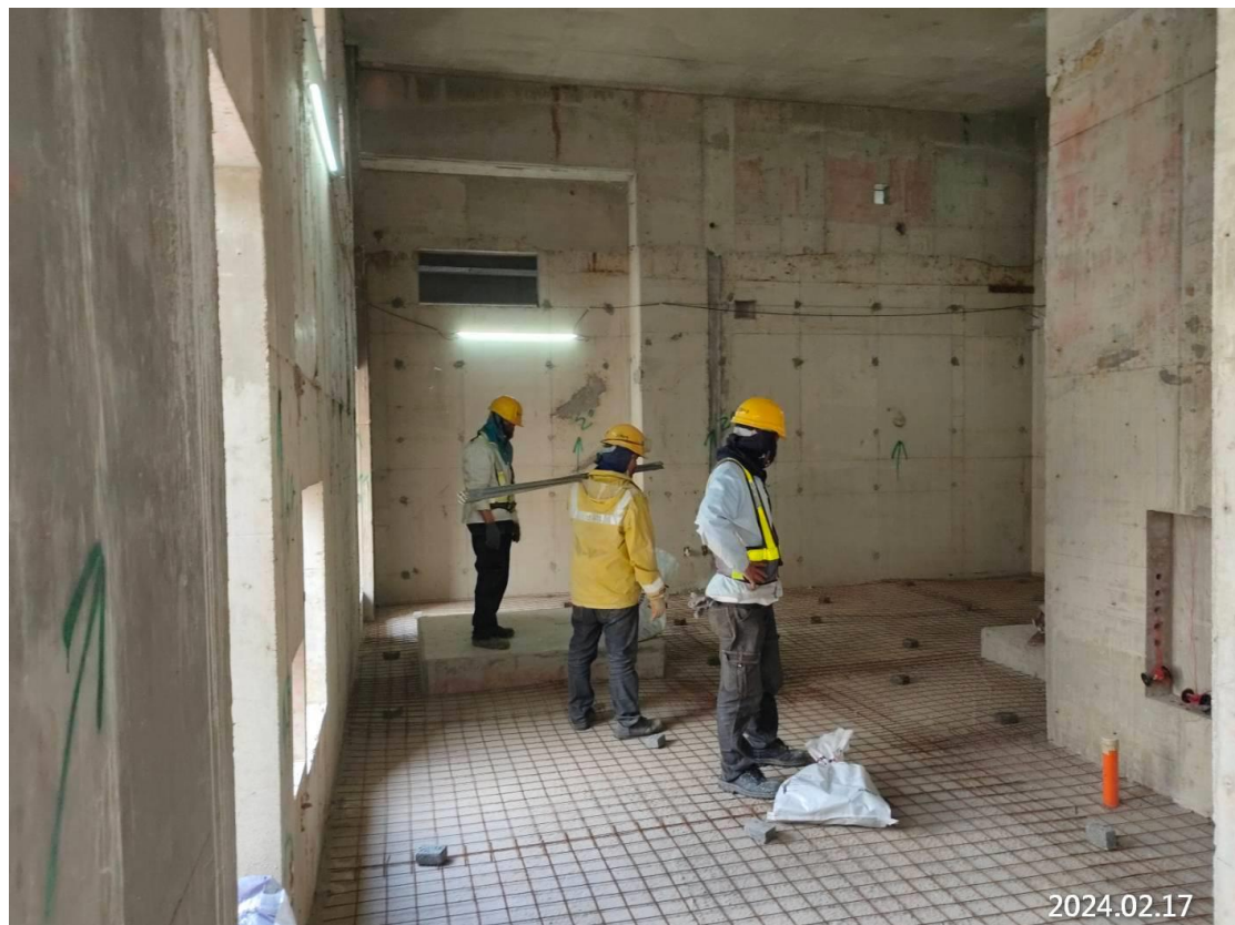
南段_G01 車站出入口四樓墊層前置作業
