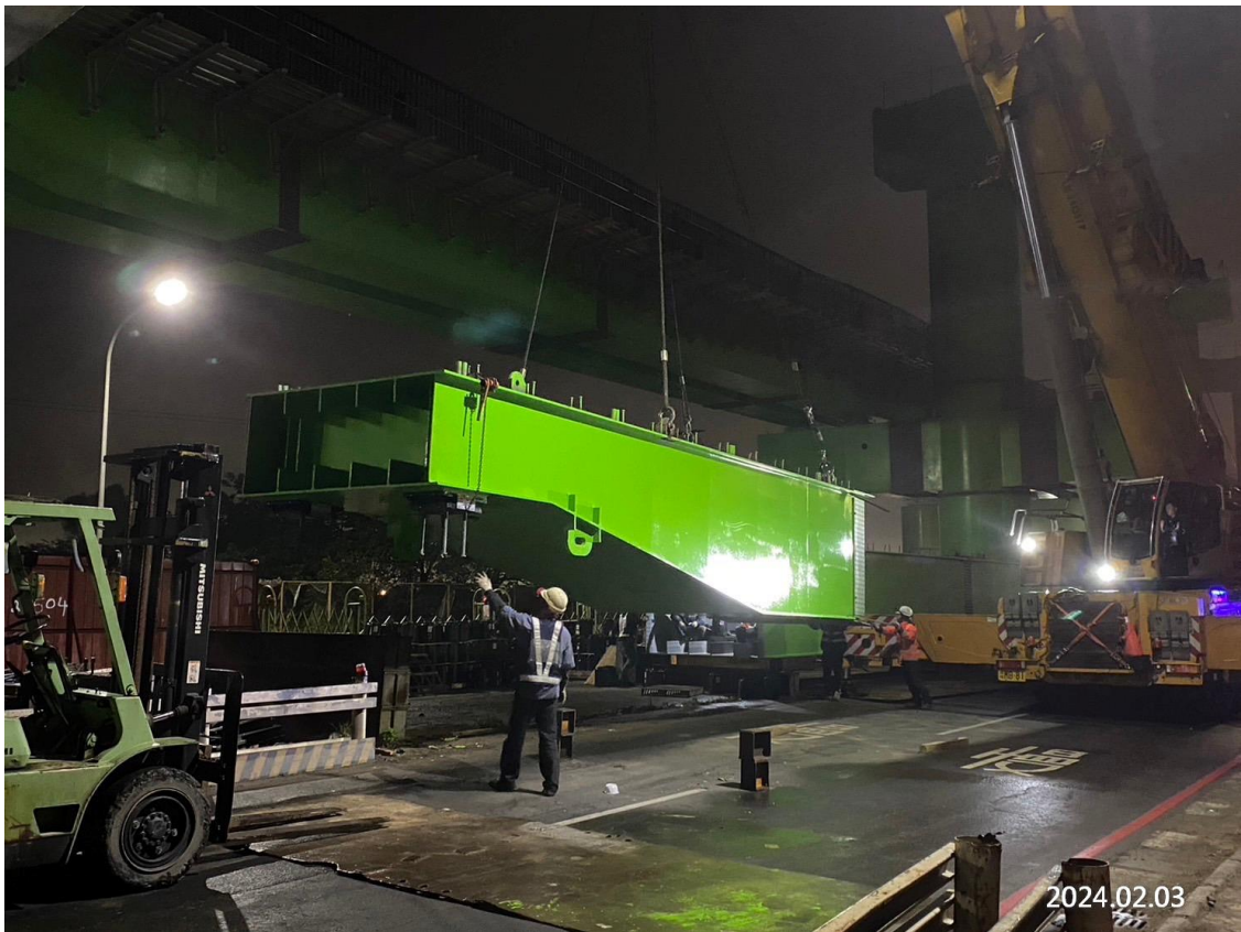
DU14-06 鋼箱梁進料地組 C01+C02 接合穿鎖
