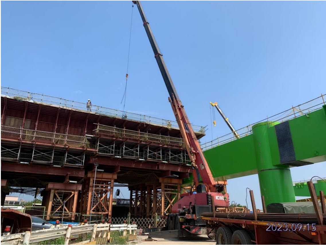
DU14-07 支撐架組立
