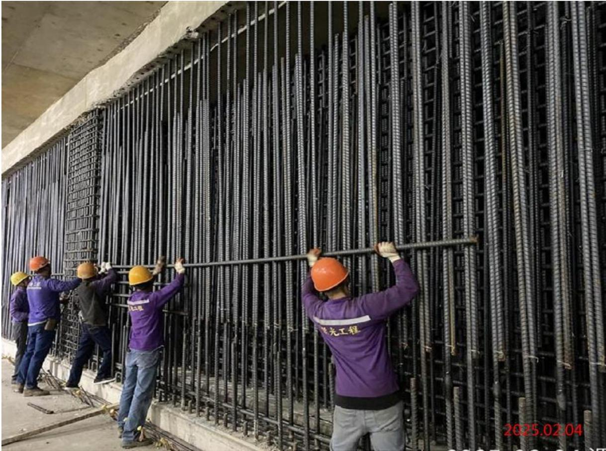
G07\_結構 B3F 柱牆鋼筋綁紮
