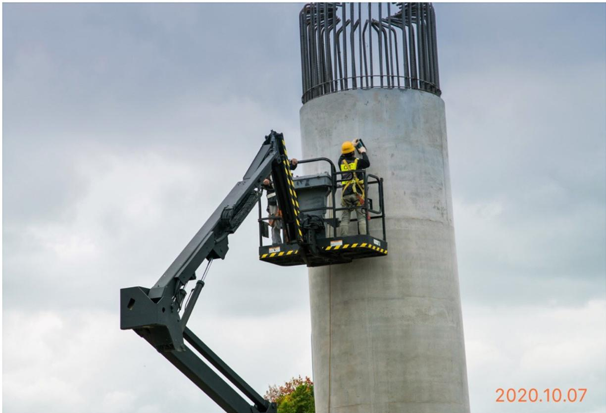
蘆竹中正北路 墩柱高空作業車除鏽
