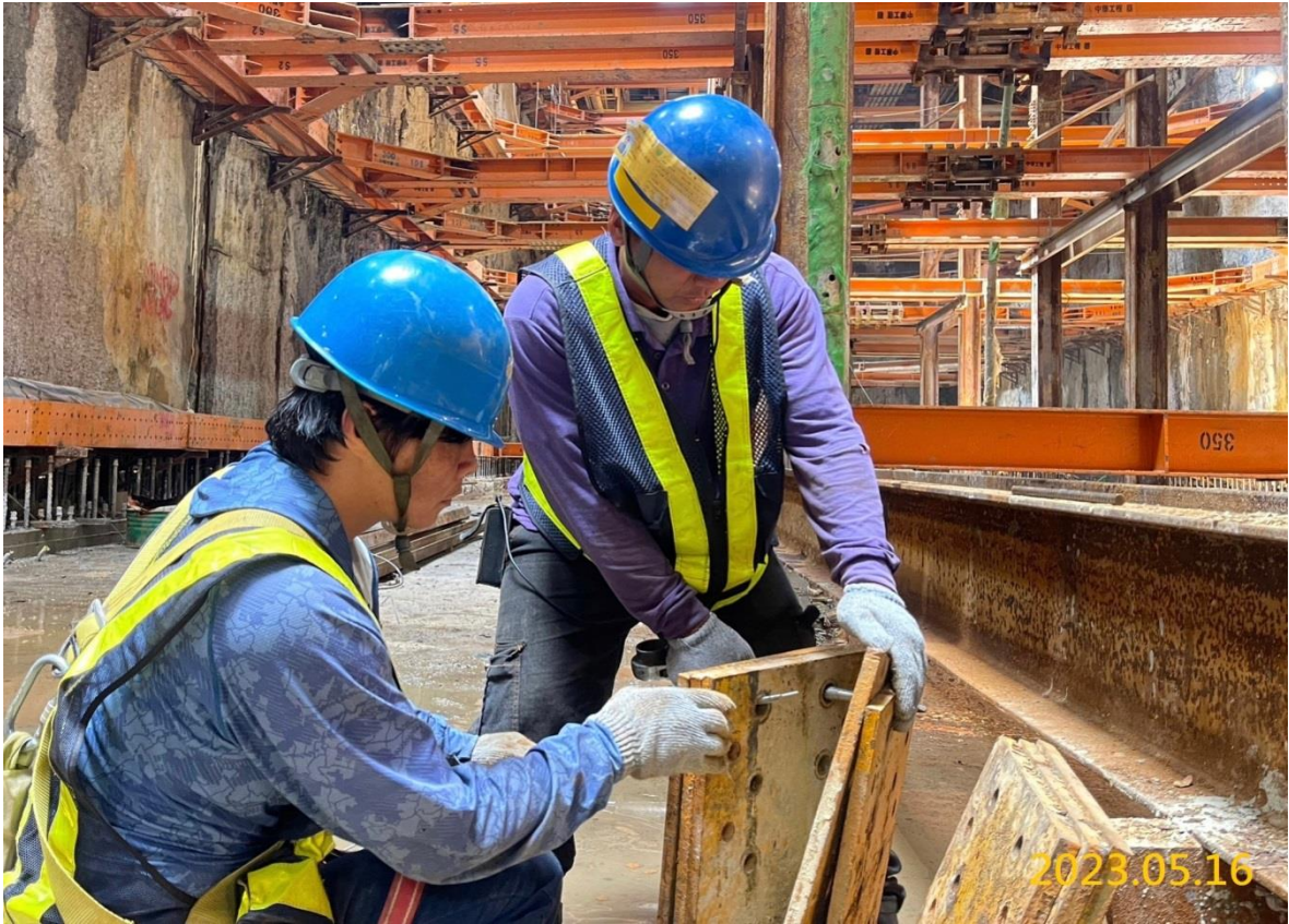
G03 站支撐施作
