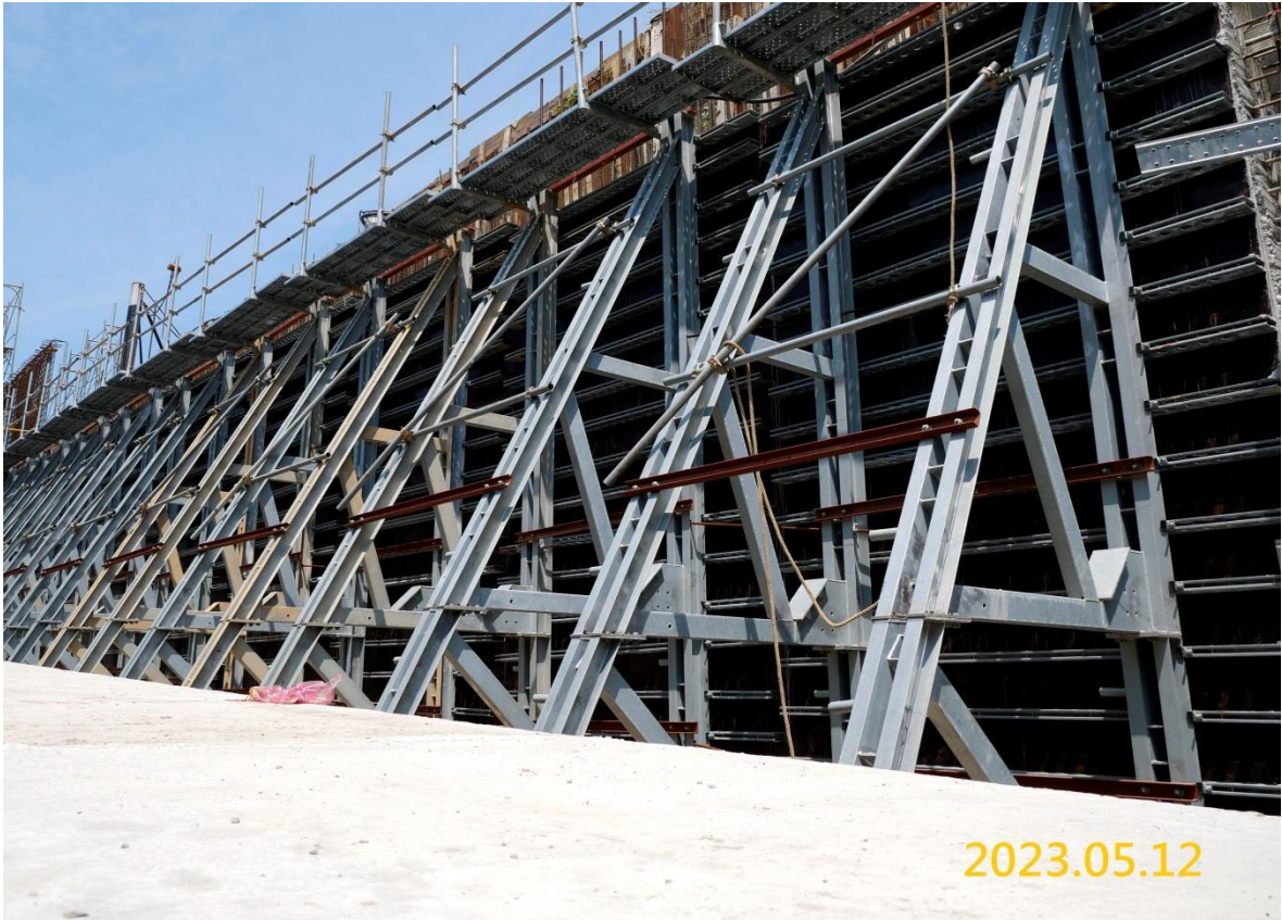
南出土段結構體施作
