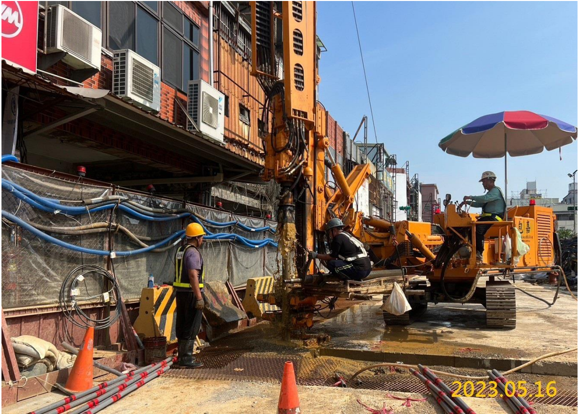
VS4 通風豎井地盤處理施作
