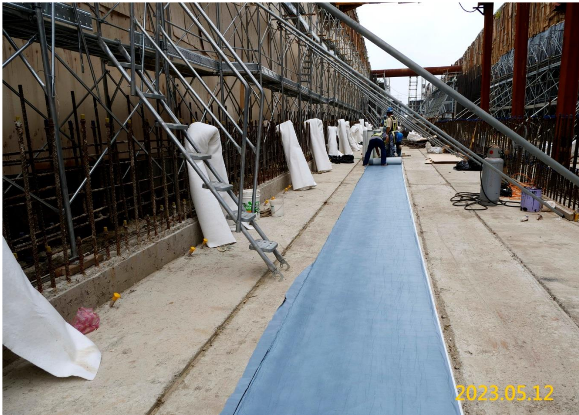
南出土段結構體防水膜施作
