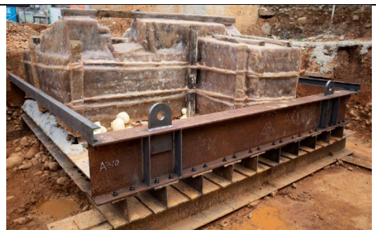
圖版31：提樑兩側以C型鋼聯結，避免變形
