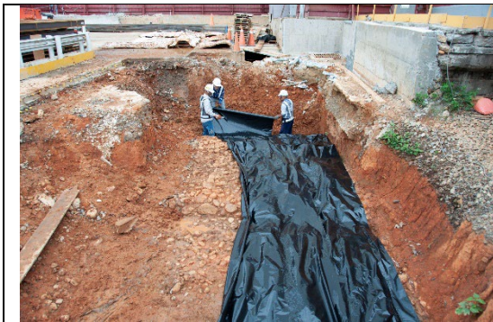
圖版2：塑膠布包覆隔離
