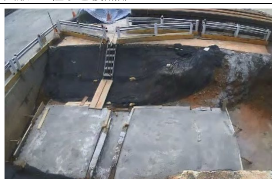
圖版5：水泥包覆隔離
