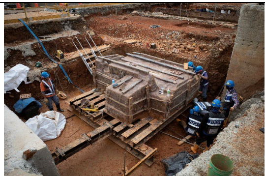
圖版27：調整H型鋼使其在同一水平面上
