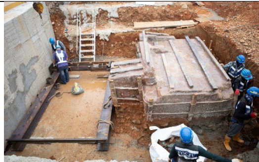
圖版22：架設導軌兩端底樑
