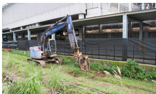
圖版50：試掘區域表土清除
