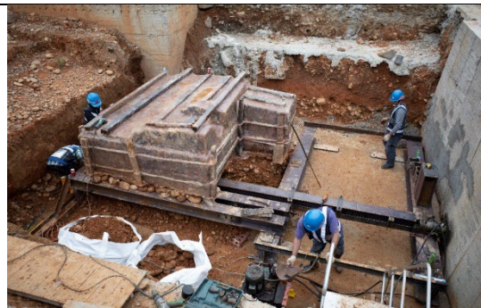
圖版25：固定間距依序導入H型鋼
