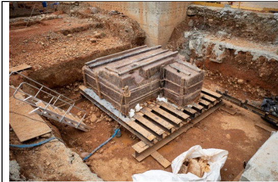
圖版28：縫隙以木塊、發泡劑填補
