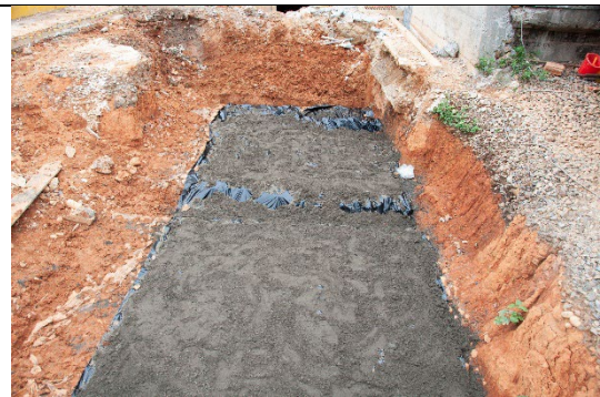
圖版3：粗砂包覆隔離
