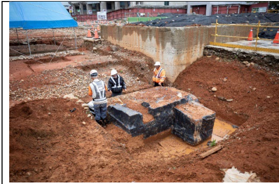
圖版16：遺構包覆塑膠布後再敷土整平
