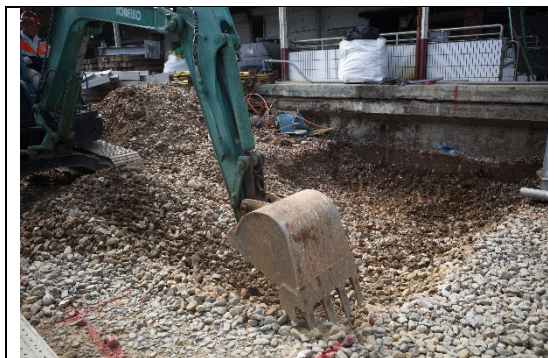
圖版72：臺鐵共構站體試掘坑位表土清除
