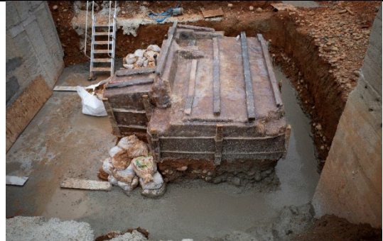
圖版21：硬面鋪設並將底座固定
