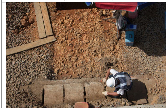
圖版74：臺鐵共構站體試掘坑中混凝土塊加蓋磚砌溝渠出露。
