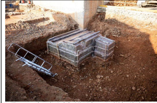
圖版18：包覆同時架設骨架，以增加強度
