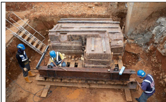
圖版30：架設及固定提樑於H型鋼架上
