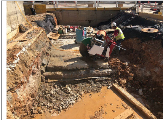
圖版6：盤鋸縱向切割
