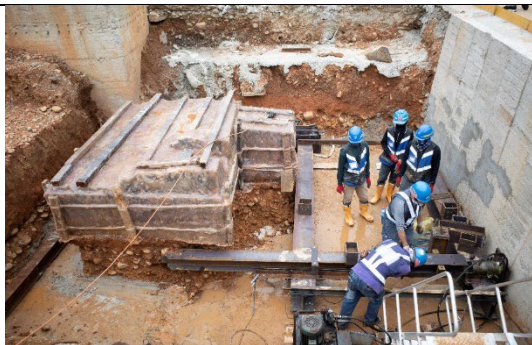
圖版24：以油壓致動器推進H型鋼軌作為遺構底部支撐
