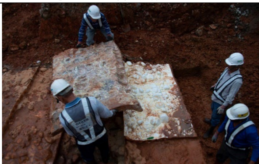
圖版41：拆模：玻璃纖維外模分離
