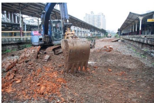
圖版54：第一、第二月臺硬面、道碴移除
