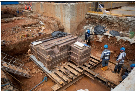
圖版26：完成全部H型鋼導入
