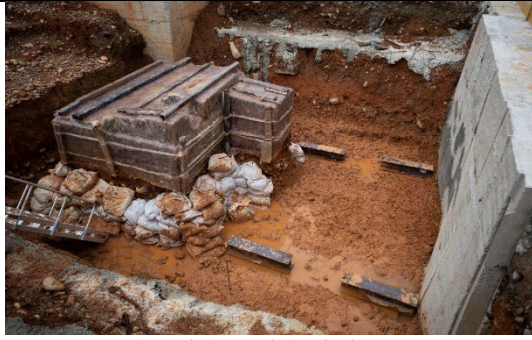
圖版20：放置底樑之支撐底座，另致動器後方也建置混凝土立牆，做為致動器推進時之壁擋。
