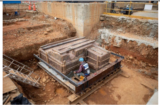
圖版29：縫隙填塞處再以水泥補實加固
