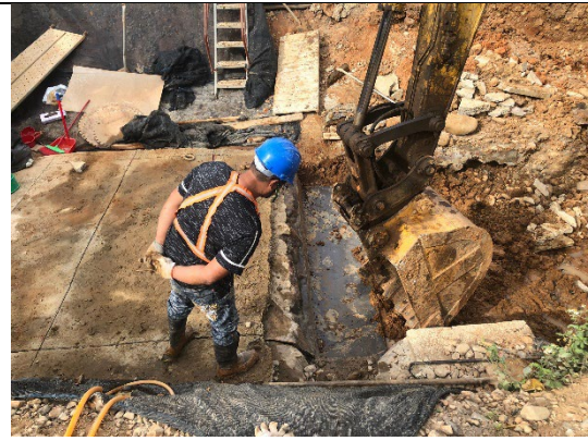
圖版7：以挖土機具將鐵板推入遺構下方
