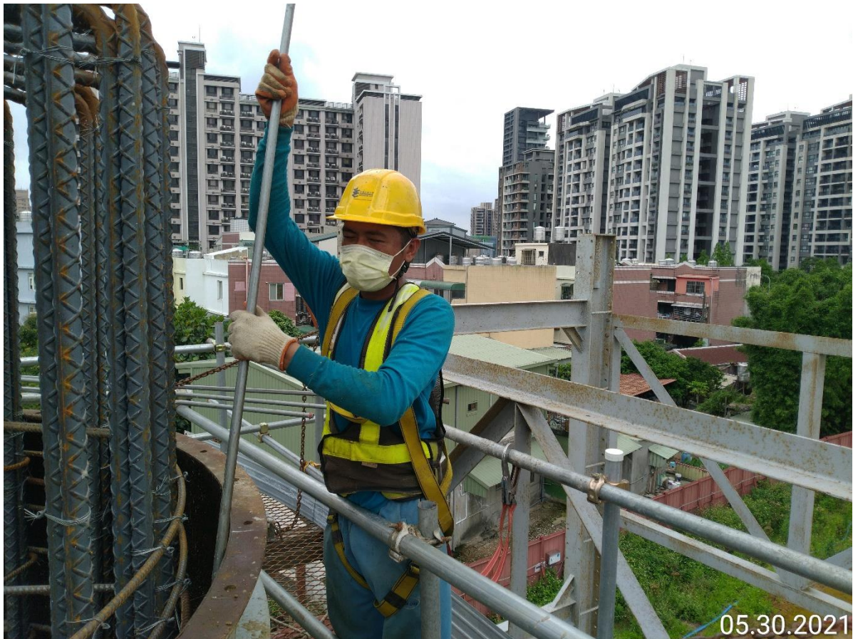
八德新闢道路 墩柱混凝土澆置搗實作業
