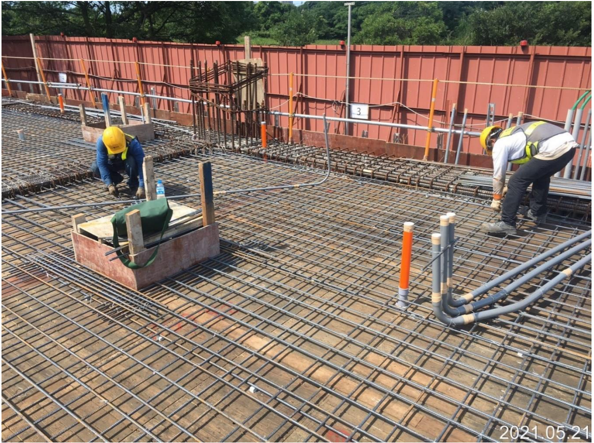
大園坑菓路 G32 車站出入口 1 樓版鋼筋綁紮
