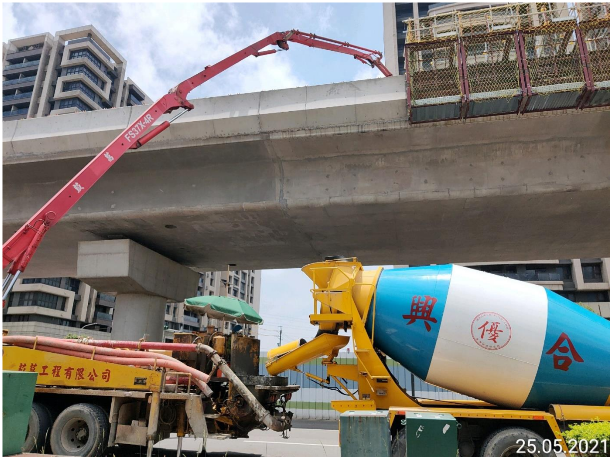
八德建德路 場鑄箱型梁橋面版胸牆混凝土澆置
