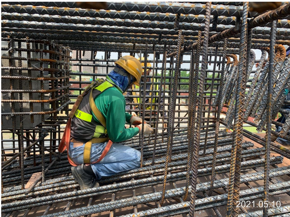
八德新闢道路 帽梁鋼筋綁紮
