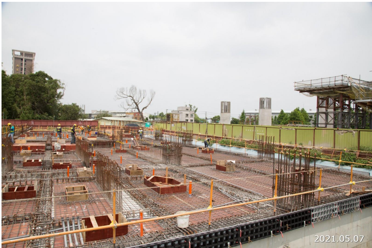
八德新闢道路 G02 車站出入口現況施作情形
