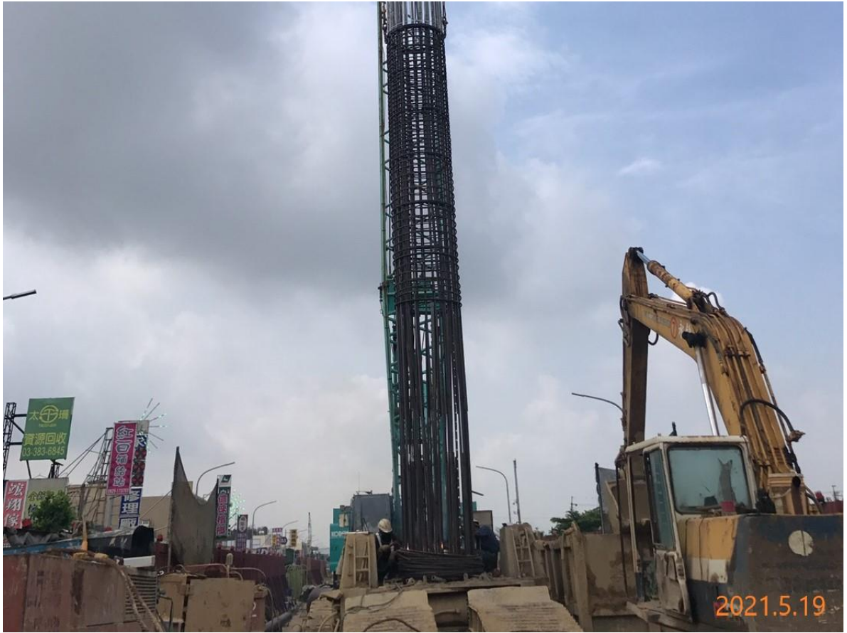
蘆竹三民路二段 基樁鋼筋搭接
