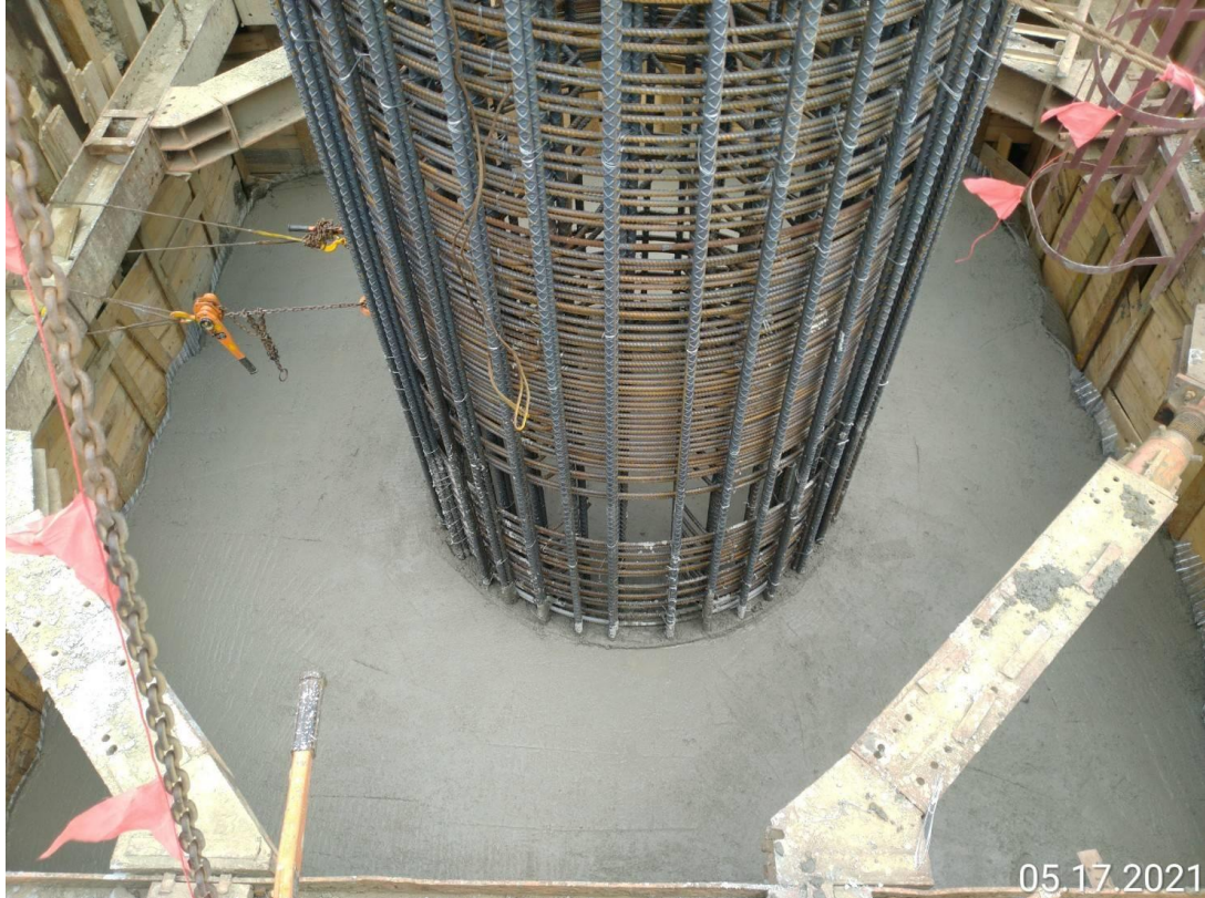
八德新闢道路 樁帽混凝土澆置完成
