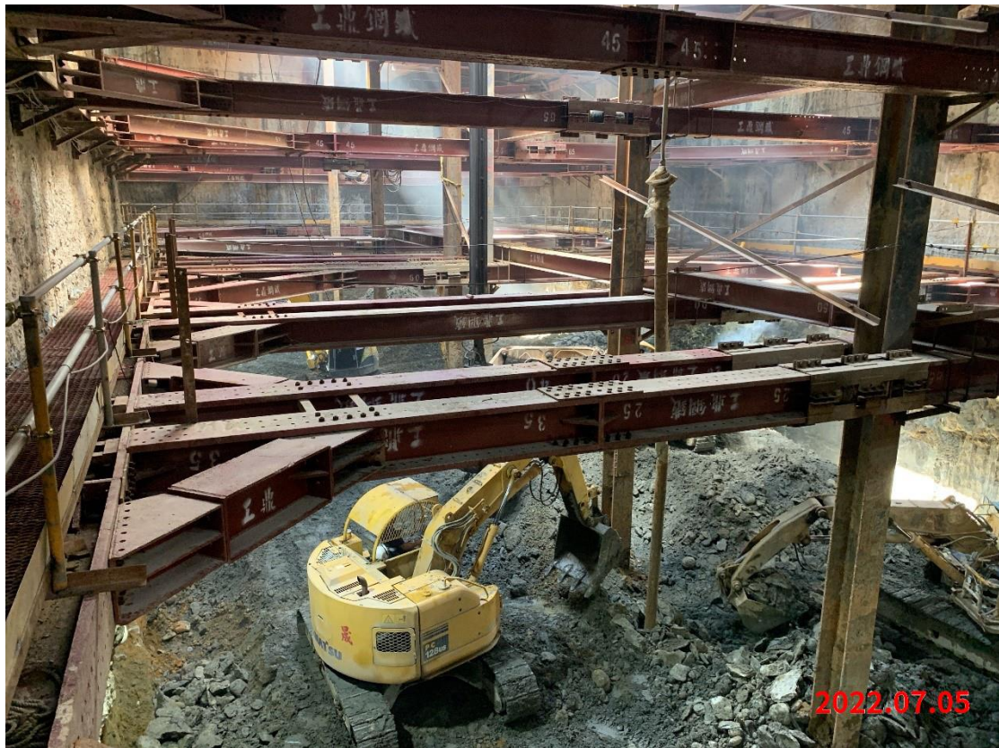
G11 站_站體第四層開挖
