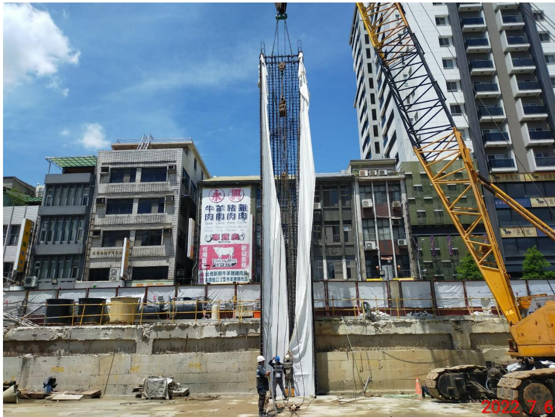
G08 站_站體擋土連續壁單元鋼筋籠吊放
