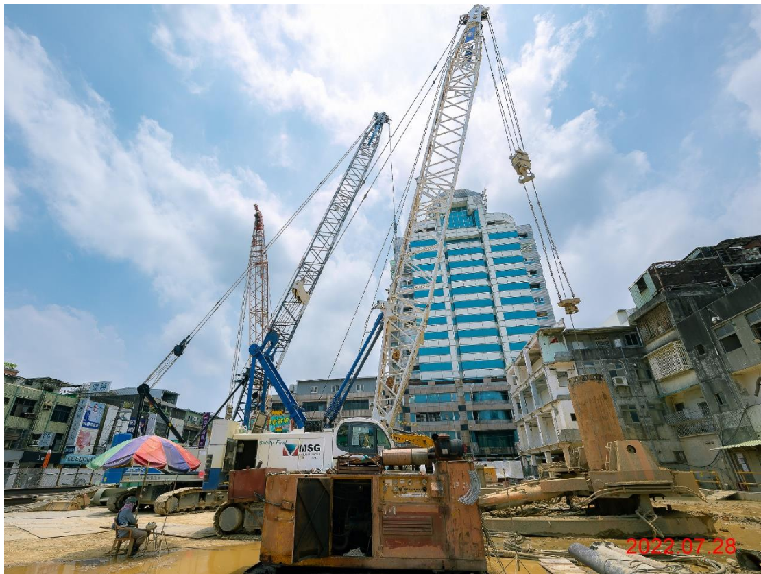
G09 站_中間樁抓掘
