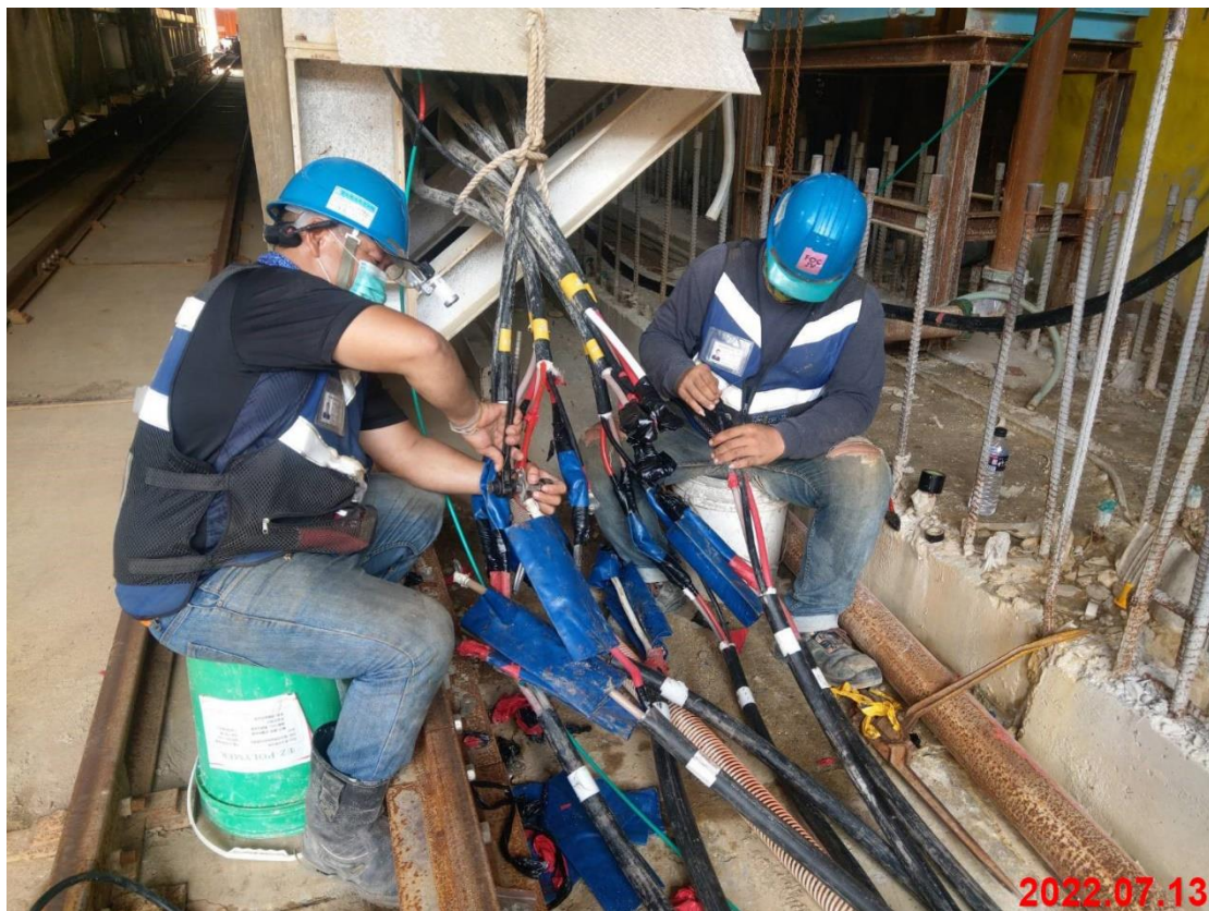
潛盾隧道_上行線台車電源線續接
