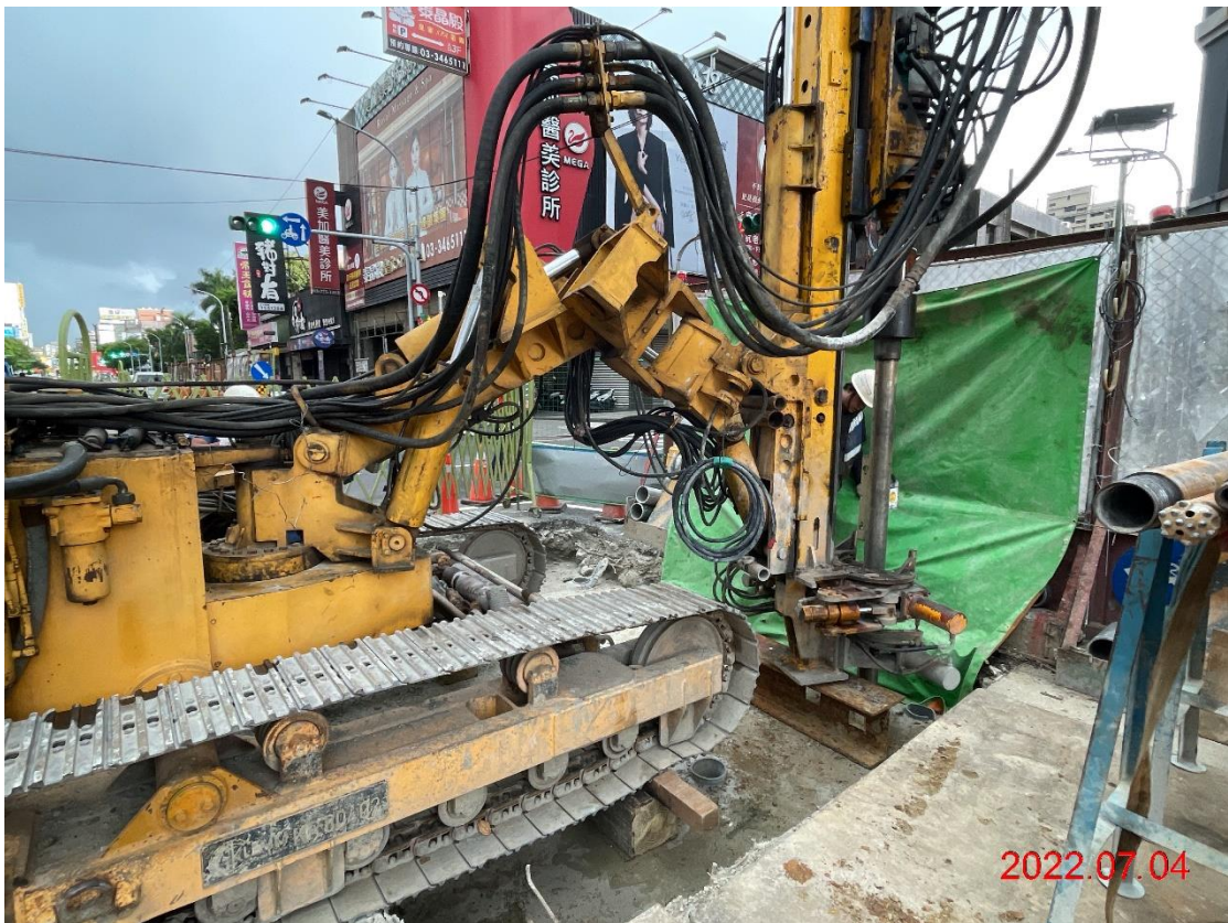
潛盾隧道_G10 南側隧道地改鑽孔作業
