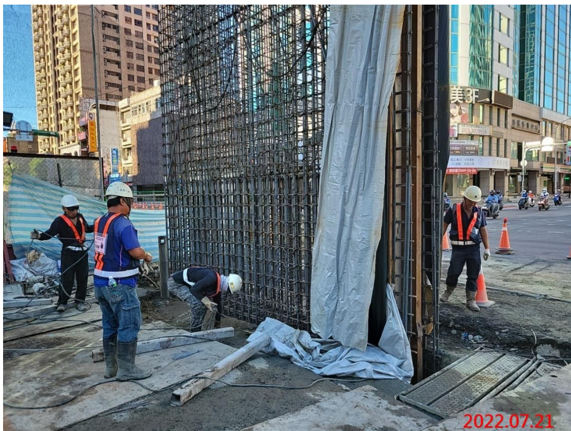
G10 站_站體擋土連續壁單元鋼筋籠吊放
