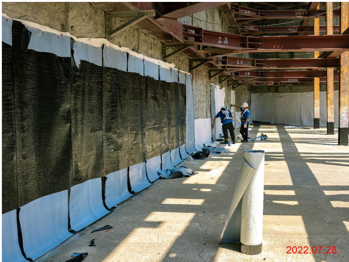
G12 站_站體防水膜施作
