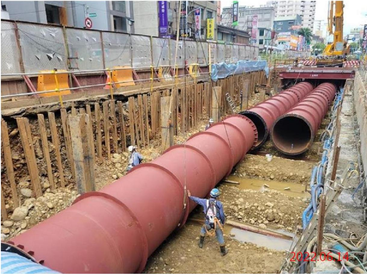
G10 站\_臨時排水鋼管施工
